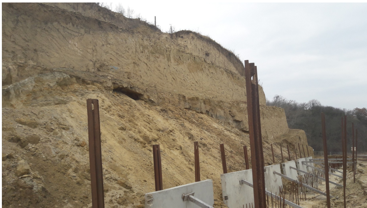
Obr. 3: Nestabilní hrubozrnné náplavy výplavového kužele (ČSN 76 6133 S2 SP). Stavební jáma odvodnění SO 301 bude pažena za pomoci HEB, HEB s pažinami budou sloužit jako ochrana během betonáže ŽB zdi SO 202.3
