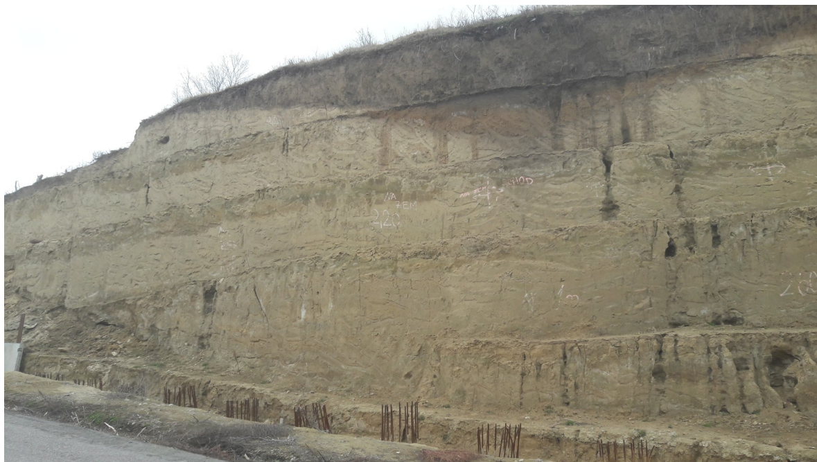
Obr. 1: Pohled na zterasovný svah ve spraši. Jsou zde dobře patrné výsledky ronové eroze. V patě svahu jsou stávající ŽB piloty.
