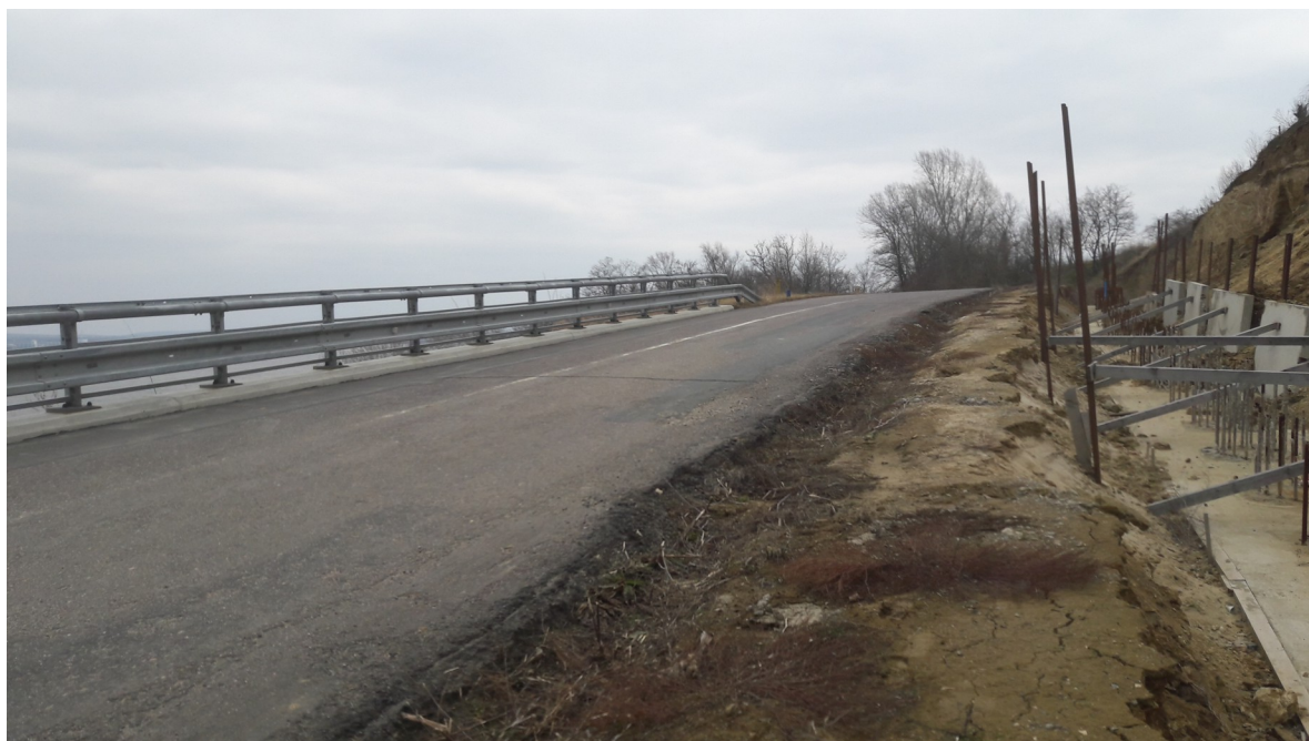
Obr. 2: pohled na stavební výkop pro realizaci pilot a realizovaný okraj kotvené mikropilotové stěny, skrz silnici bude budováno odvodnění SO 301
