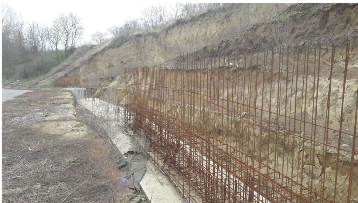
Obr. 4: Realizovaná část ŽB trémové převázky (vzadu) a vyskládaná výztuž (směrem k Pavlovu). Vertikální výztuž bude zkrácena na výšku podle projektu a doplněna.
