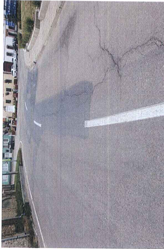
Pohled na úsek; široké podélné a příčné trhliny
