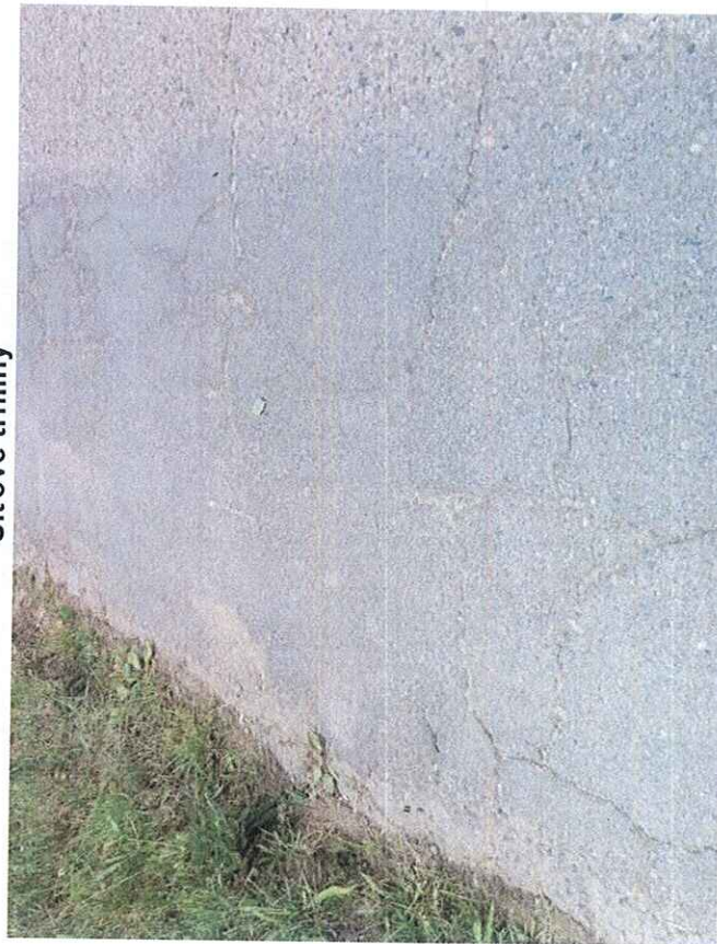
Síťové trhliny
