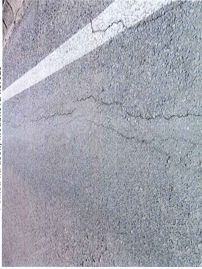
Rozvětvené podélné trhliny
