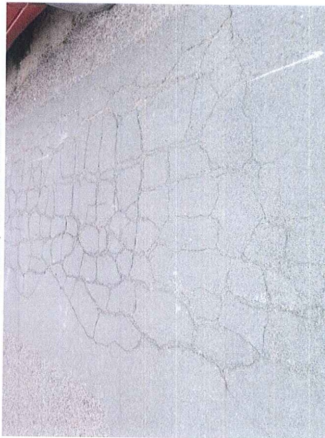
Síťové trhliny
