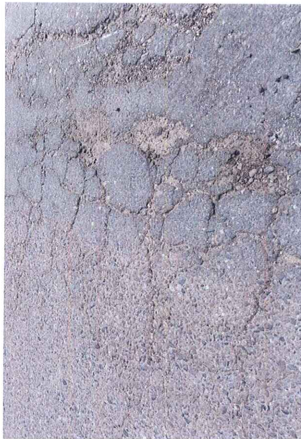
Sítové trhliny; výtluky
