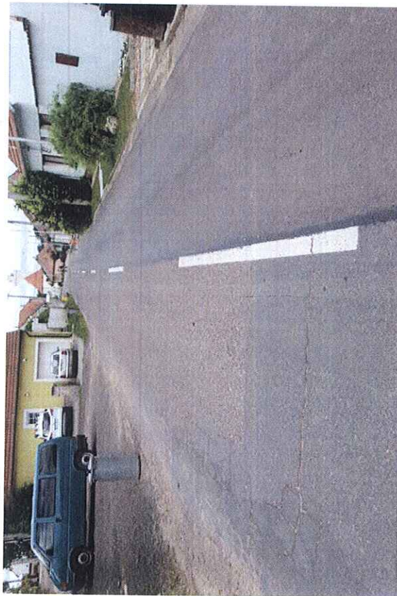
Široká příčná trhлина; Síťové trhliny; hloubková koroze
