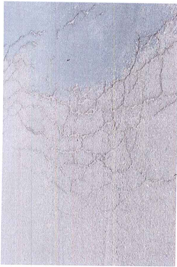
Síťové trhliny
