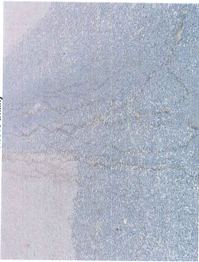
Rozvětvené podélné trhliny
