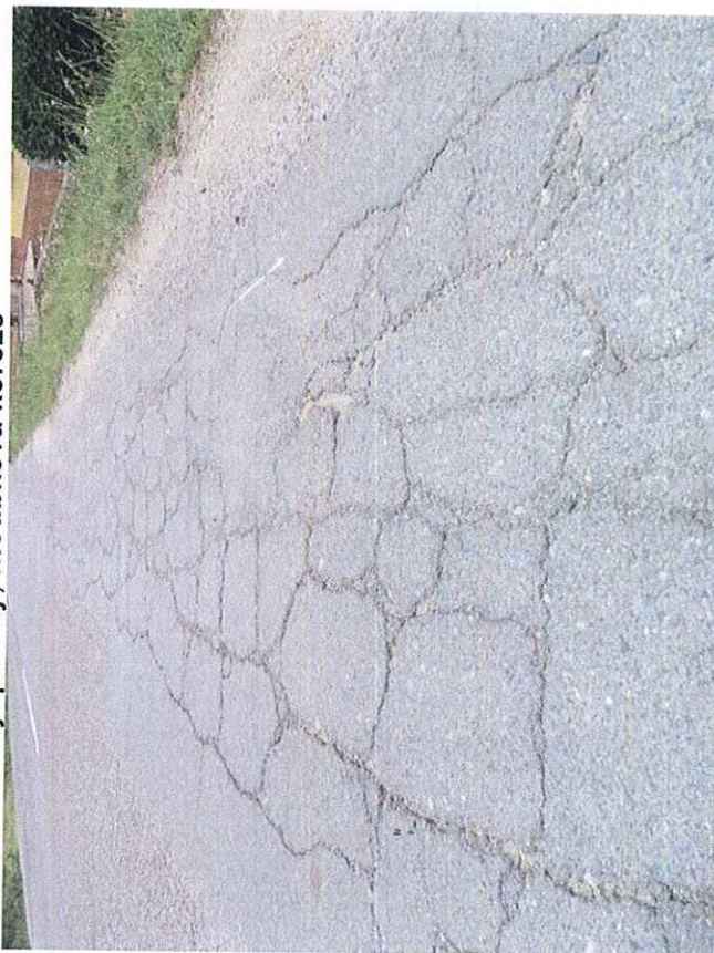
Síťové trhliny
