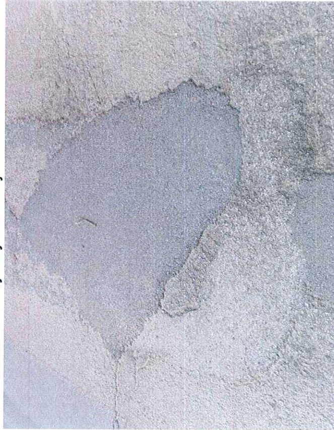
Vysprávka s výtluky a trhlinami
