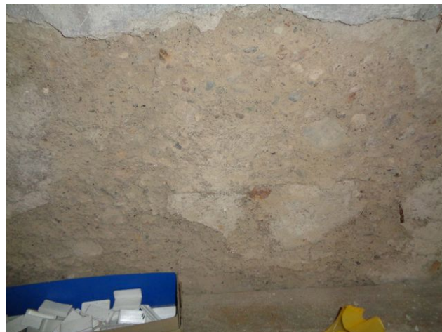
foto/3/ Pohled na opadanou omítku na obvodové stěně
