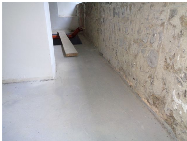
foto/24/ Pohled na nově realizovanou podlahu v opraveném místě suterénu
