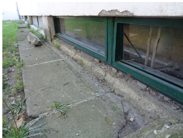
foto/9/ Pohled na stav zdiva v místě parapetu a ostění suterénního okna
