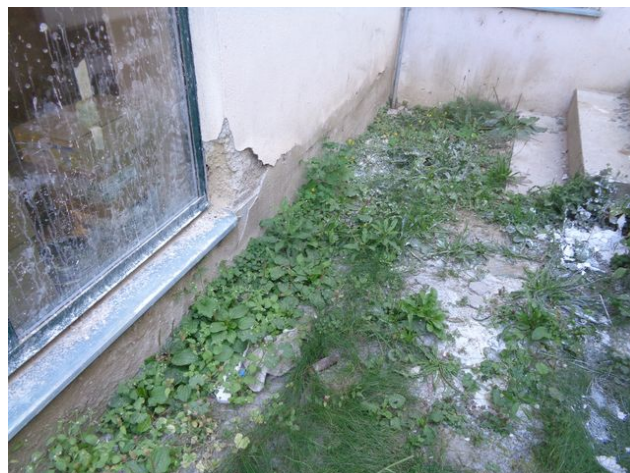
foto/15/ Pohled na opadávající omítku a vlhkostní poruchy na fasádě v soklové části objektu
