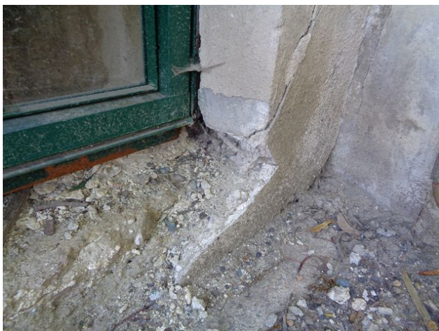
foto/8/ Pohled na stav zdiva v místě parapetu suterénního okna
