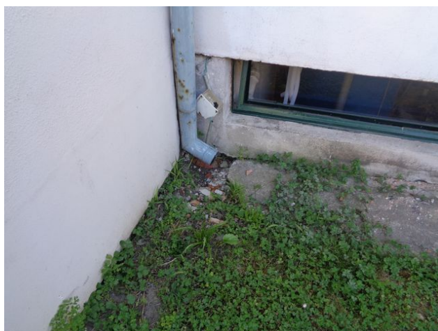
foto/18/ Pohled na svod vyústěný u obvodové stěny objektu
