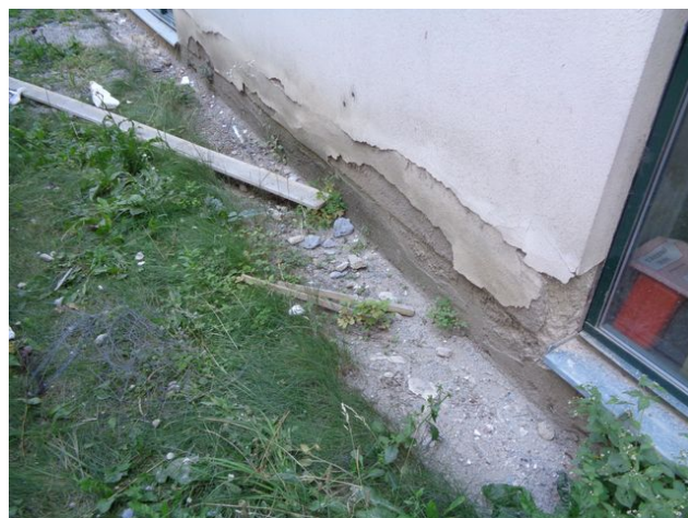
foto/17/ Pohled na opadávající omítku a vlhkostní poruchy na fasádě v soklové části objektu
