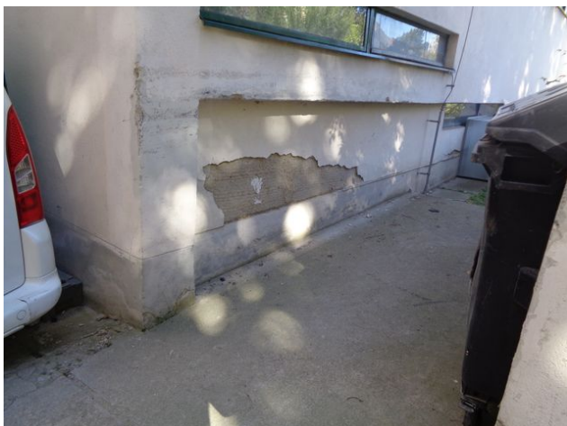
foto/10/ Pohled na opadávající omítku v soklové části objektu
