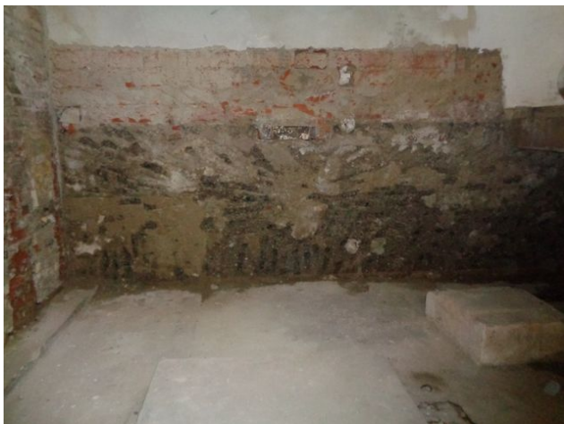
foto/27/ Pohled na vlhkou stěnu v místě snížení podlahy
