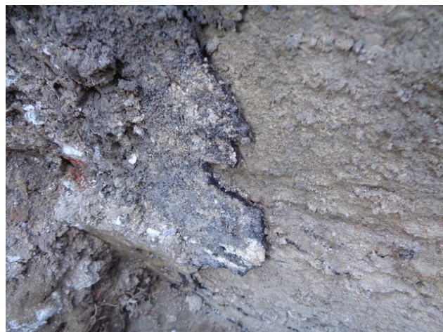
foto/32/ Pohled na asfaltový hydroizolační pás
