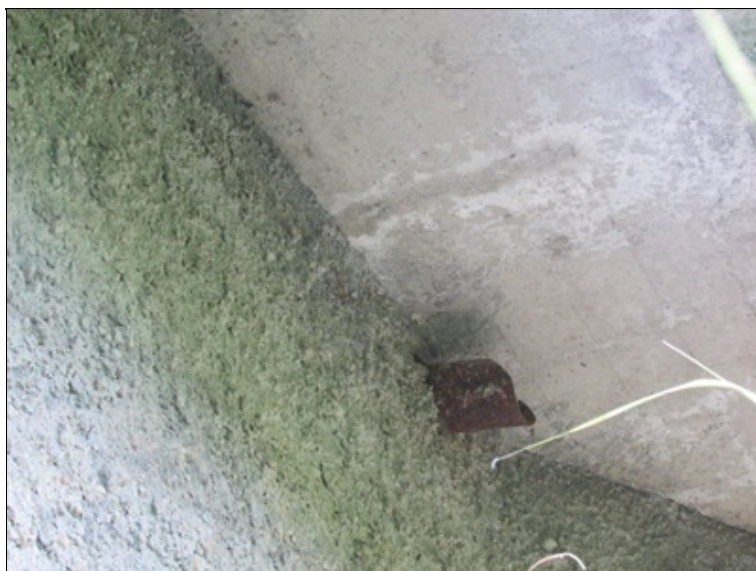
Koroze odvodňovací trubičky
