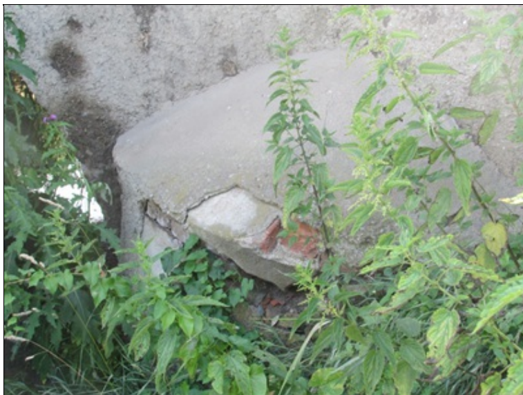
Rozpad cihelného bloku u pravého křídla opěry 2
