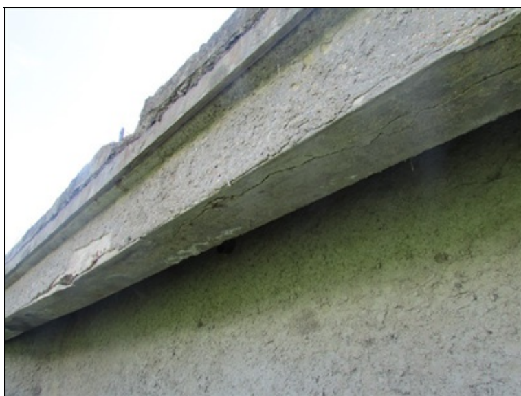
Trhliny na spodním líci pravého krajního trámu
