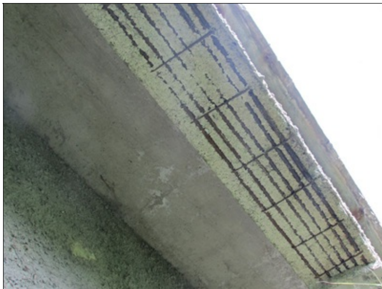
Odprýsknutý beton a obnažená výztuž v podhledu levého krajního trámu
