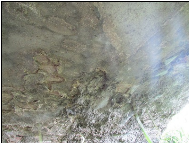
Opadaná omítka v pohledu klenby, stopy po průsacích
