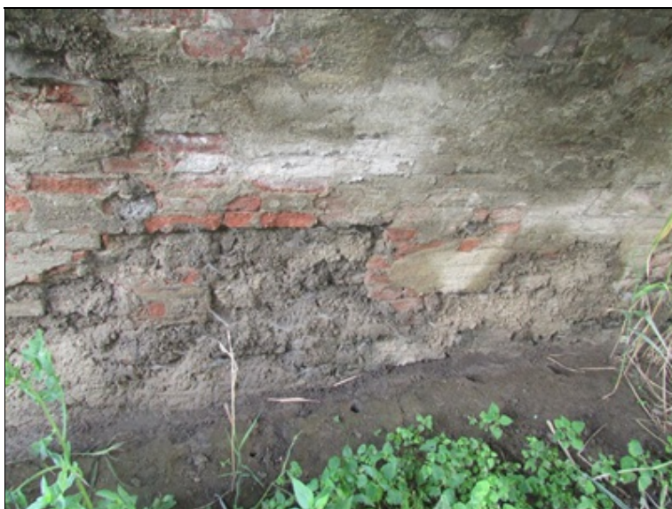
Stopy po průsacích v lici opěry, vypadené cihly ve zdivu zapraveny nekvalitně maltou
