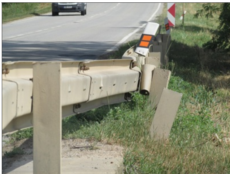
Deformace levého svodidla
