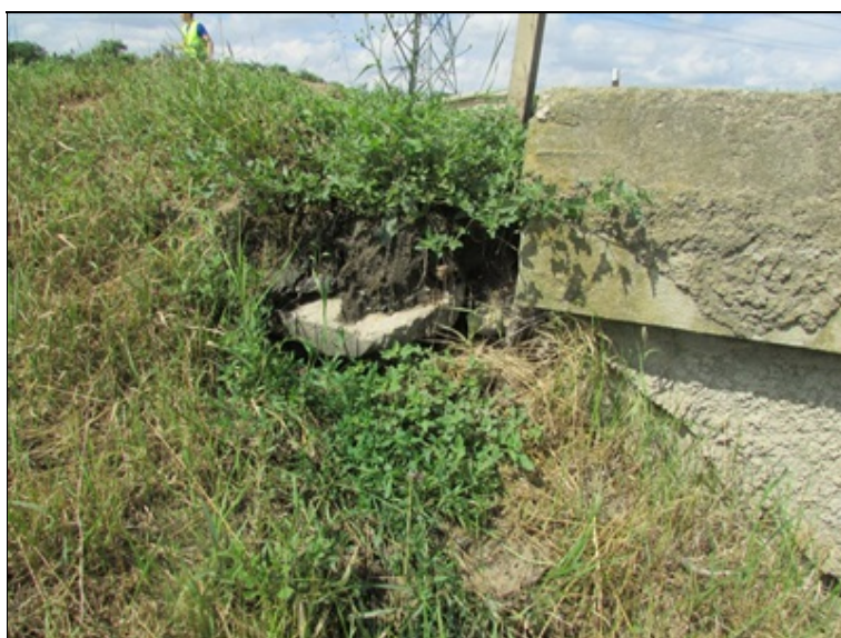
Vymletý svah u levého křídla opěry 2
