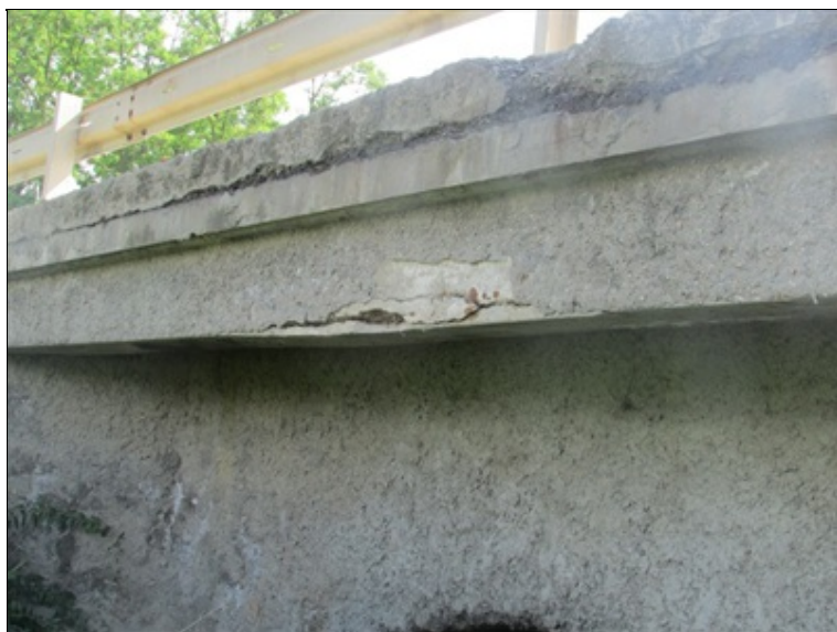
Održený spodní líc pravého krajního trámu, degradace pravé římsy
