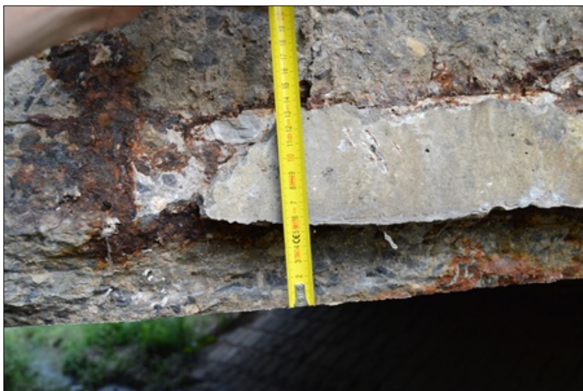
14-Poloha kabelů na boku nosníku.JPG
