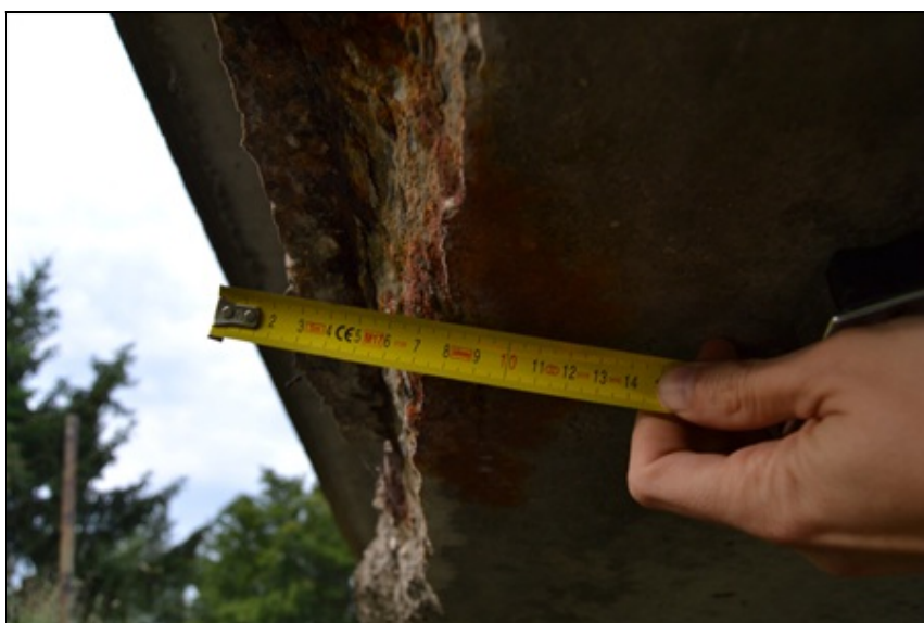
15-Rozsah odpadlého betonu v příčném směru cca 70-80 mm.JPG
