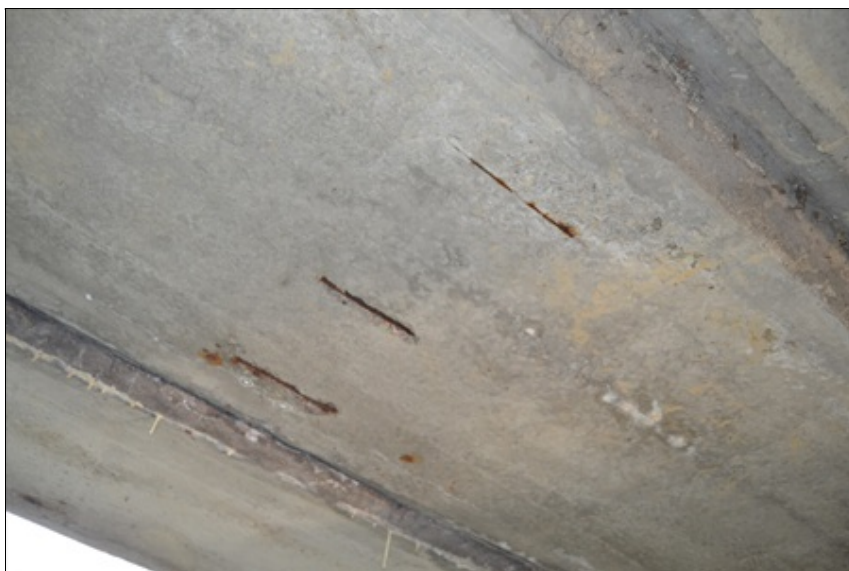
23-Koroze konstrukční výztuže na podhledu 2.nosníku zleva stopy po zatékání.JPG
