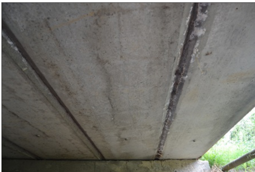
20-Podhled NK zatékání mezi krajními nosníky.JPG
