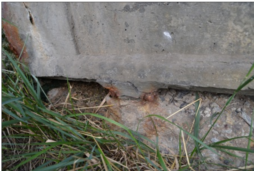
07-Rozpad úložného prahu koroze výztuže v místě uložení.JPG
