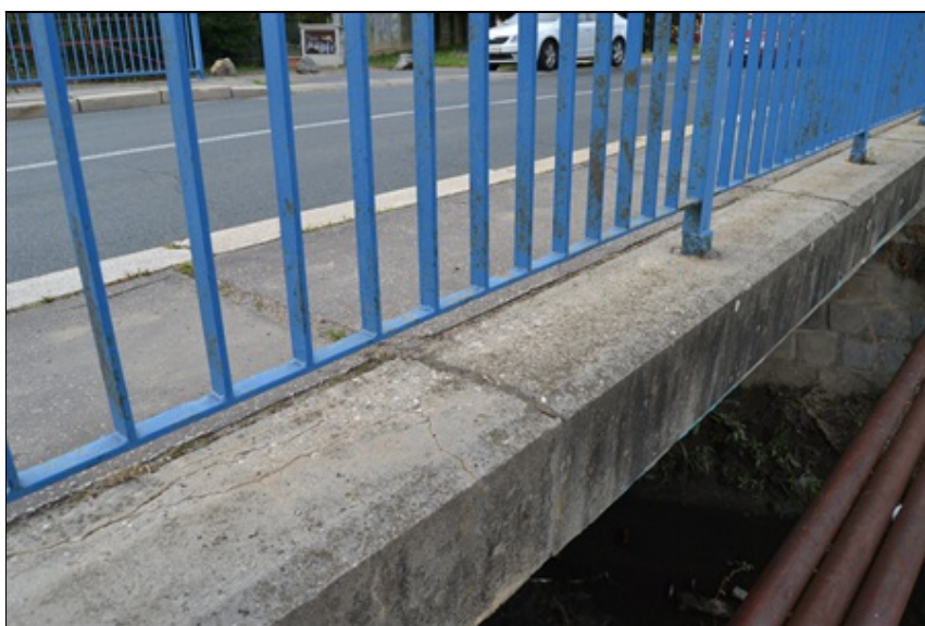
27-Degradace římsy koroze zábradlí.JPG
