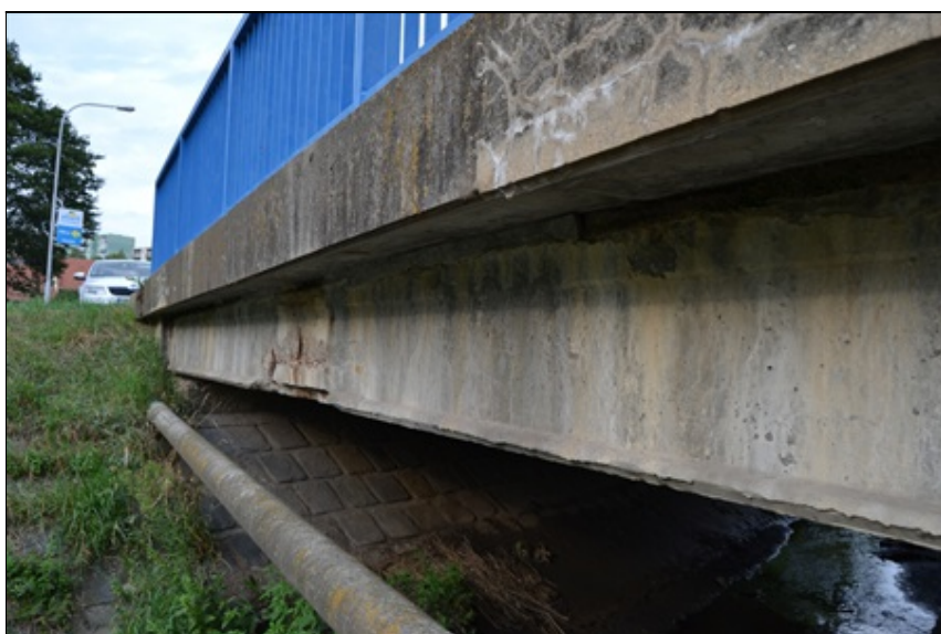
09-Trhliny na říkse rozpad krytí nosníku cca uprostřed rozpětí.JPG
