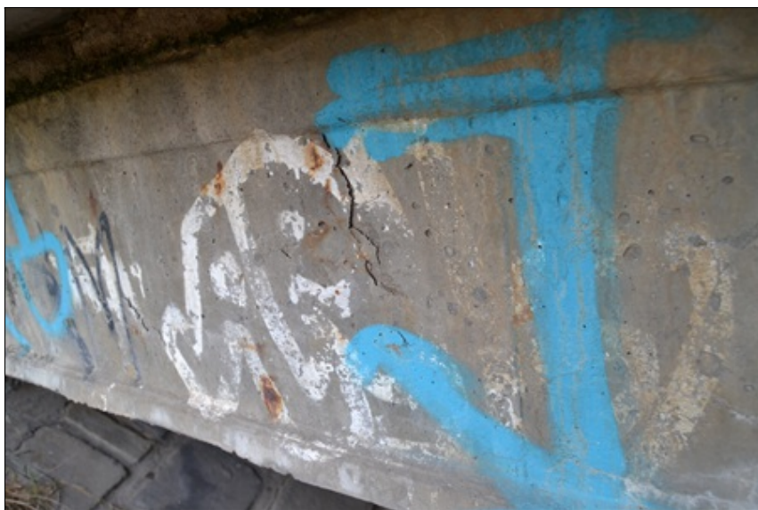
17-Koroze výztuže na boku nosníku vlevo koroze způsobuje odprýsknutí krytí.JPG
