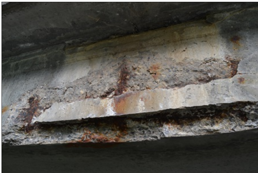
10-Odlomená hrana nosníku odpadlý beton na boku nosníku vpravo.JPG
