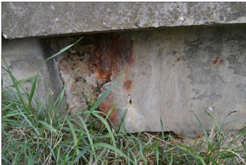
16-Koroze kotev předpínací výztuže zatékání na konce nosníků.JPG
