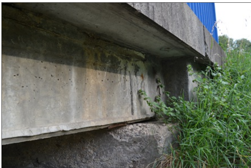
08-Zatékání na NK pod římsami rozpad úložného prahu.JPG
