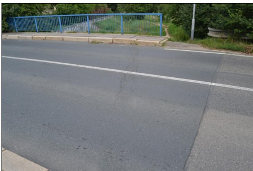
30-Trhliny ve vozovce nad závěrem u OP2.JPG
