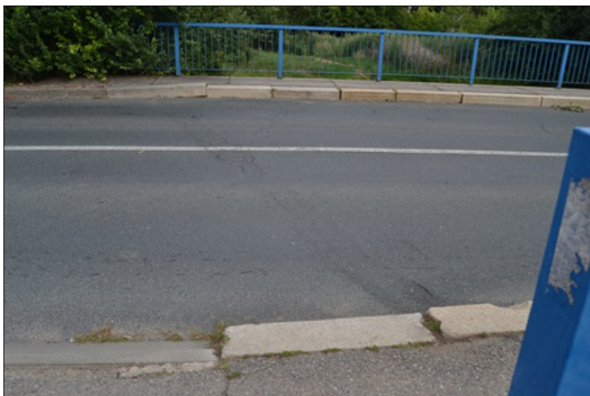
29-Trhliny ve vozovce nad závěrem u OP1.JPG
