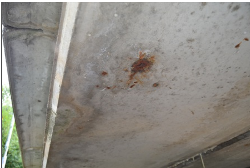
25-Korozní produkty na podhledu.JPG
