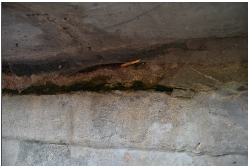
19-Nadbetonovaná deska nad nosníkem degradace.JPG
