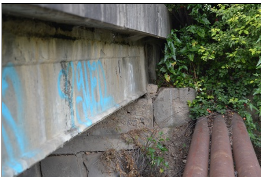
18-Nadbetonávka nad NK protékání degradovaný úložný prah.JPG
