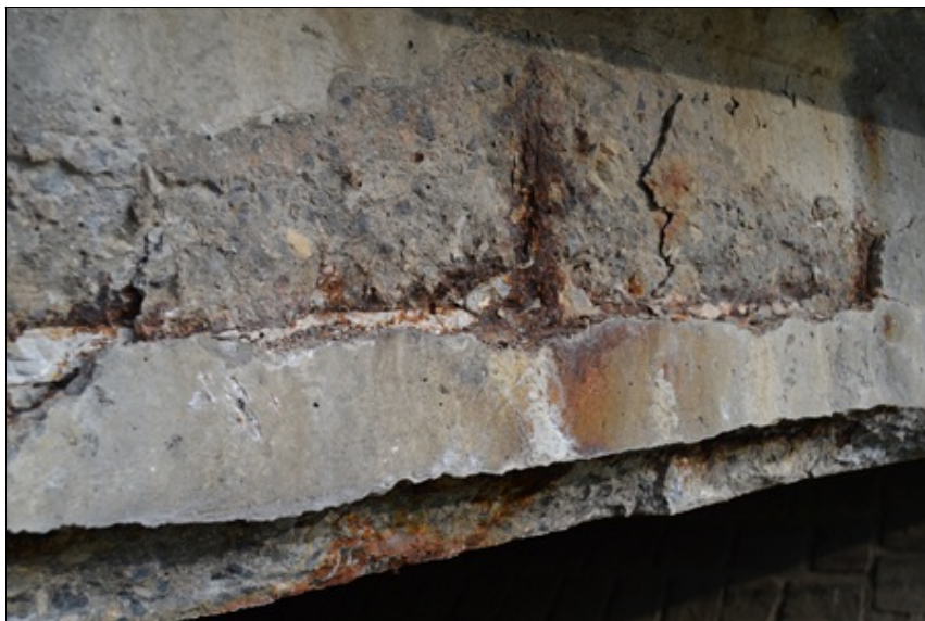
13-Koroze výztuže nosníku.JPG
