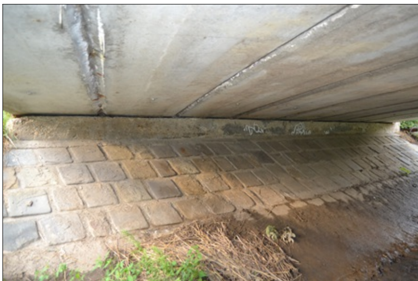
05-Pohled na opěru OP1 a opevnění svahu.JPG
