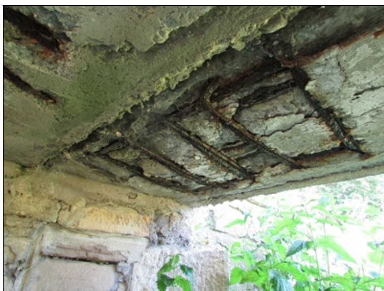
Podhled NK - koroze výztuže
