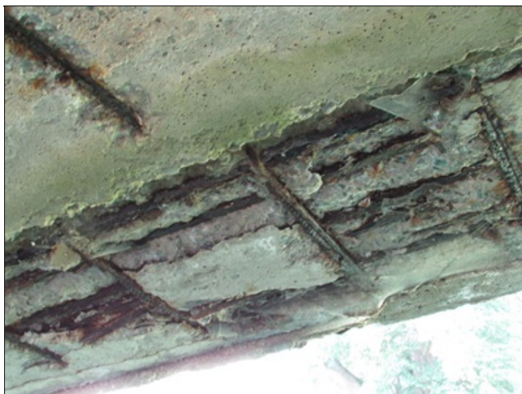
Podhled NK - koroze výztuže
