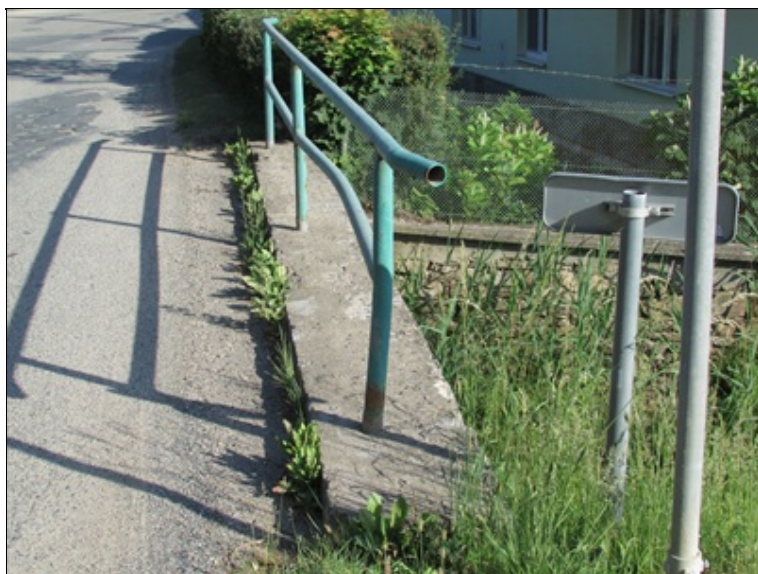
Zanesená krajnice a deformace zábradlí
