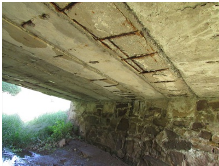
Podhled NK - koroze výztuže
