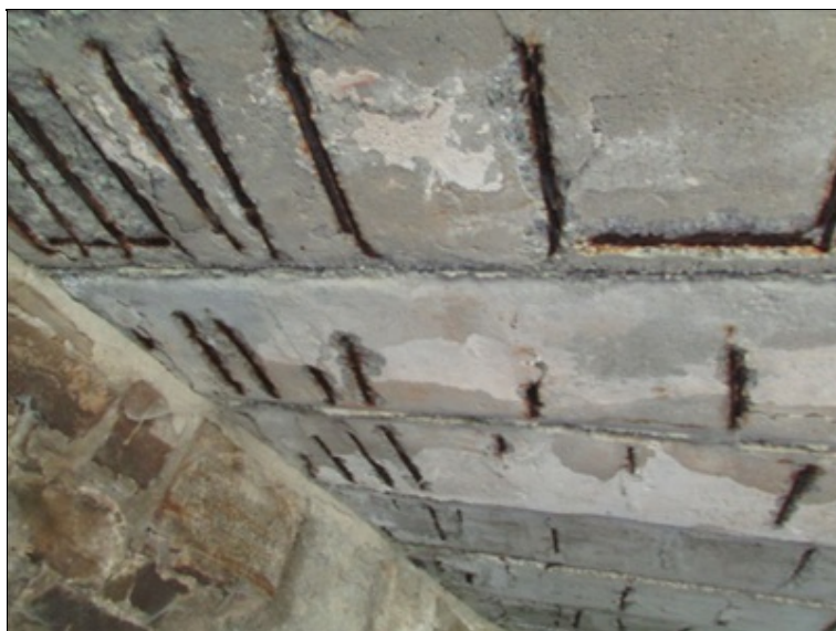
Podhled NK - koroze výztuže
