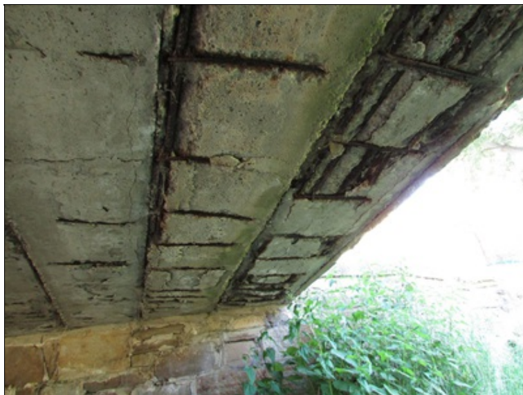
Podhled NK - koroze výztuže
