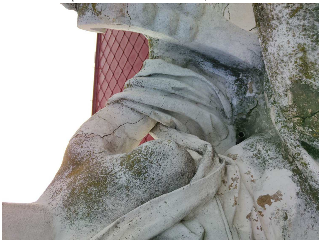
Detail prasklin a poškození pravá socha.
