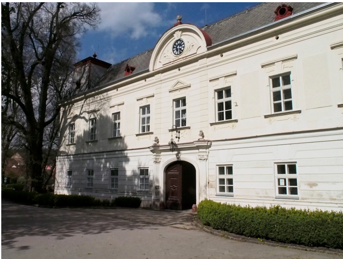
Pohled na západní průčelí objektu.
