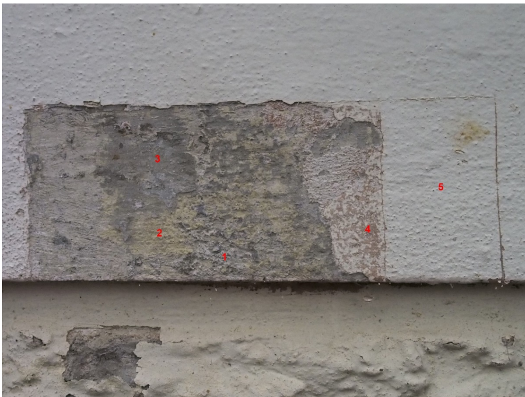
Fasáda severozápadního průčelí. 1 – vrchní omítková vrstva, 2 – nejstarší barevný nátěr, 3, 4 – mladší barevné nátěry, 5 – současný barevný nátěr.
