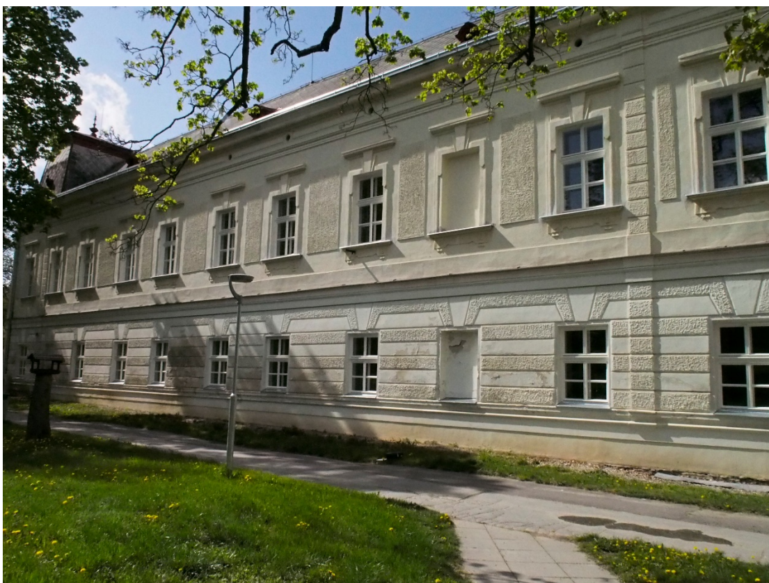
Pohled na jižní průčelí objektu.
