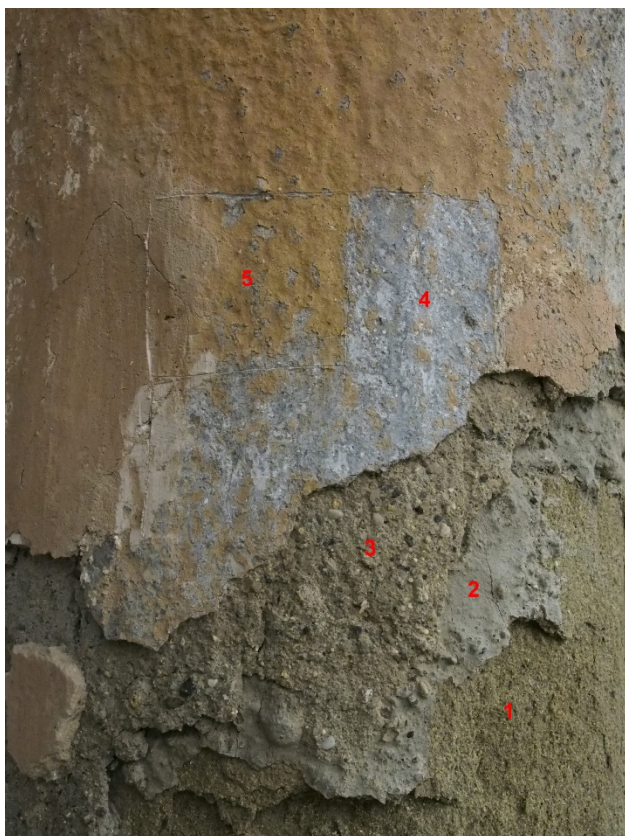
Sonda. 1 – kámen, 2 - 3 – omítkové vrstvy, 4 – nejstarší barevný nátěr v odstínu šedé, 5 – mladší barevný nátěr v odstínu okru.
