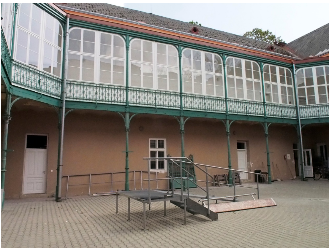
Pohled na dvorní jižní průčelí objektu.
