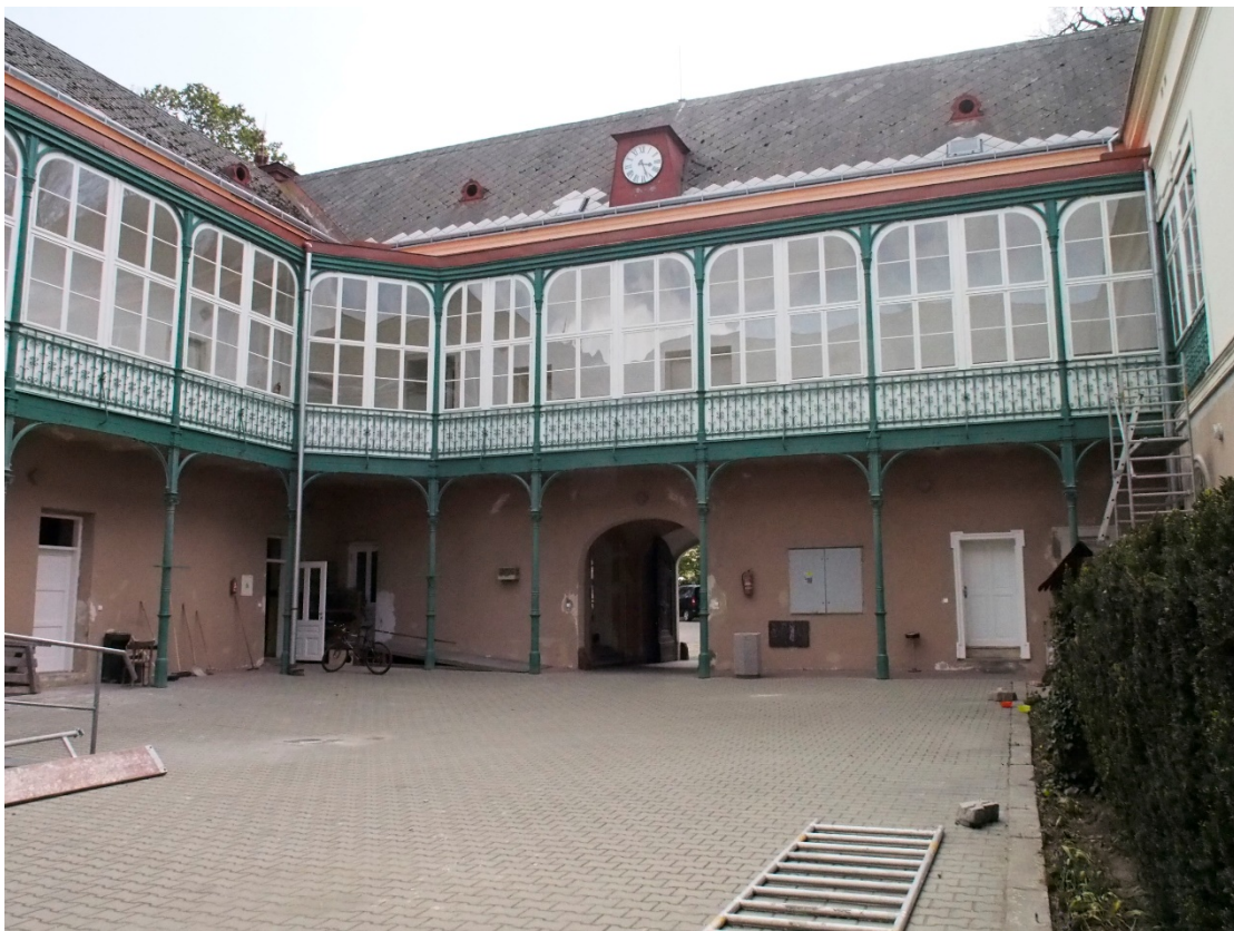
Pohled na dvorní západní průčelí objektu.
