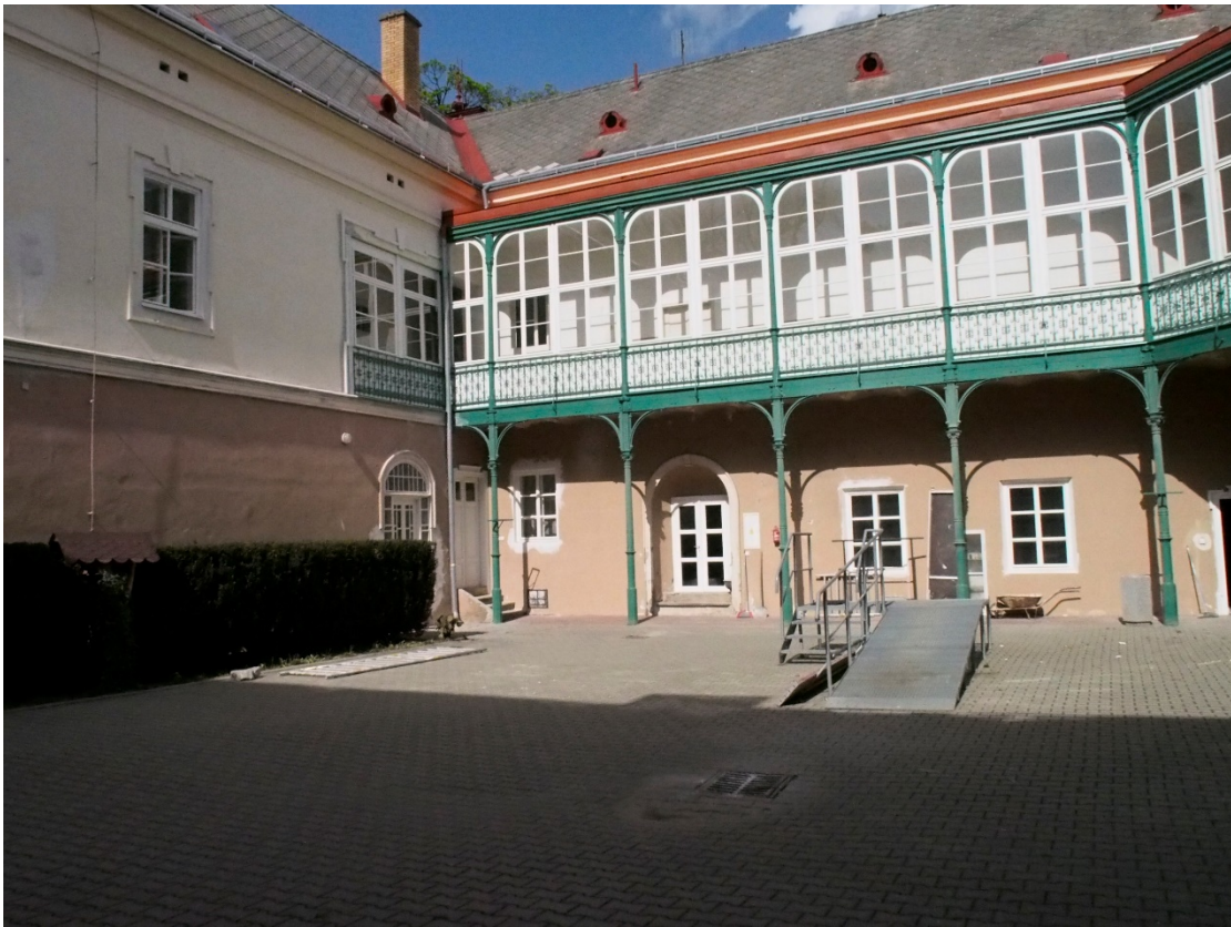
Pohled na dvorní východní průčelí objektu.
