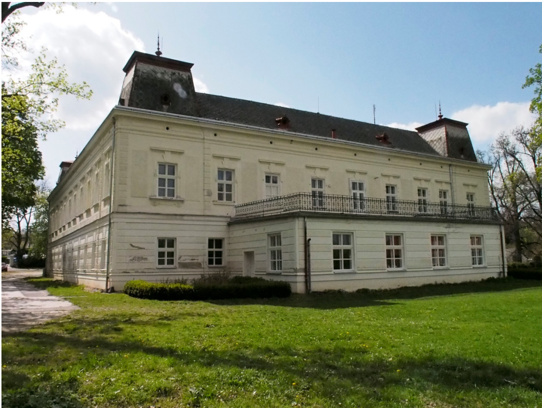
Pohled na východní průčelí objektu.
