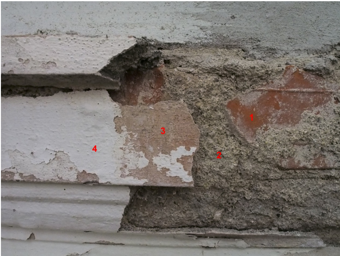
Fasáda severovýchodního průčelí. 1 – zdivo, 2 – jádrová omítková vrstva, 3 – nejstarší barevný nátěr, 4 – současný barevný nátěr.
