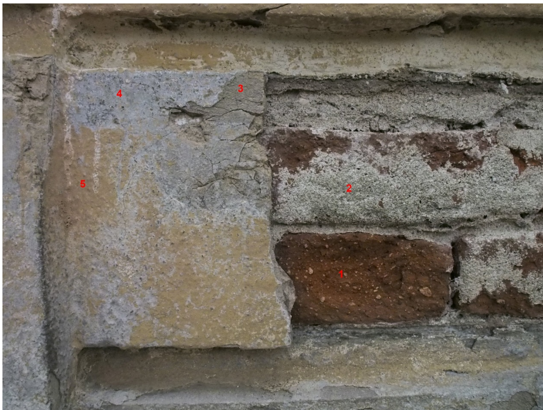
1 – zdivo, 2 jádrová omítková vrstva, 3 – vrchní omítková vrstva, 4 – nejstarší barevný nátěr v odstínu šedé, 5 – mladší barevný nátěr v odstínu okru.
