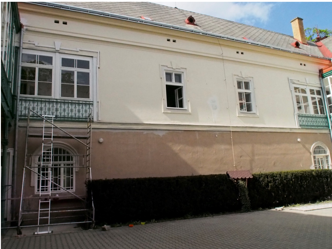
Pohled na dvorní severní průčelí objektu.
