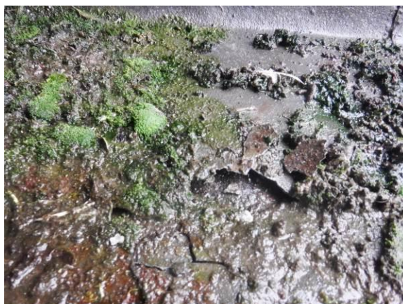
Foto č. 16: Rozpad krytiny.
