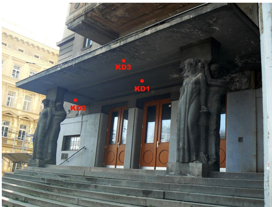
Obr. 5 Rozmístění sond na spodním líci konstrukce stříšky nad vchodem z ulice Kounicovy v 1. NP
