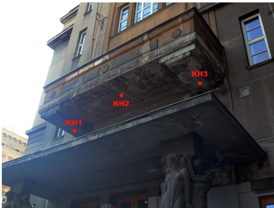
Obr. 6 Rozmístění sond na spodním líci balkonu ve 2. NP. V totožných místech byly provedeny sondy z horního líce balkonové desky.
