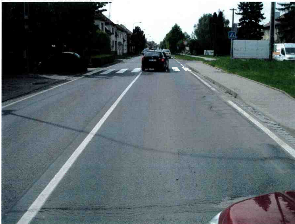
F38, km 49,150+ Vyjeté koleje, příčné trhliny rozvětvené. Vlevo opravený povrch.
