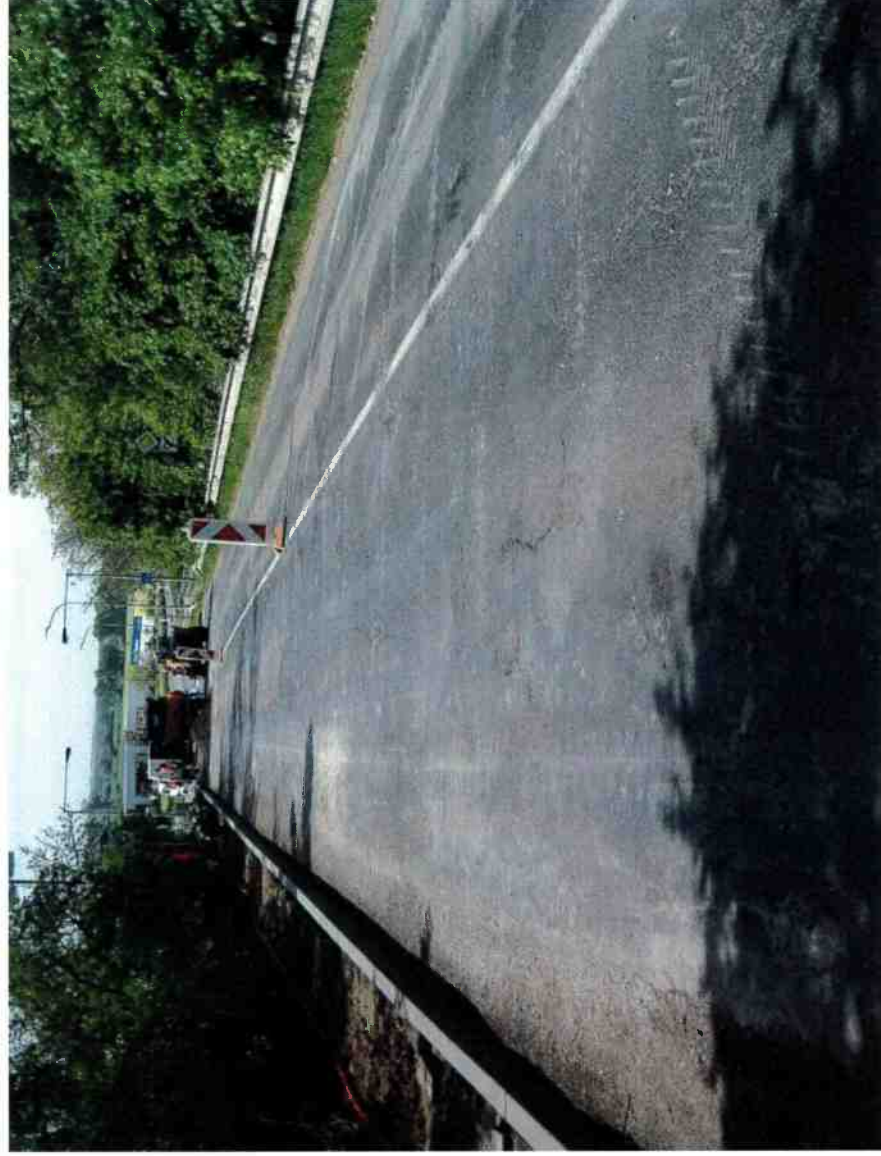
F07, km 0,025+ Síťové trhlíny, většina povrchu překryta vysprávkami.
