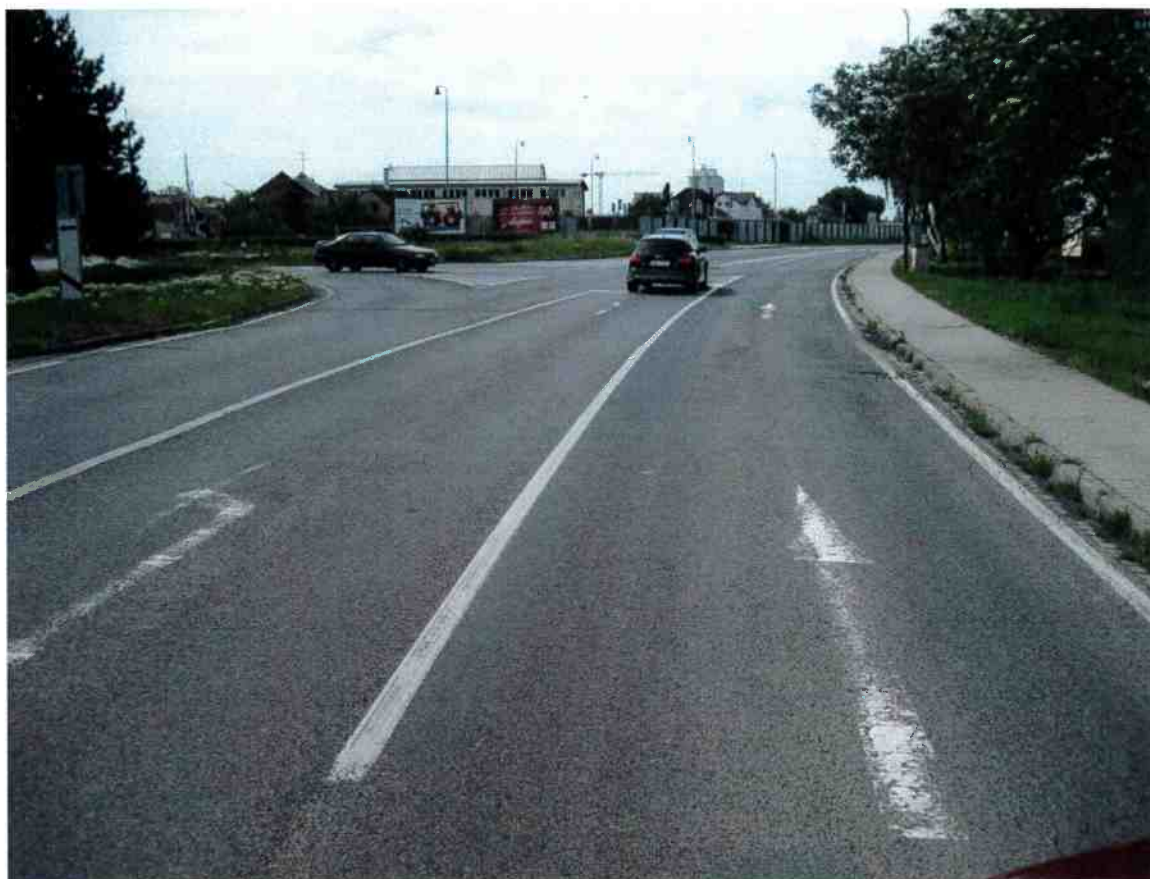
F44, km 49,450+ Ztráta asfaltového tmelu.
