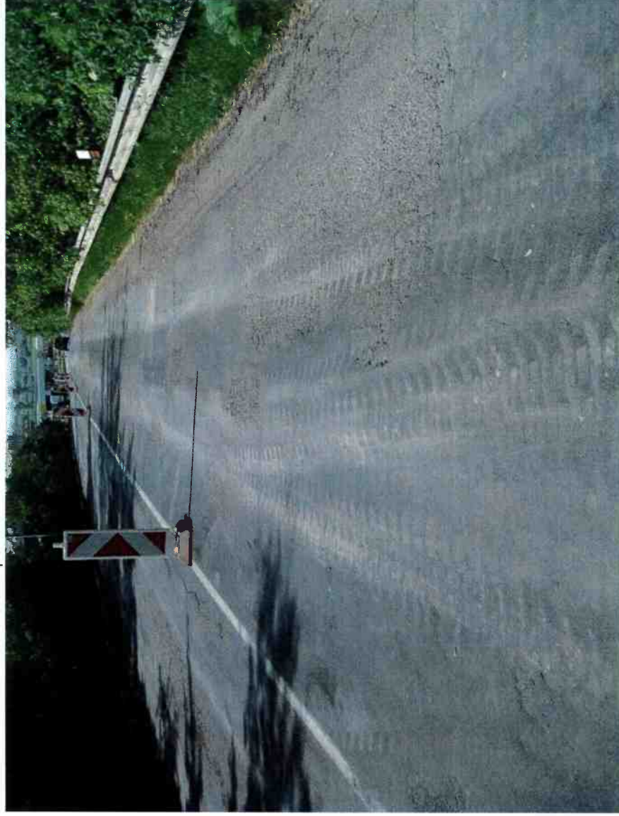
F03, km 0,025+ Síťové trhlíny, většina povrchu překryta vysprávkami.
