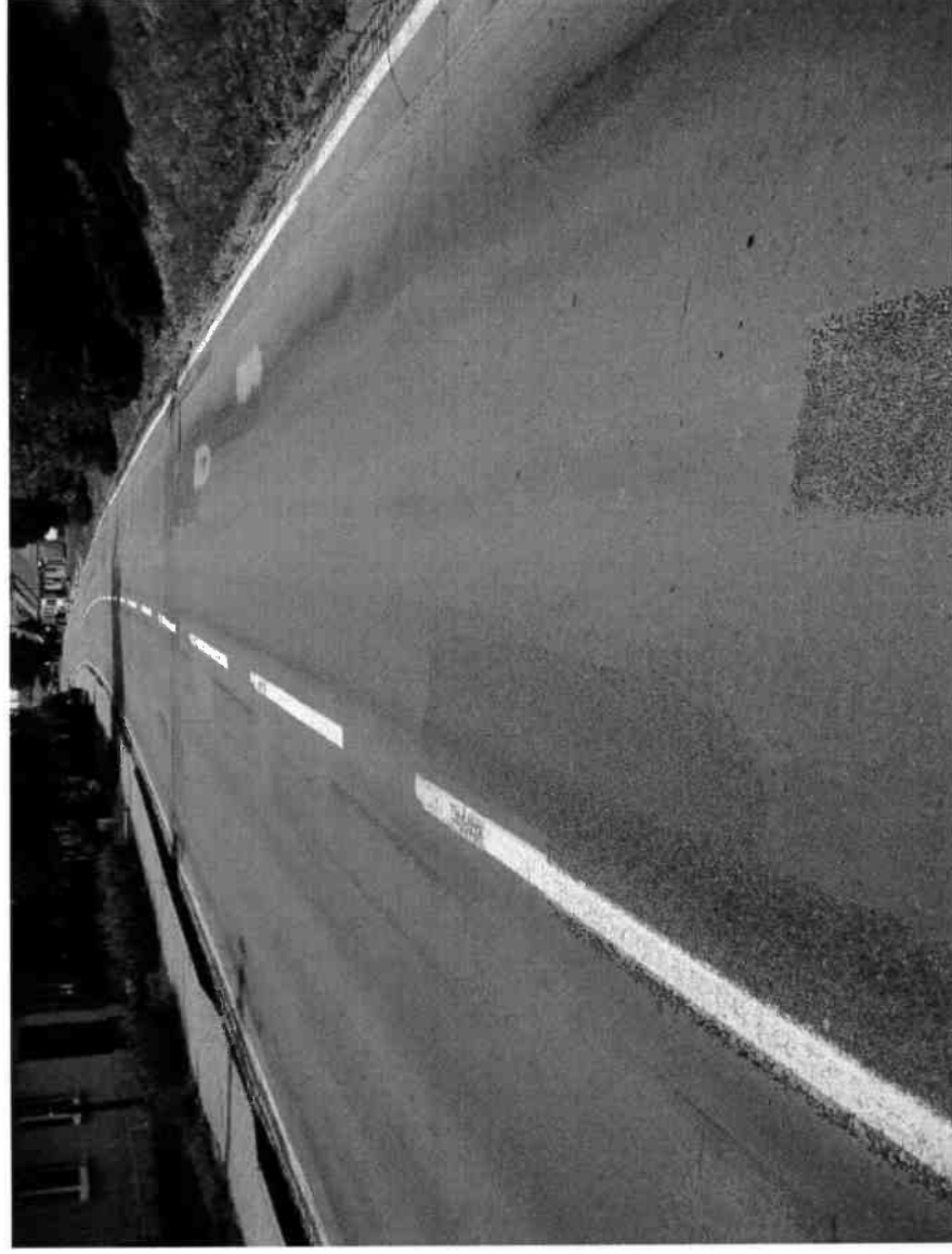
F18, km 8,150+ Síťové trhliny.
