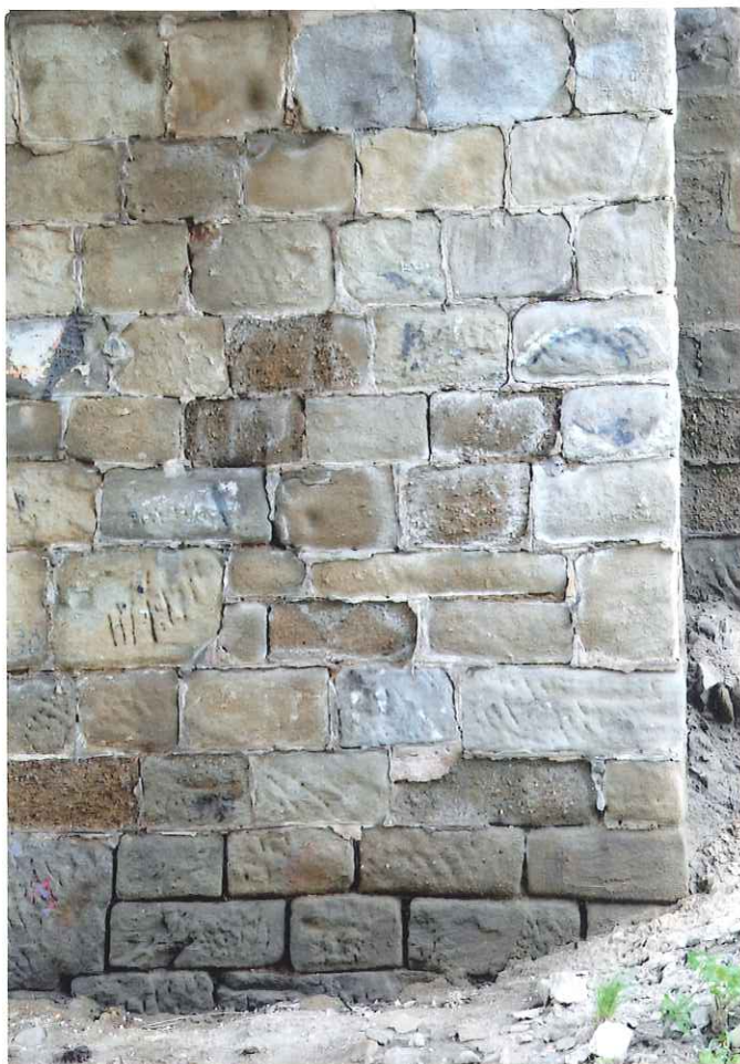
Obr.B57-031 Pravý konec 2. opěry a nalevo od něj přední stěna polosloupu před napojením přilehlého křídla. Pohled k Vyškovu, - trhliny a vyprázdnění spár ve zdivu.
