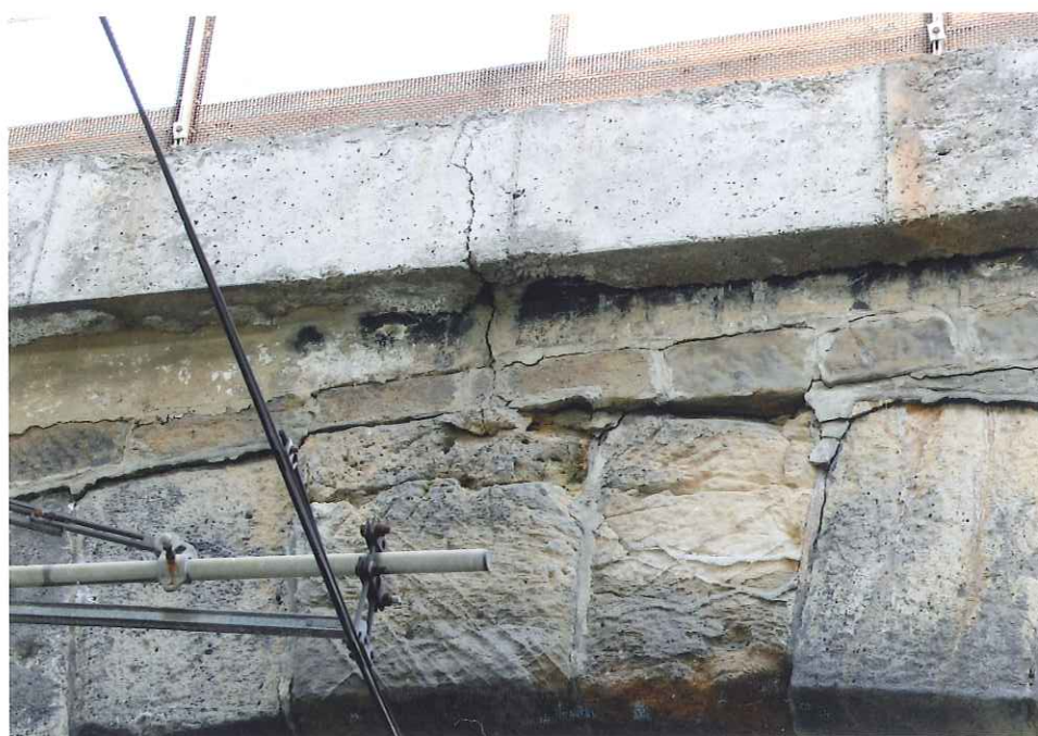
Obr.B57-022 Fasáda/čelní zeď nad pravým čelem klenby v jejím vrcholu. Pohled k Nezamyslicím a vzhůru, - čelní zeď je vysunuta tlakem přesypávky směrem k Brnu o asi 18 mm, - v novější masivní betonové římse vznikla následkem dilatačních pohybů klenby trhлина max. šířkay 6 mm. Na nezamyslické straně podobná trhлина nevznikla.
