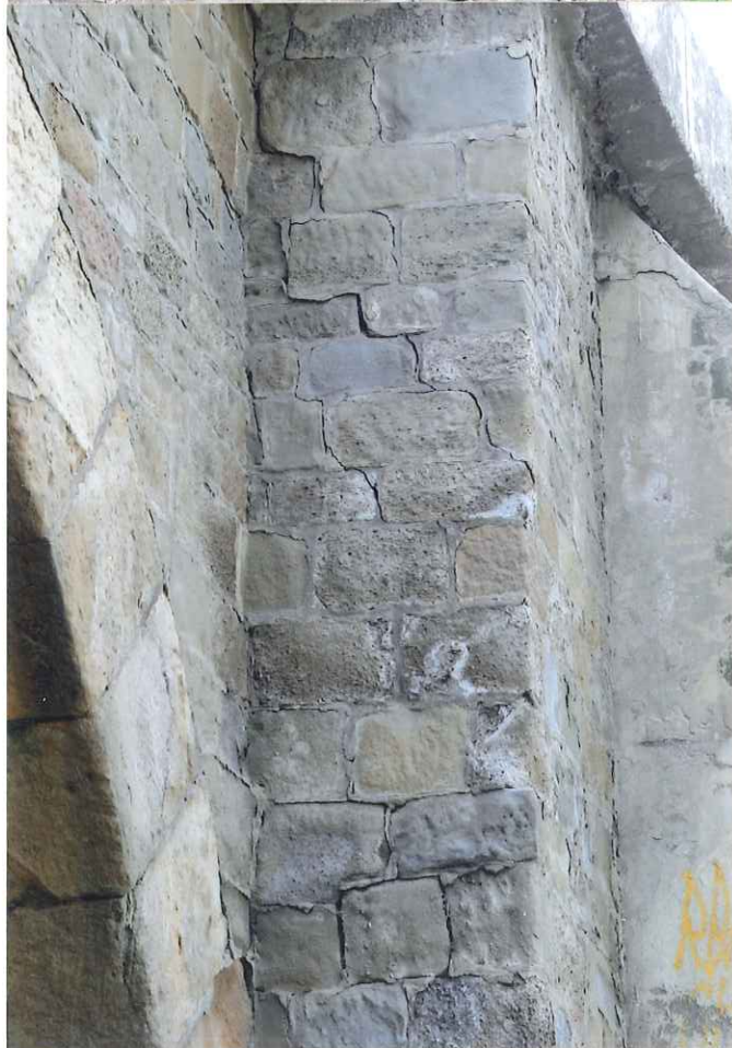
Obr.B57-032 Horní část polosloupu za pravým čelem 2. opěry. Napravo od něj přibetonávka pravého křídla této opěry. Pohled k Vyškovu, - trhliny ve zdivu š. do 10 mm, dole vyprázdnění spár.
