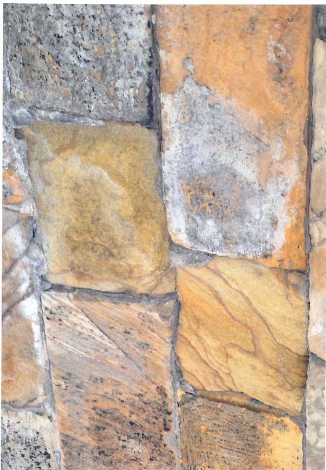
Obr.B57-024 Podhled klenby v jejím druhé polovině. Pohled doprava k Nezamyslicím a vzhůru, - dvojice více zvětralých klenáků těsně ve 3/4 rozpětí klenby.
