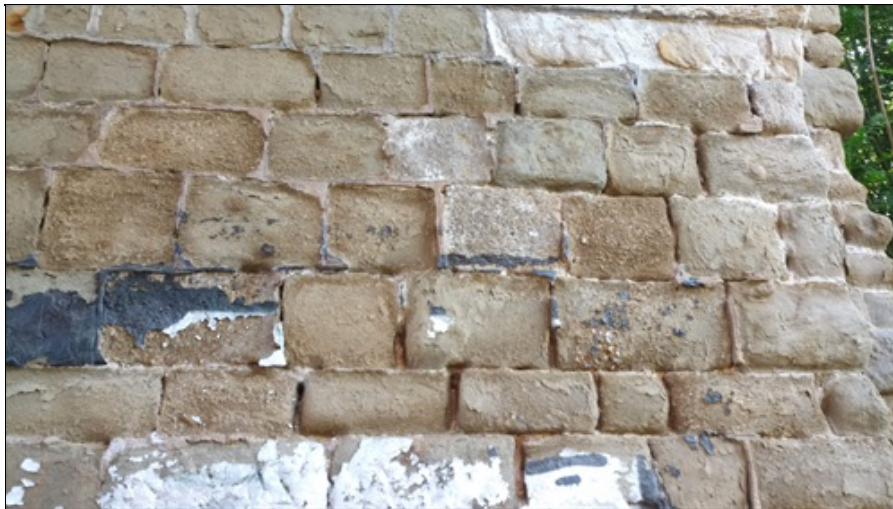
10_Degradace pískovce opěr.jpg
