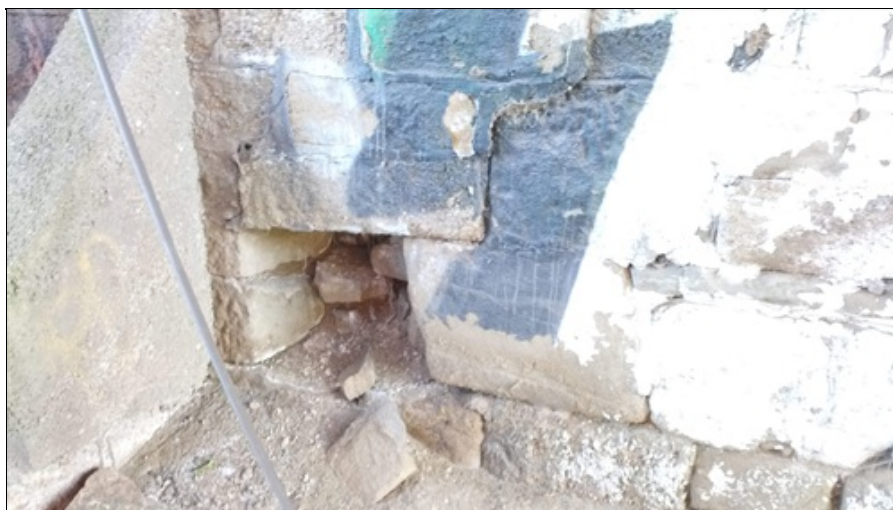
09_Rozpad pískovce opěry OP1 trhliny.jpg
