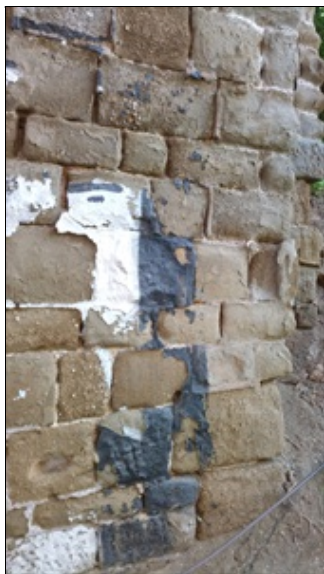
13_Degradace opěr.jpg
