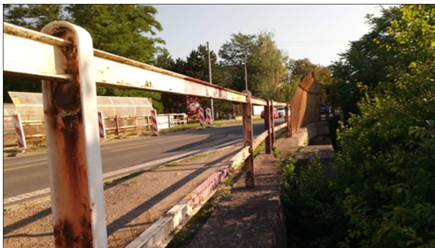
18_Deformované zábradlí s protidotykovou zábranou.jpg
