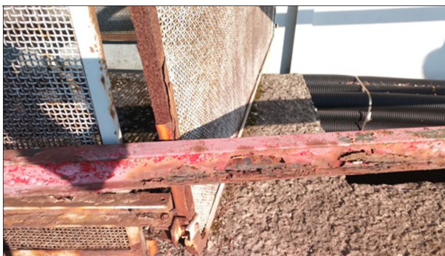
17_Koroze zábradlí.jpg
