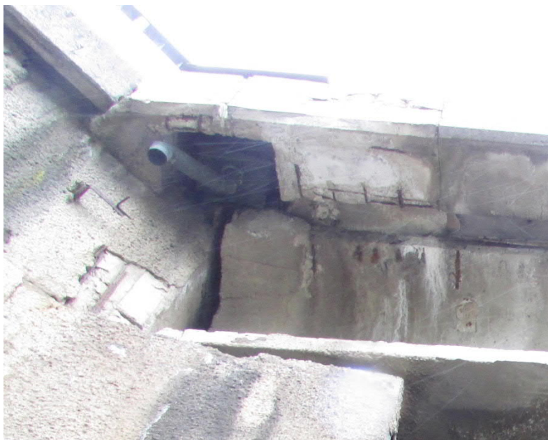
Obr. 2 Podhled žlabu u OP2 – kotlík pro odvodnění mostního závěru.
