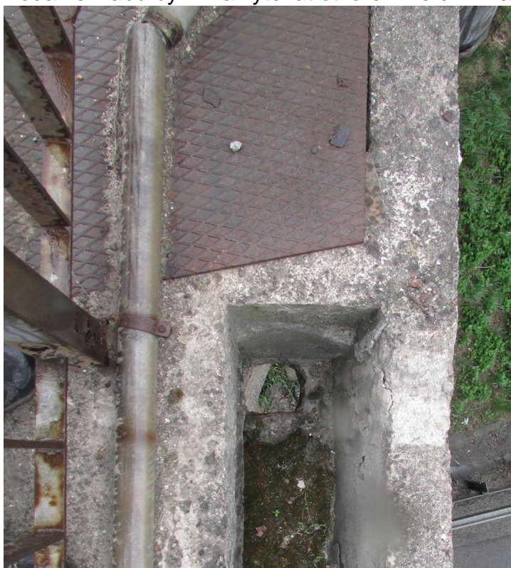
Obr. 3 – Výpust' odvodňovacího žlabu
