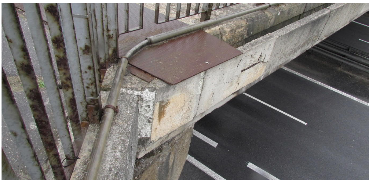
Obr. 1 – Pohled na zakrytý žlab v místě MZ
