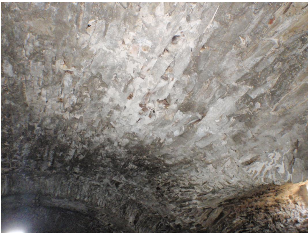
Deformace jsou řádu několika cm, stav klenby v tomto místě je nutno klasifikovat jako již havarijní.
