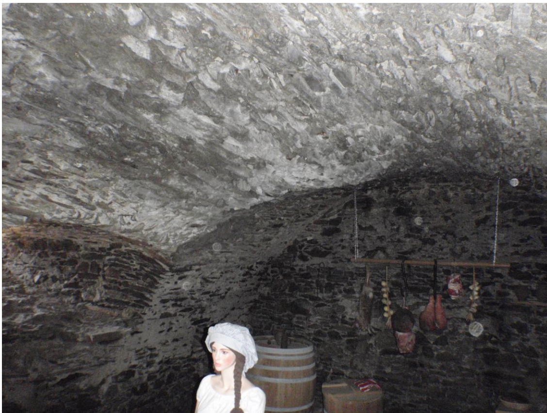
Klenba v místě severní lunety vykazuje značné známky deformací.
