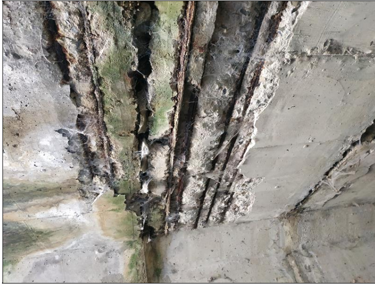
Zatékání spárami mezi prefabrikáty.jpg
