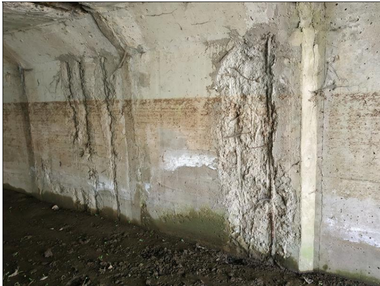
Degradace betonu prefabrikátů.jpg
