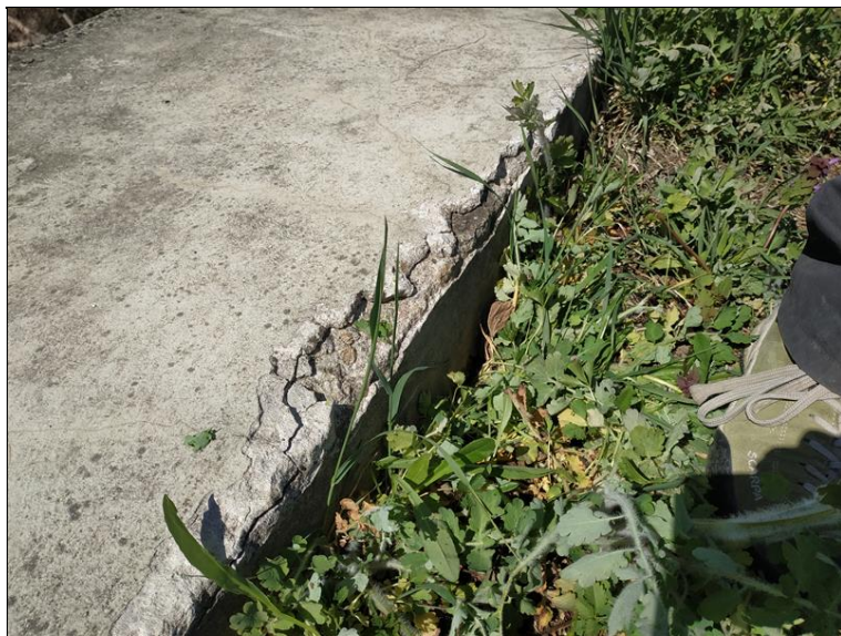
Lokální degradace povrchu říms.jpg
