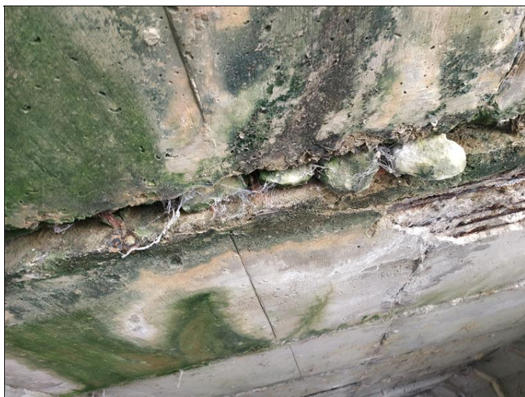
Zatékání spárami mezi prefabrikáty 2.jpg
