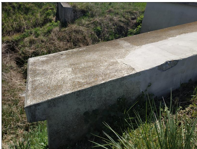
Lokálně zapravená levá římsa.jpg
