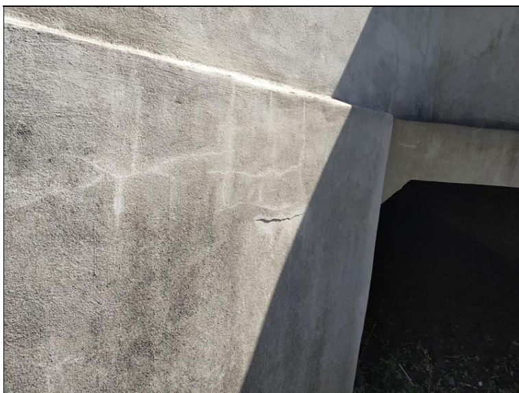
Všesměrné trhliny a odtržení sanační omítky na pravém křídle u OP1.jpg
