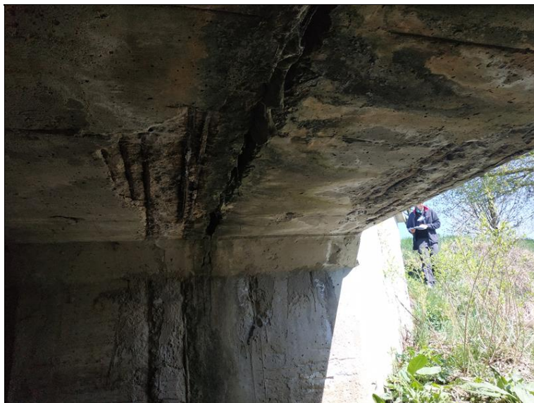
Silně potečené a zdegradované 2 krajní levé prefabrikáty se zkorodovanou výztuží.jpg
