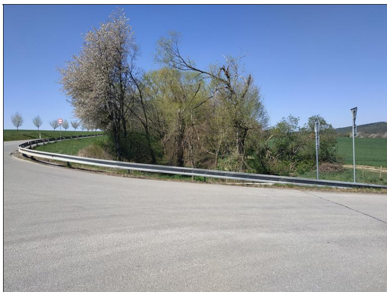
Příliš dlouhý náběh svodidla na mostě vpravo.jpg
