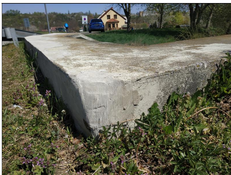
Lokálně zapravená levá římsa 2.jpg
