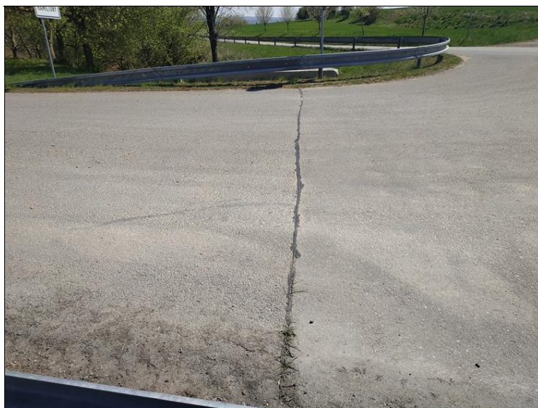
Příčná trhlina ve vozovce za OP2.jpg
