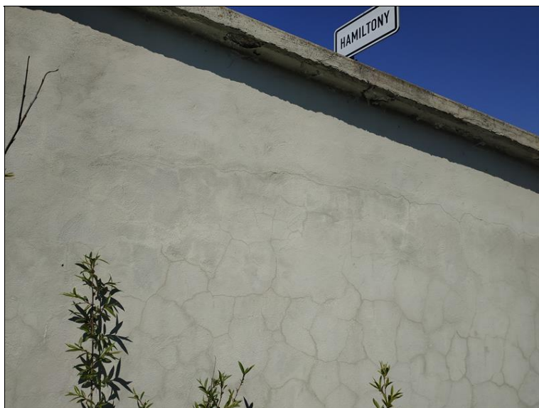
Všesměrné trhliny na levém křídle u OP1.jpg
