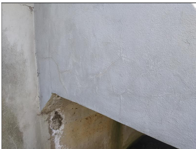
Všesměrné trhliny na levé čelní zdi.jpg
