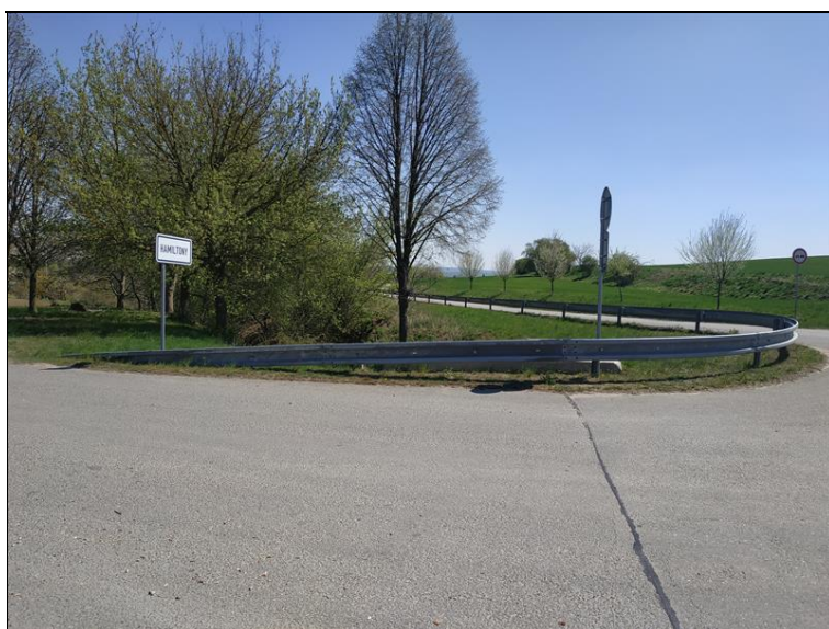
Příliš dlouhý náběh svodidla na mostě vlevo.jpg
