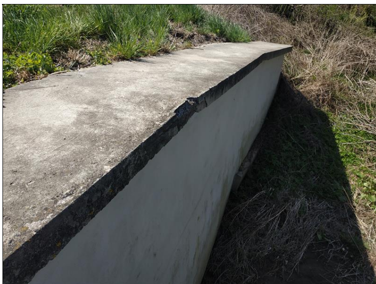
Lokální degradace betonu pravé římsy 2.jpg
