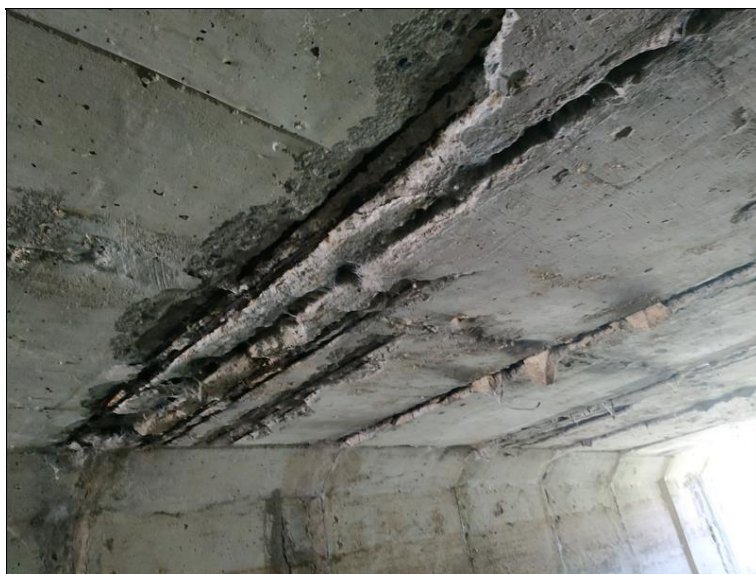
Degradace betonu prefabrikátů v důsledku zatékání.jpg
