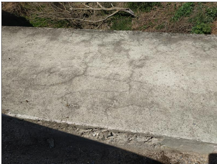
Lokální degradace betonu pravé římsy.jpg
