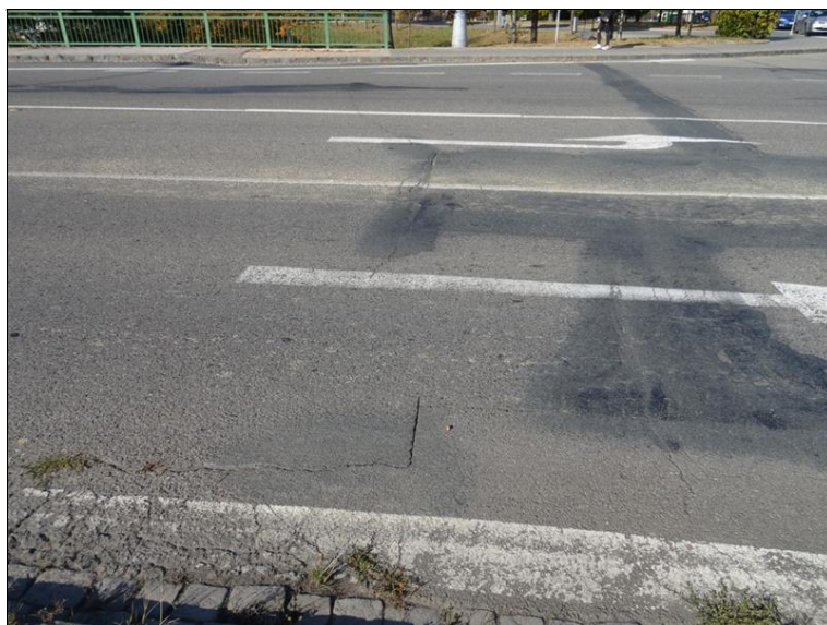
14.JPG Kryt vozovky v místě Op1 v pohledu k pravé straně mostu. U pravého krajnice vozovky (horní strana snímku) patrný pokles.
