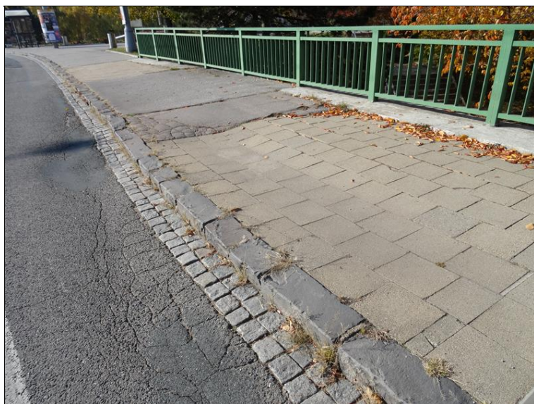
13.JPG Pravá chodník. Před Op1 propad vozovky a chodníku.
