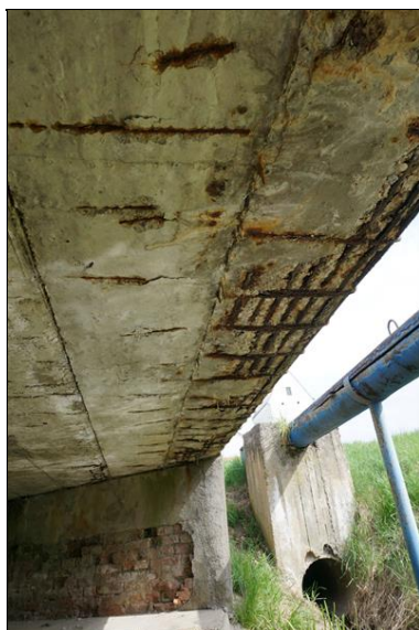
Detail levého krajního nosníku, odpadávající vrstvy betonu až na nosnou výztuž, která koroduje.
