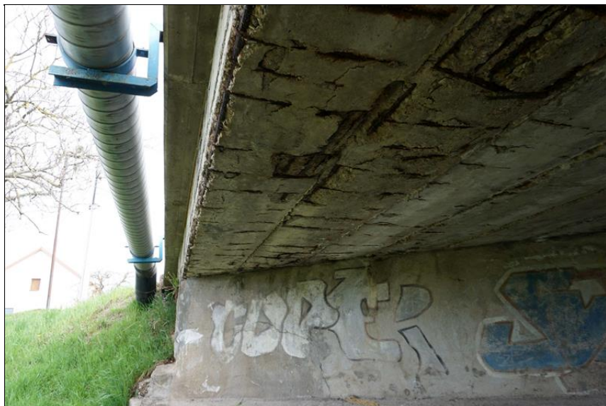
Detail levého krajního nosníku, odpadávající vrstvy betonu až na nosnou výztuž, která koroduje.
