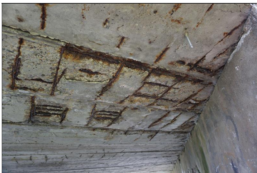
Detail podhledu NK, odpadávající vrstvy betonu až na nosnou výztuž, která koroduje.
