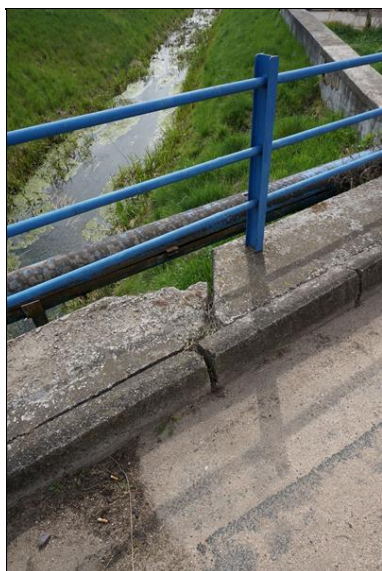
Detail dilatační spáry u opěry OP2 vlevo.
