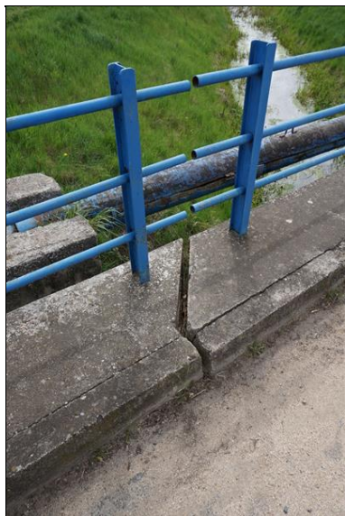
Detail dilatační spáry u opěry OP1 vlevo.
