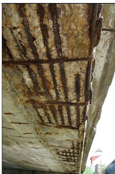
Detail povrchu NK, odpadávající vrstvy betonu až na nosnou výztuž, která koroduje.
