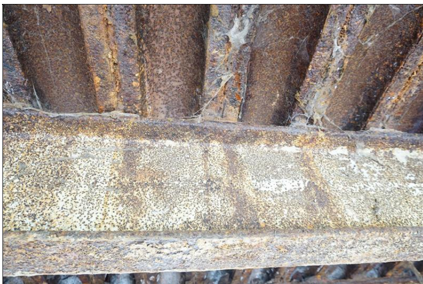
Detail koroze nosné konstrukce.
