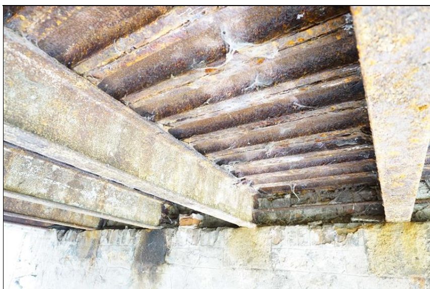
Podhled nosné konstrukce, silná koroze ocelových prvků.
