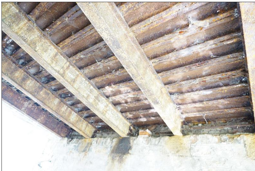
Podhled nosné konstrukce, silná koroze ocelových prvků.
