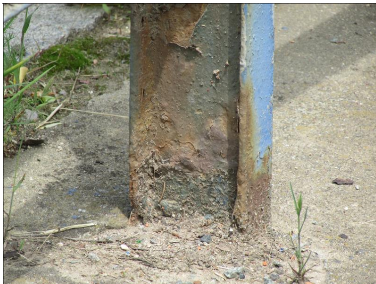
Koroze sloupku zábradlí
