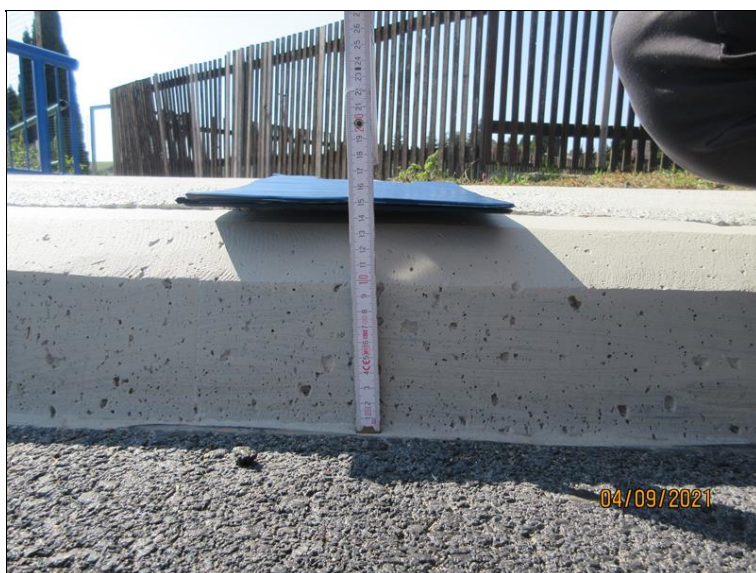
Pohled na ŽB. chodník na levé straně mostu. Naměřeny výšky nášlapu cca 15 -16cm.
