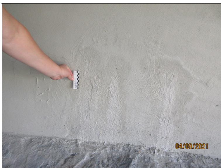
Pohled na OP2 - detail povrchu, průsak.
