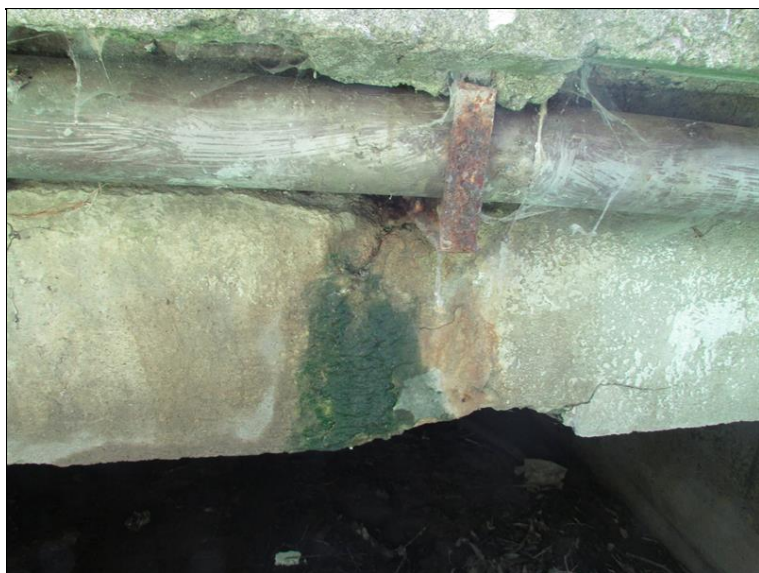
Zatékání na pravé straně
