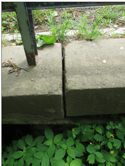
Dilatační spára v římse
