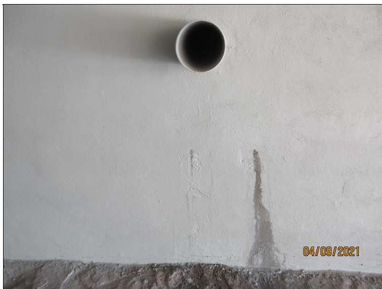
Pohled na OP1 - středové odvodnění a průsak.
