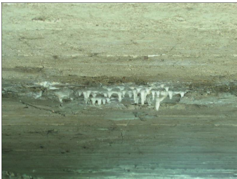
Lokální průsaky skrz NK
