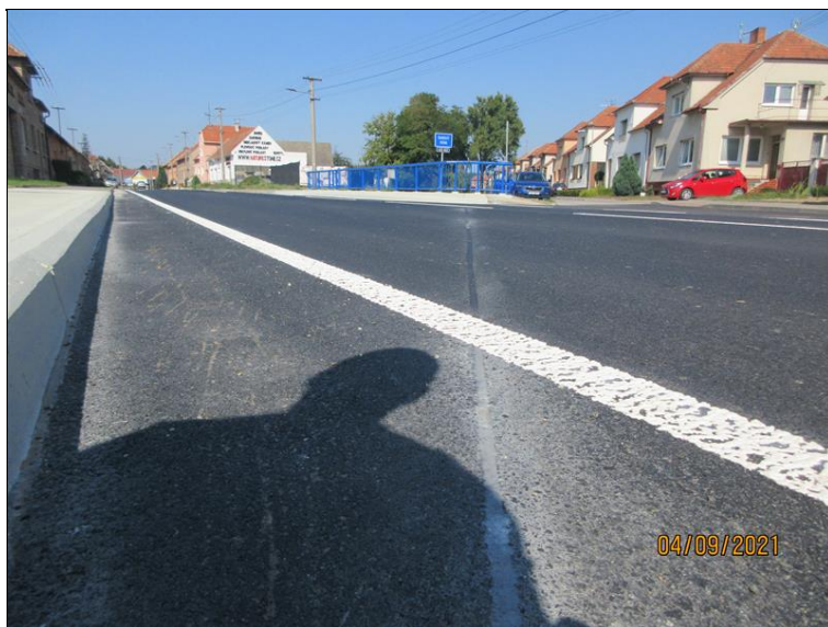
Pohled na vozovku nad OP1 - zálivka dilatace.
