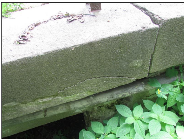
Trhlina a dilatační spára v římse vpravo
