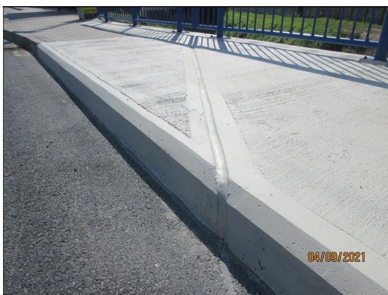
Pohled na chodník nad OP1 levá strana. Na tmelení dilatační spáry.
