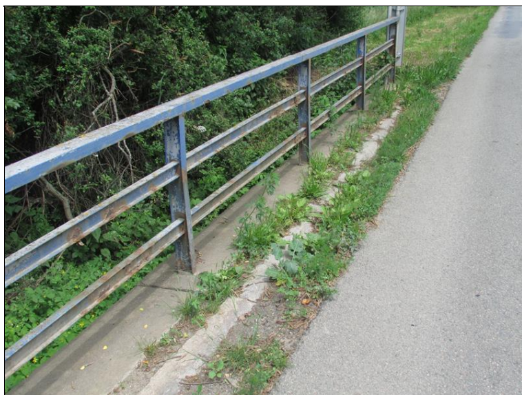
Zarostlá krajnice, silně převrstvená vozovka
