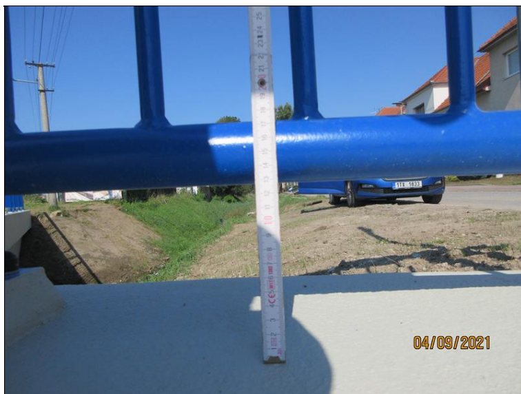
Pohled na zábradlí mostu. Kontrola rozměrů.
