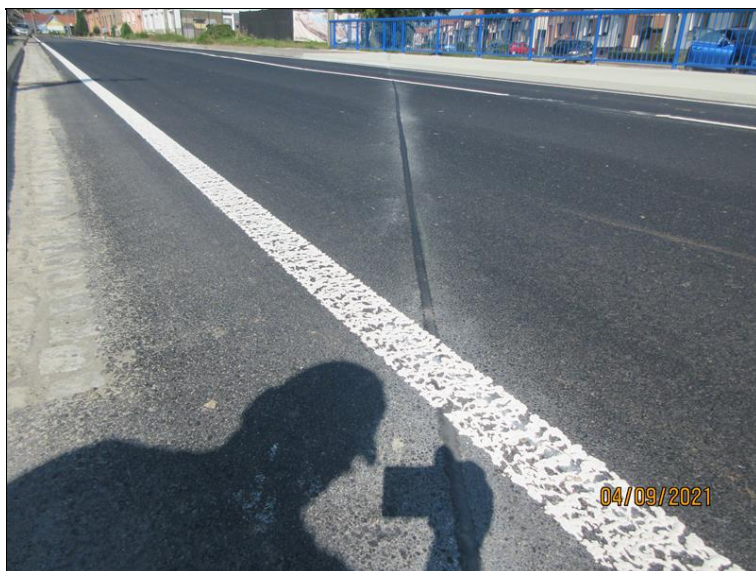
Pohled na vozovku nad OP2 - zálivka dilatace.
