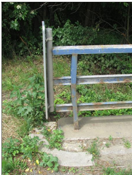
Deformace zábradlí vpravo
