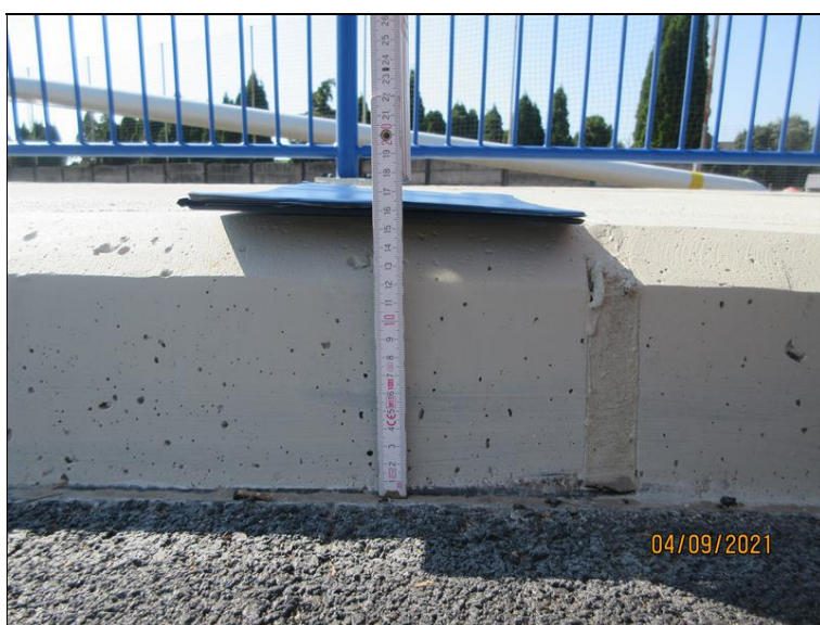
Pohled na ŽB. chodník na levé straně mostu. Naměřeny výšky nášlapu cca 15 -16cm.
