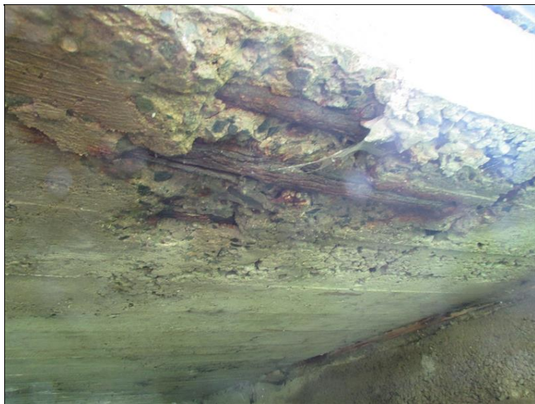
Koroze výztuže v pohledu NK na pravé straně
