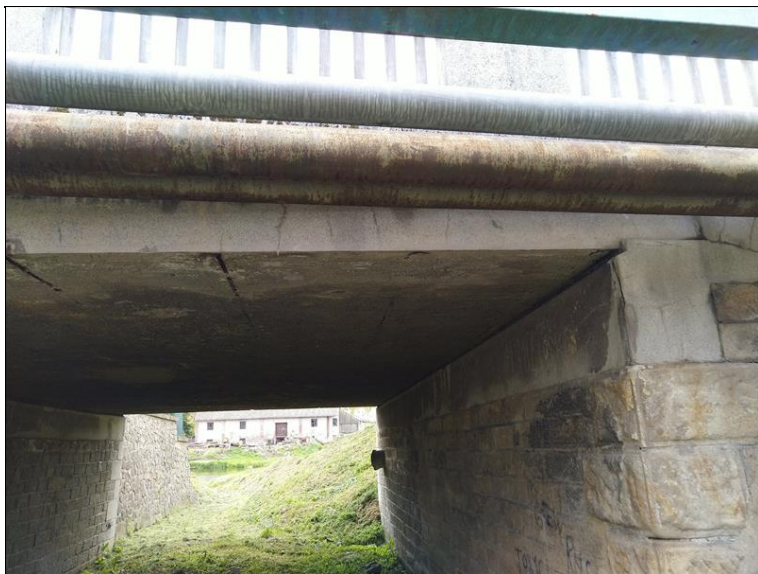
Stopy po zatékání na opěře, obnažená výztuž v podhledu NK.jpg
