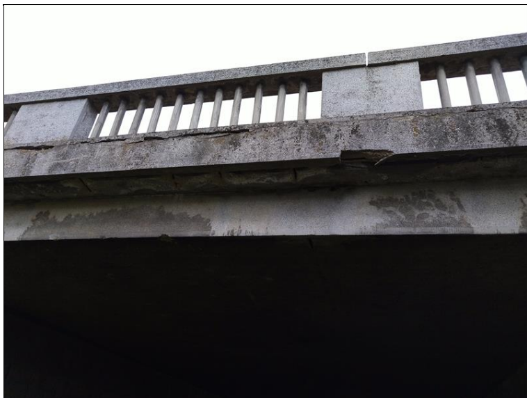
Trhliny v římse, zábradlí na mostě.jpg
