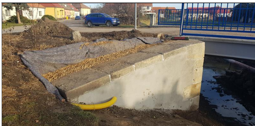
oprava říms a křídel
