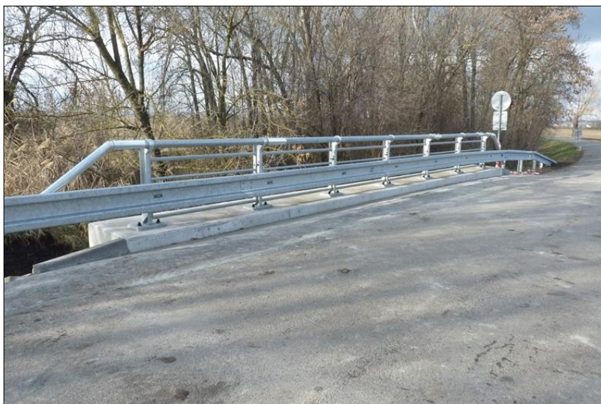
Zábradelní svodidlo na pravé římse P1380721.jpg
