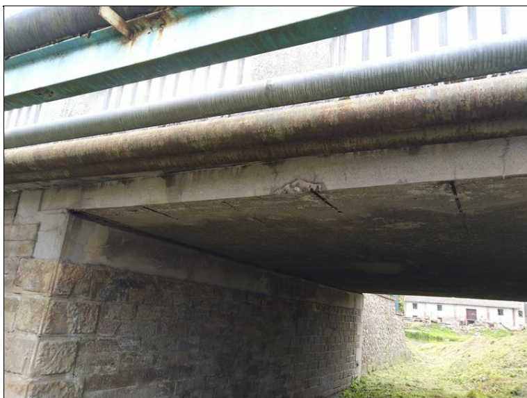
Trhliny v římse, obnažená výztuž v podhledu římsy.jpg
