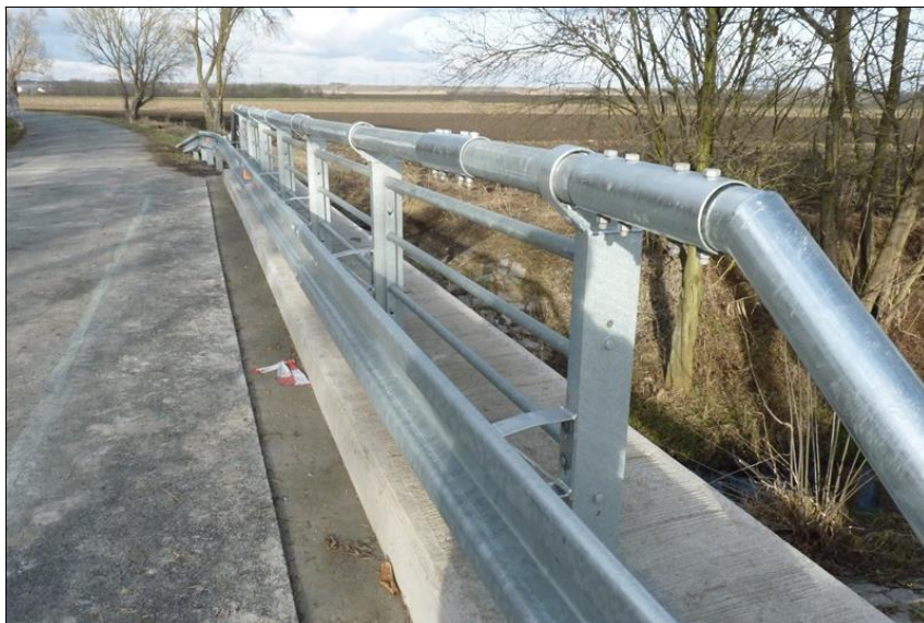
Zábradelní svodidlo na levé římse P1380720.jpg
