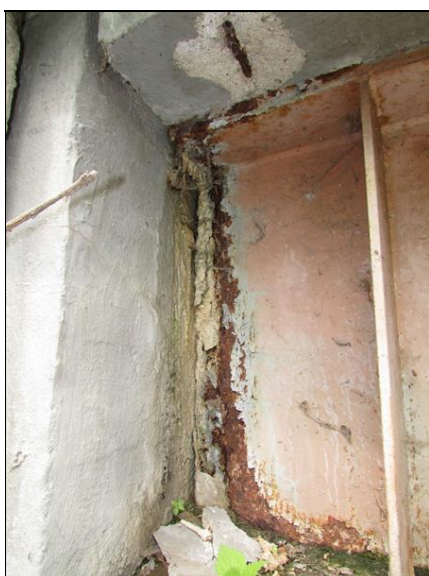
Koroze a inkrustace u OP1 vpravo
