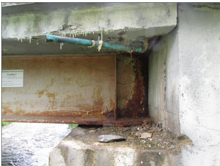
Uložení NK na OP1 vlevo, Odvodnění u MZ
