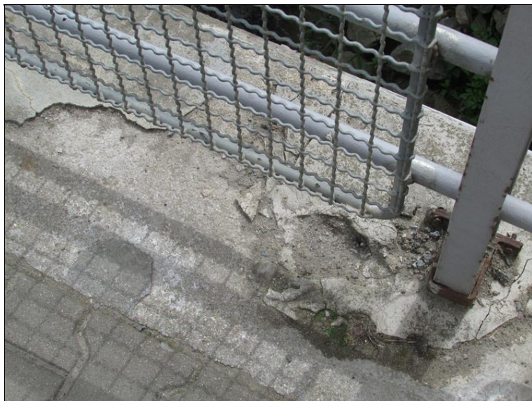
Degradace povrchu římsy
