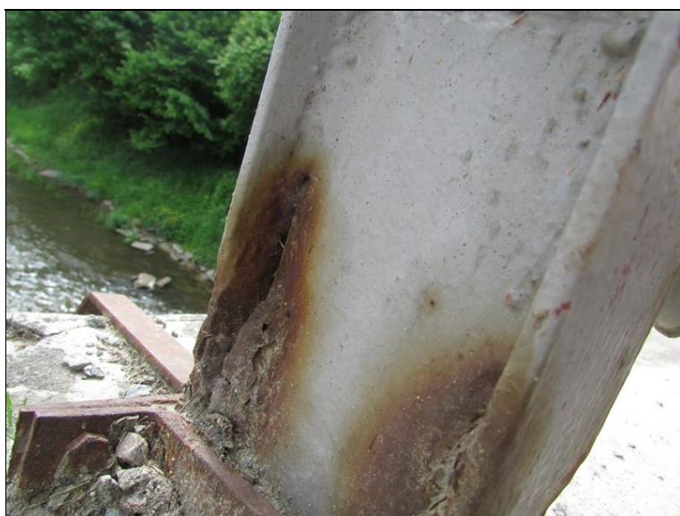
Koroze v patě sloupku zábradlí
