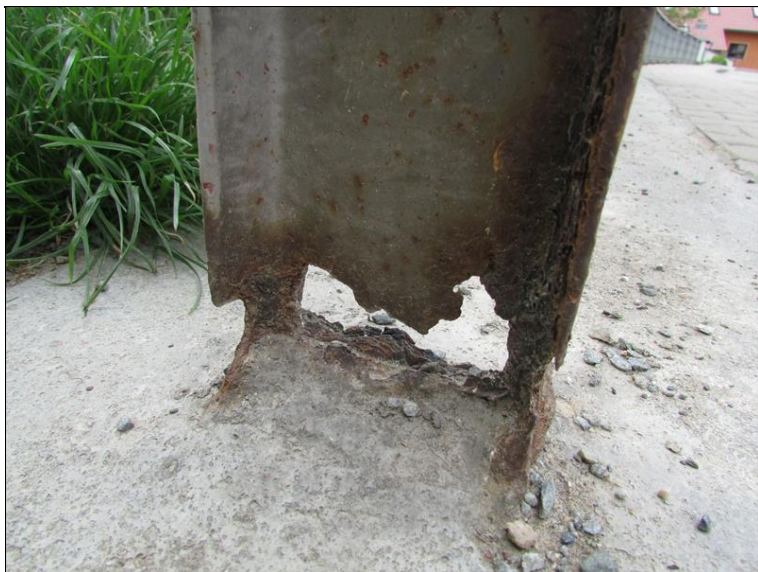
Koroze v patě sloupku zábradlí
