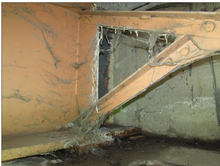
Koroze a inkrustace u OP1 vpravo
