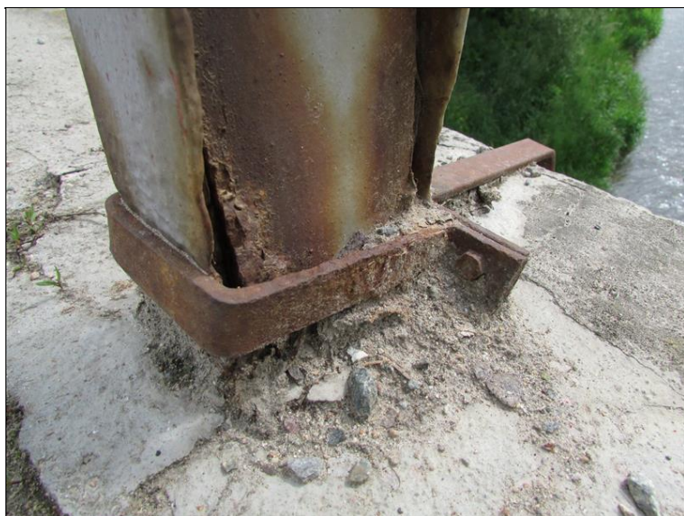
Koroze v patě sloupku zábradlí
