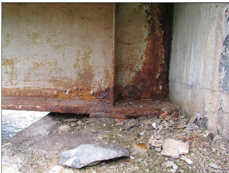
Silná koroze NK v místě uložení NK na OP
