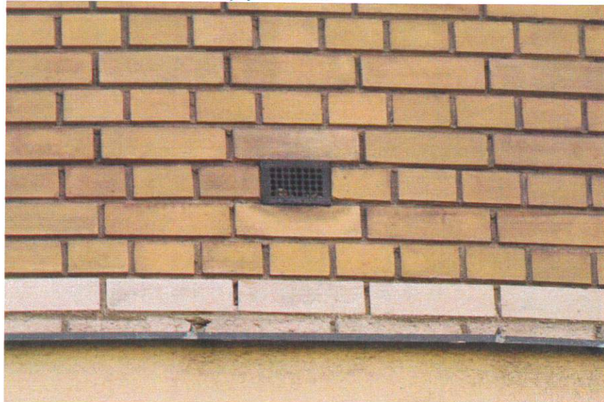
Obr. 15: Větrací otvor krytý mřížkou
