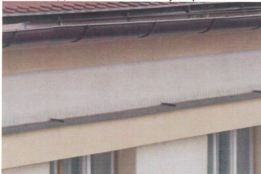
Obr. 14: Hroty proti holubům na římsách fasády
