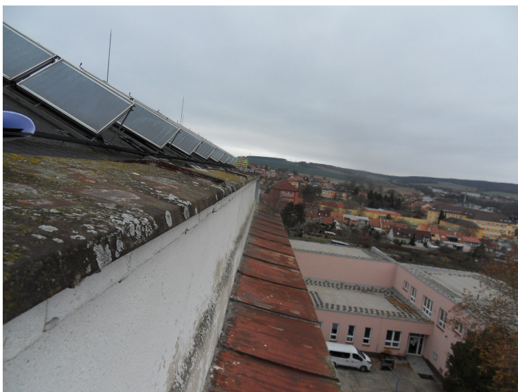
Degradované oplechování skrytého nadřímsového žlabu s navazujícím oplechováním římsy
