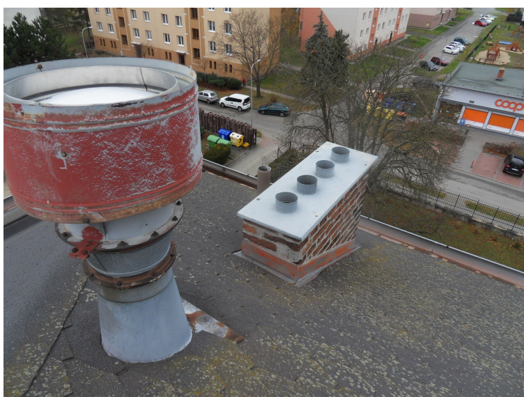
Oplechování komínových hlav, prostory VZT a větracího potrubí kanalizace
