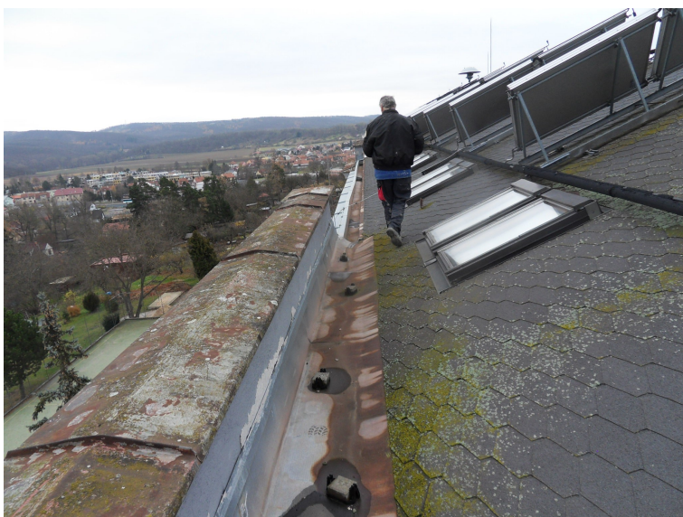
Skrytý nadřímsový žlab, solární termické panely.
