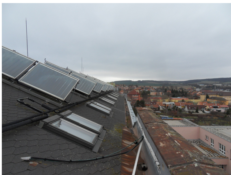
Skrytý nadřímsový žlab, solární termické panely.
