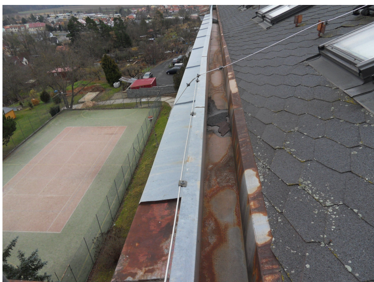
Degradované oplechování skrytého nadřímsového žlabu s navazujícím oplechováním římsy
