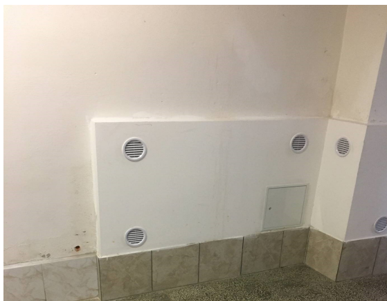
Lokálně jsou degradované omítky „maskovány“ předsazenou stěnou ze sádrokartonu
