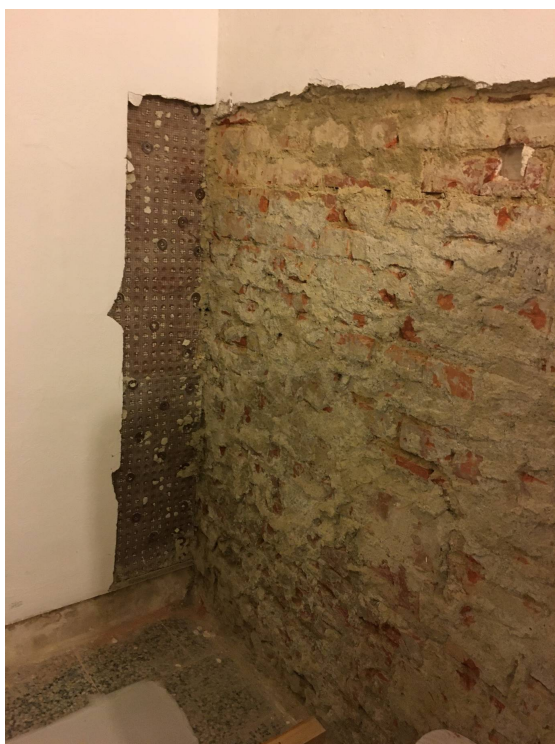
V místě zvýšené podlahy v rubu konstrukce (012 chemický sklad) se na vnitřním líci provedlo opatření z nopové folie se sítíkou a omítkou, bohužel nedošlo k napojení na žádnou vodorovnou izolaci nad vyšší podlahou, a tak docházelo stále ke vztlínání vlhkosti konstrukcí nahoru.
