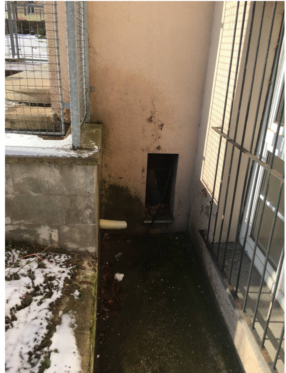
→ Viditelné zatékání vody z odtoku ze stříšky nad vstupem, voda dvorkem neodtéká, ale vsakuje do zdiva .
