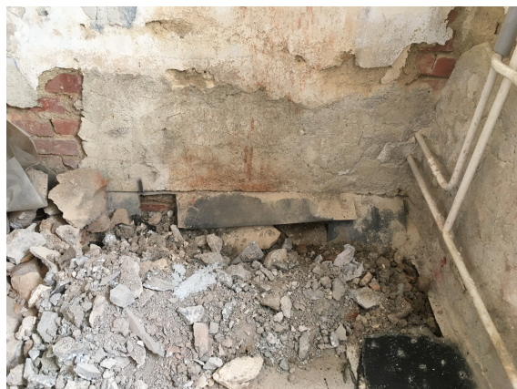
Na některých místech bylo prováděno dodatečné podřezání zdiva i v době po rekonstrukci v 90.létech 20st..
