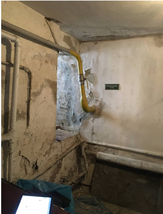
↑↓ Obvodovou konstrukcí zatéká do prostoru pod hlavním vstupem, a to jak shora od vnějšího schodiště, ale i od anglických dvorků.
