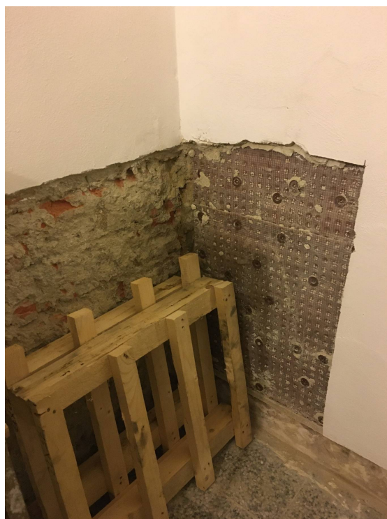
V místě zvýšené podlahy v rubu konstrukce (012 chemický sklad) se na vnitřním líci provedlo opatření z nopové folie se sítíkou a omítkou, bohužel nedošlo k napojení na žádnou vodorovnou izolaci nad vyšší podlahou, a tak docházelo stále ke vztlínání vlhkosti konstrukcí nahoru.
