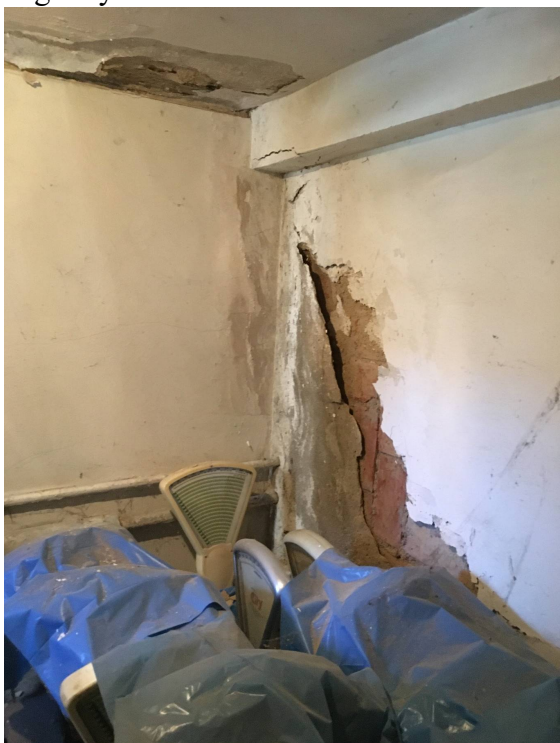
↑→ Projevy zatékání vody od hlavního schodiště a od dvorků.
