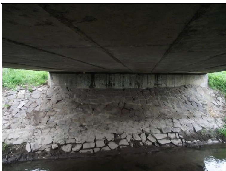
Pohled na levobřežní část zpevněné kynety vodního toku.
