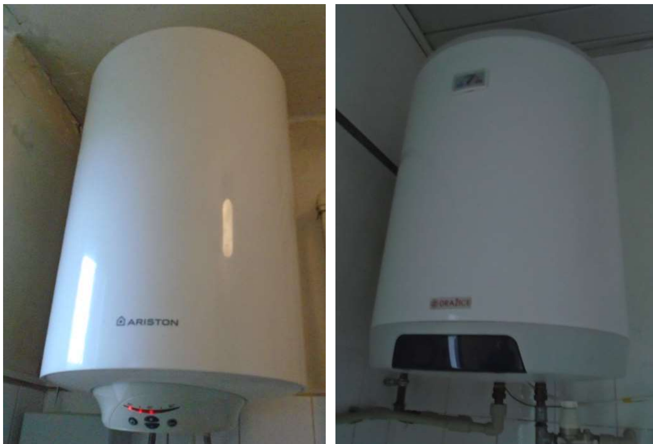
Obrázek č. 4.5.3: Elektrické zásobníkové ohřivače ARISTON a DRAŽICE OKCE 80
