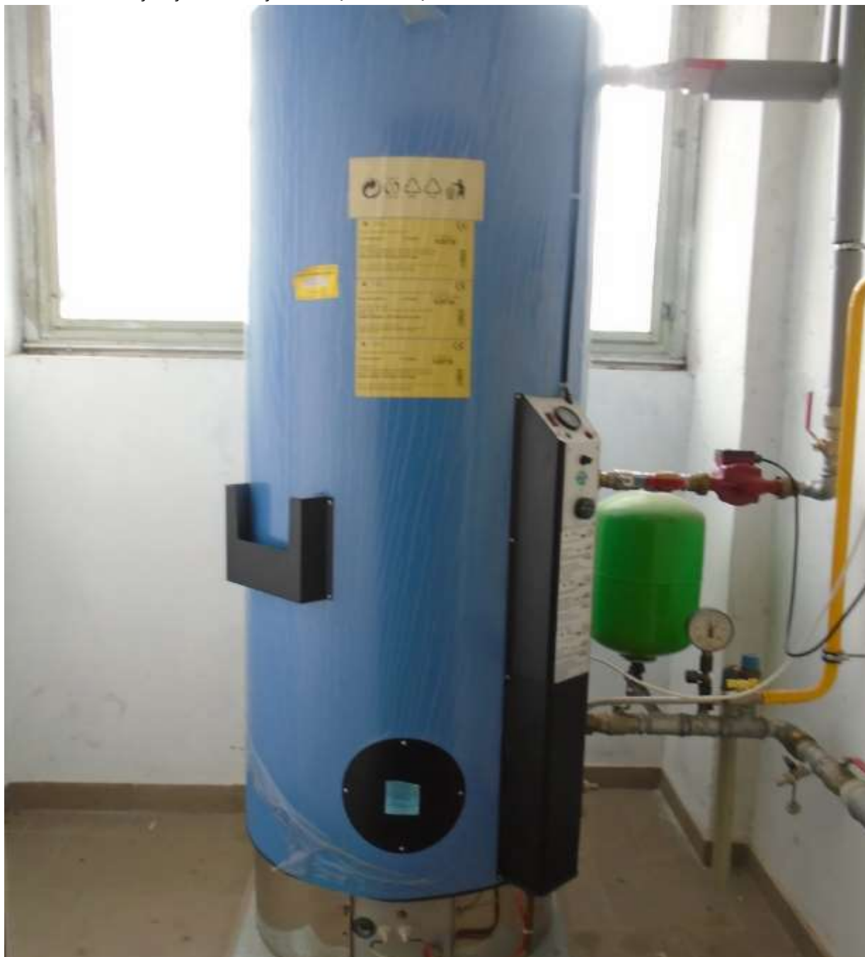
Obrázek č. 4.5.2: Plynový zásobníkový ohřívač QUANTUM Q7-400-VENT-C
