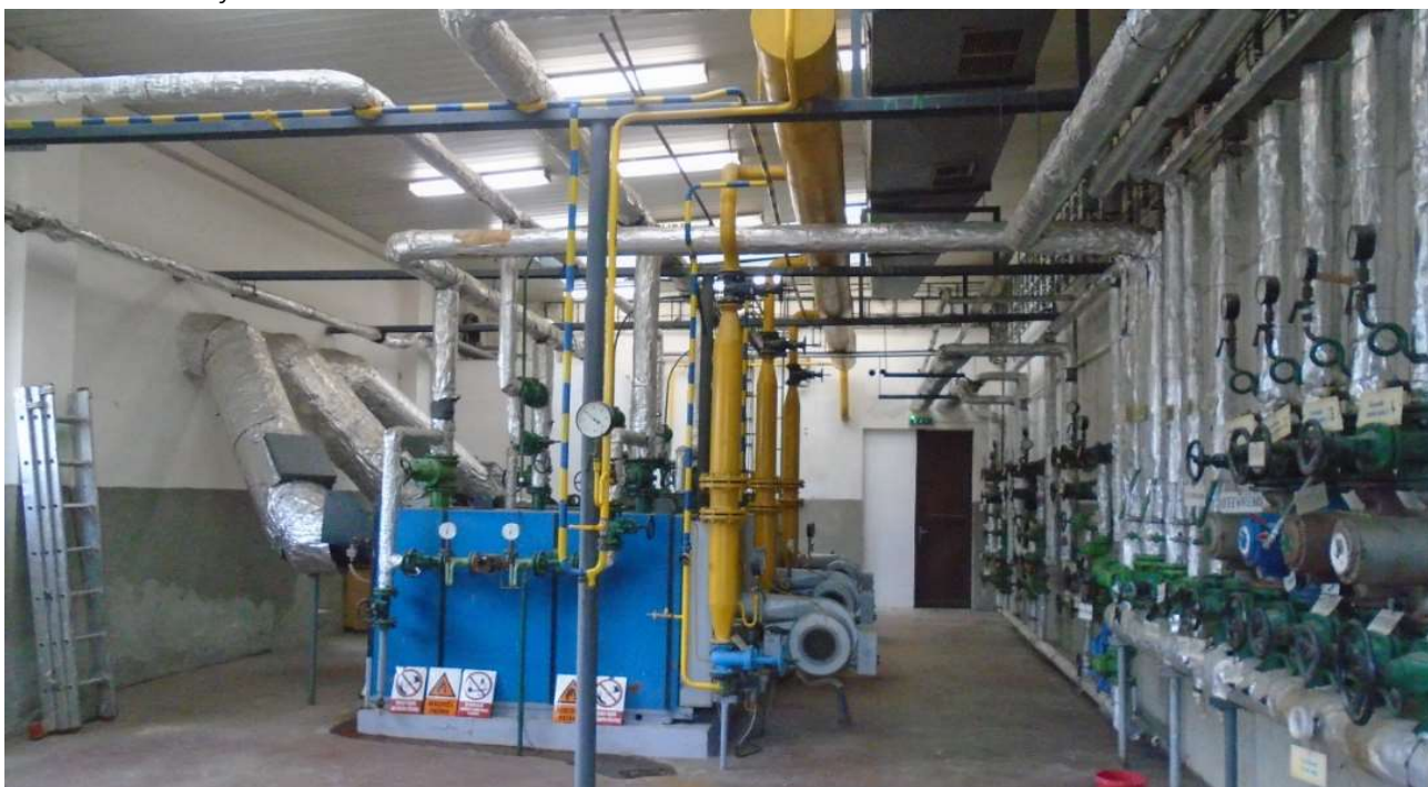
Obrázek č. 4.5.1: Plynové kotle ČKD Dukla PGVE-65
