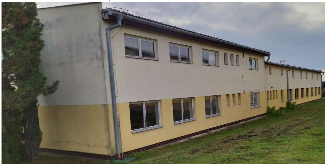
Obrázek č. 4.3.6: Pohled na truhlářské dílny
