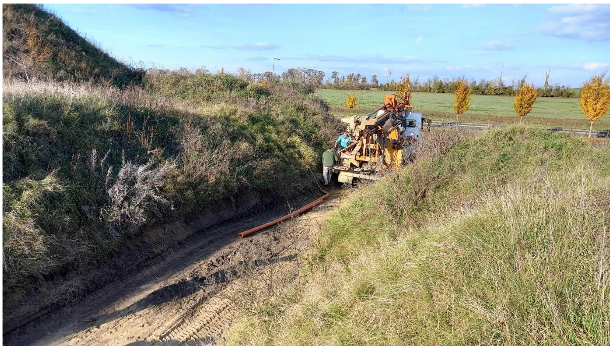
Foto 7 Hloubení vsakovací sondy VS-4
