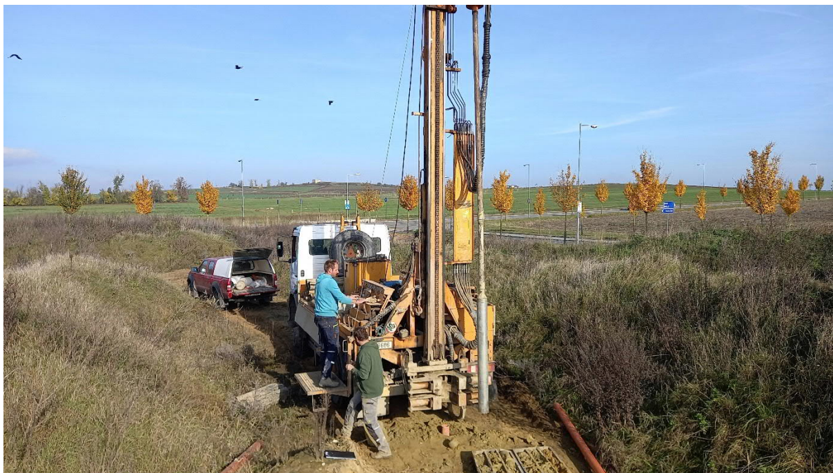
Foto 5 Hloubení vsakovací sondy VS-3
