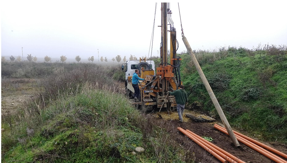
Foto 9 Hloubení vsakovací sondy VS-5
