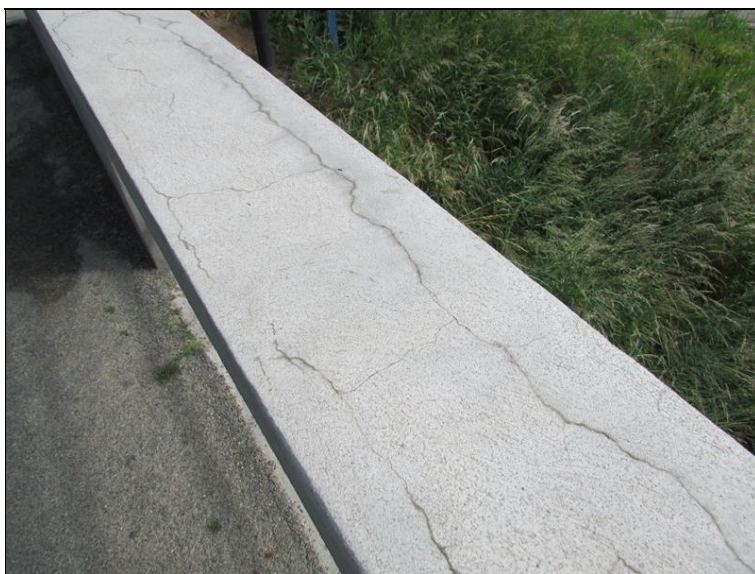
Rozpraskaná sanace zábradlí
