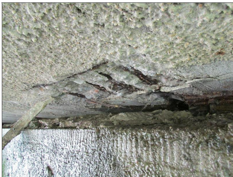
Obnažená korodující výztuž v místě uložení na OP1
