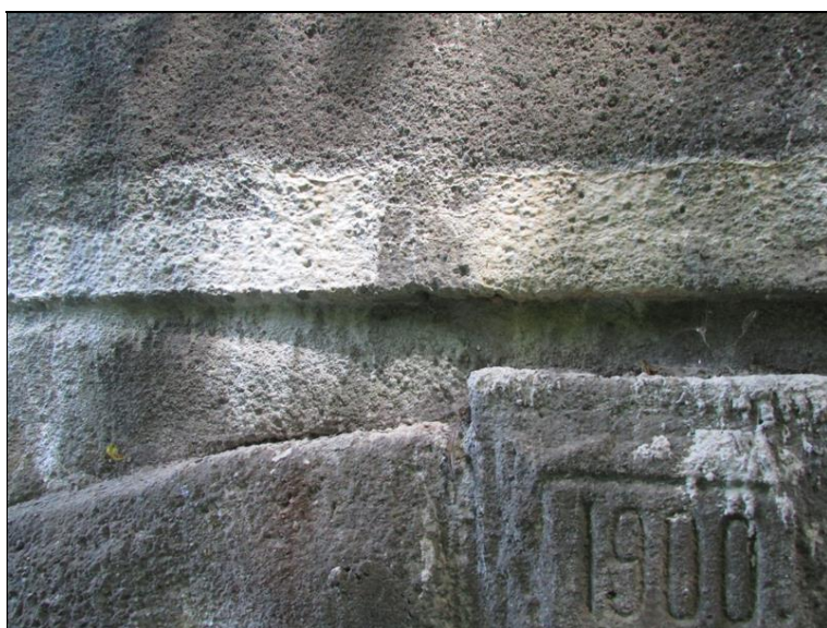
Trhlinky a výluhy v čele klenby
