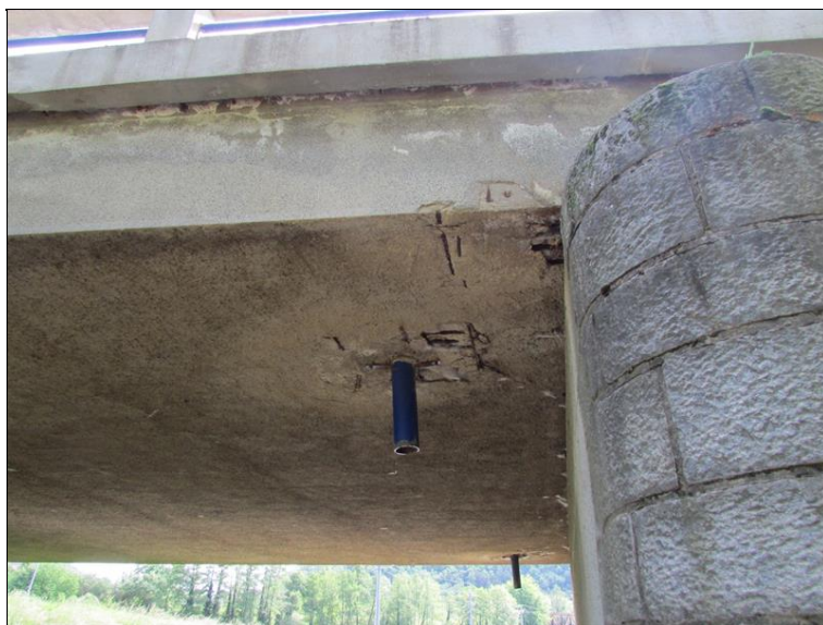
Obnažená korodující výztuž na pohledu NK
