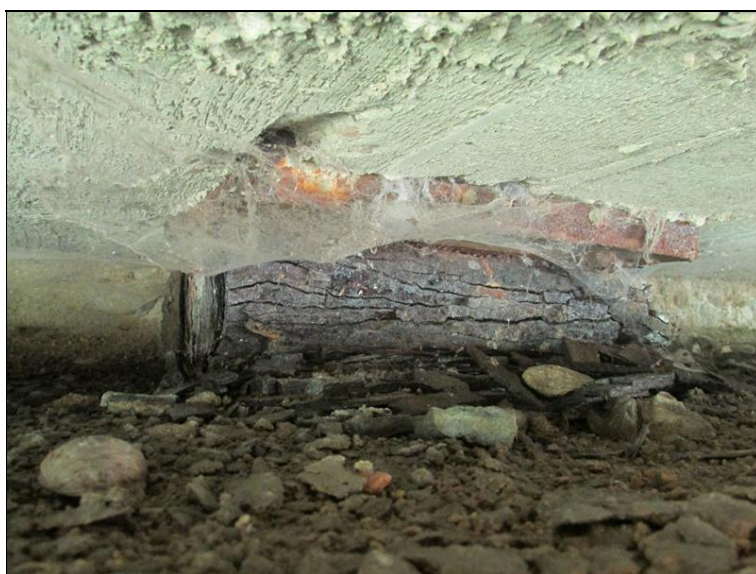
Silná koroze ložisek na OP
