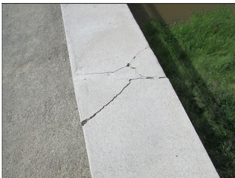
Opravené betonové zábradlí praská (není nikde dilatováno)
