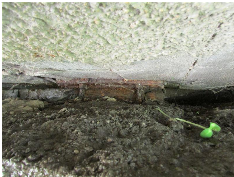
Silná koroze ložisek na OP
