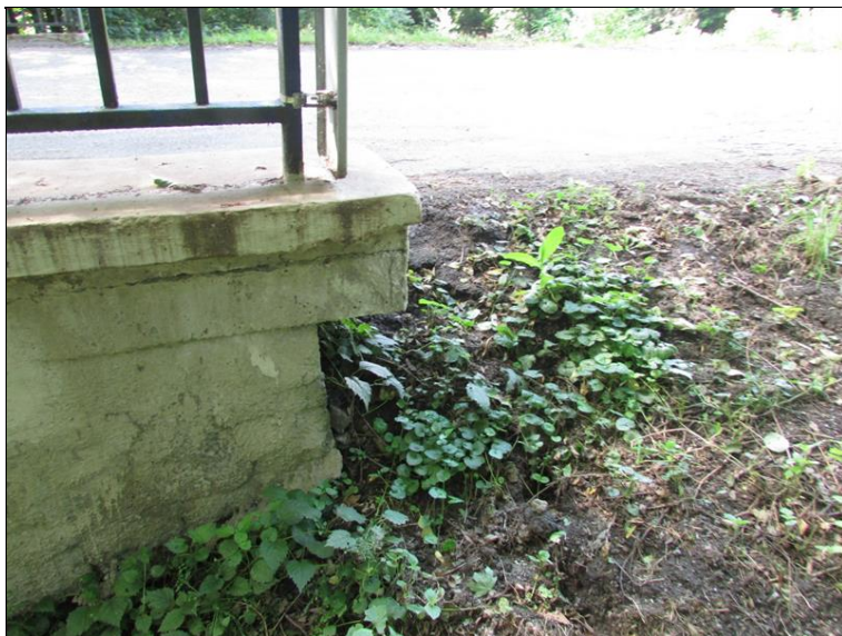
Terén není na římsy ideálně napojen
