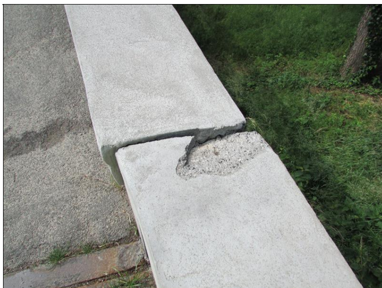
Opravené betonové zábradlí praská (není nikde dilatováno)
