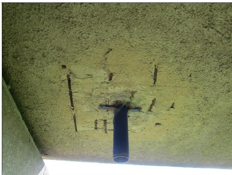
Obnažená korodující výztuž na pohledu NK
