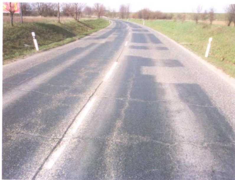
Pohled na úsek - ztráta makrotextury, trhliny
