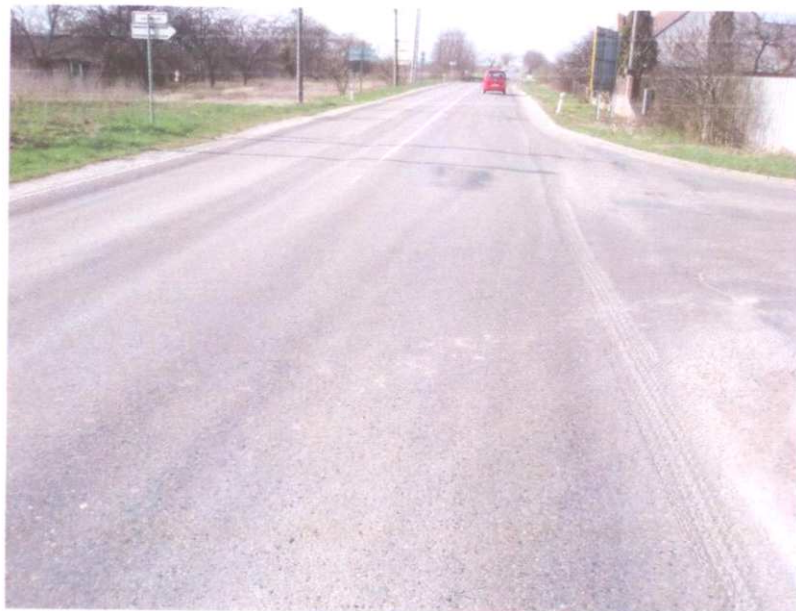
Pohled na úsek - ztráta makrotextury, vyjeté koleje
