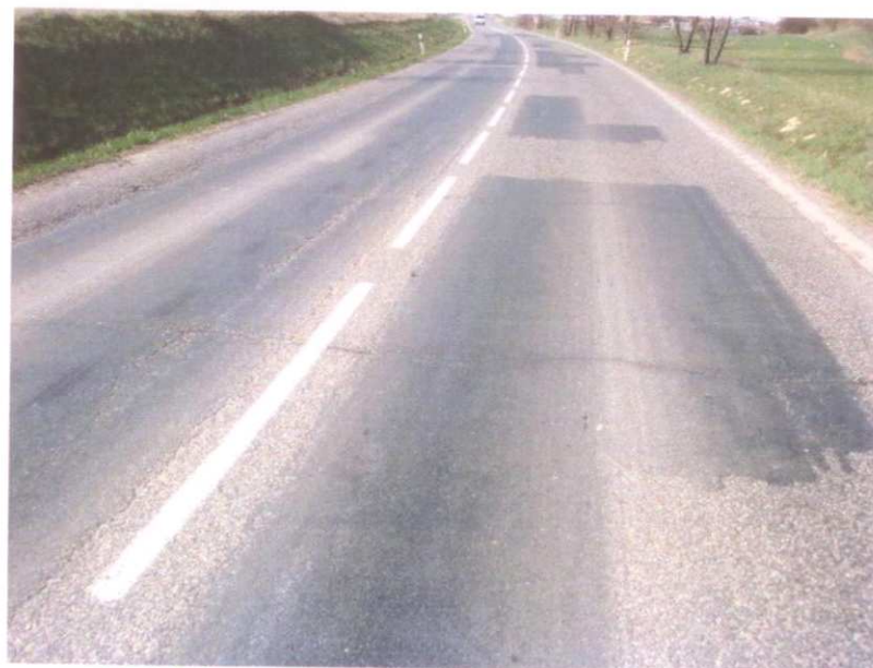
Pohled na úsek - ztráta makrotextury, trhliny
