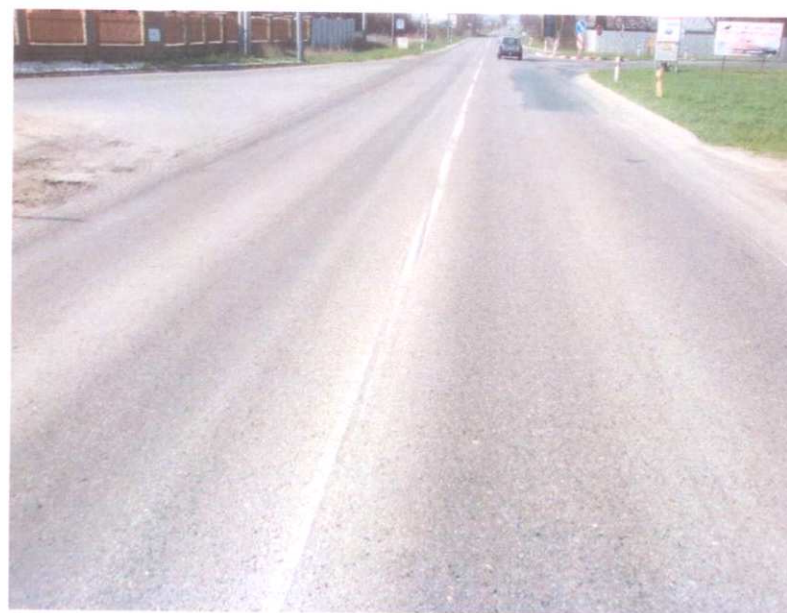
Pohled na úsek - ztráta makrotextury, vyjeté koleje
