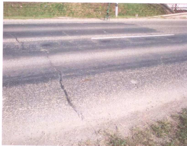
Hlubková koroze původní vozovky mimo nátěr
