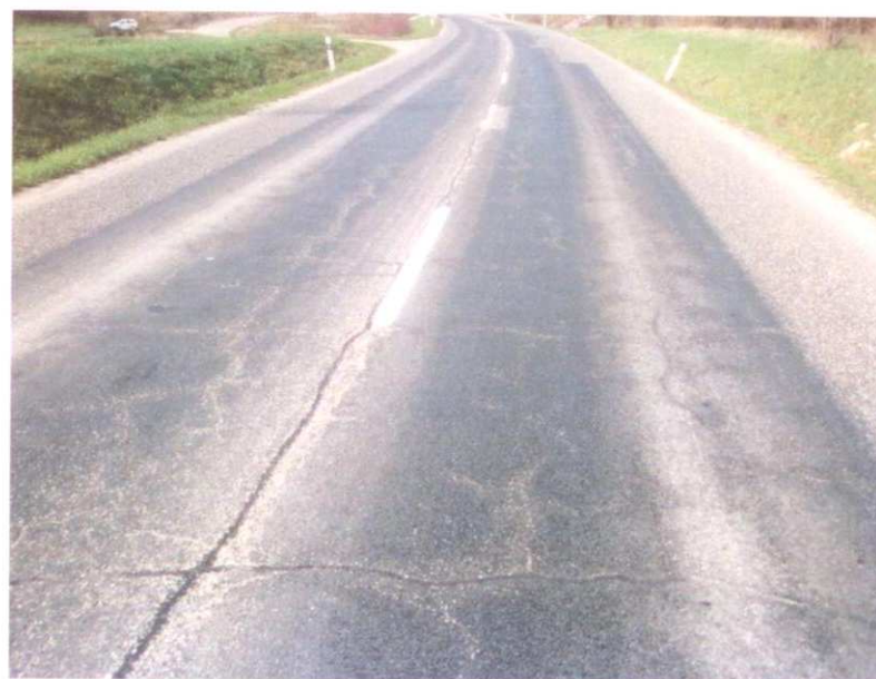
Pohled na úsek - ztráta makrotextury, trhliny
