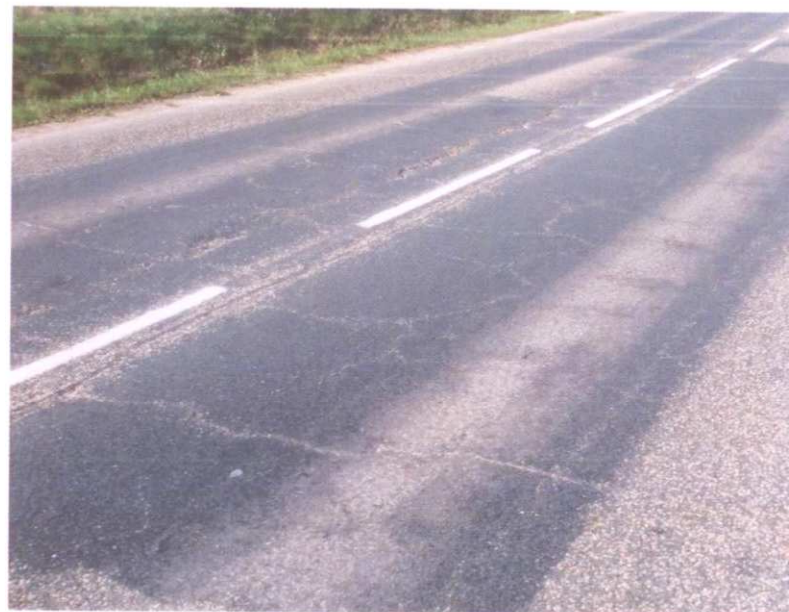
Ztráta makrotextury, mozaikové, podélné a příčné trhliny
