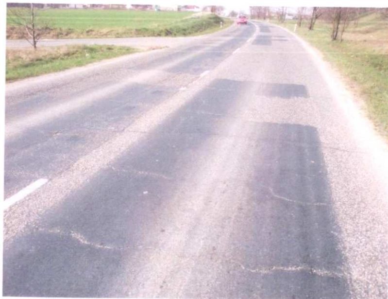
Pohled na úsek - ztráta makrotextury, trhliny
