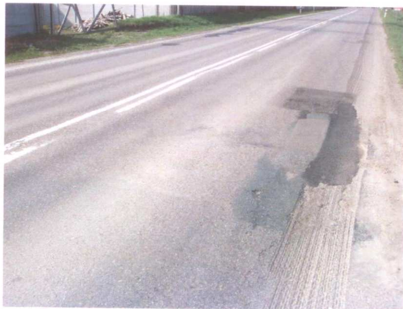
Frézovaný okraj vozovky, vysprávky, výtluky
