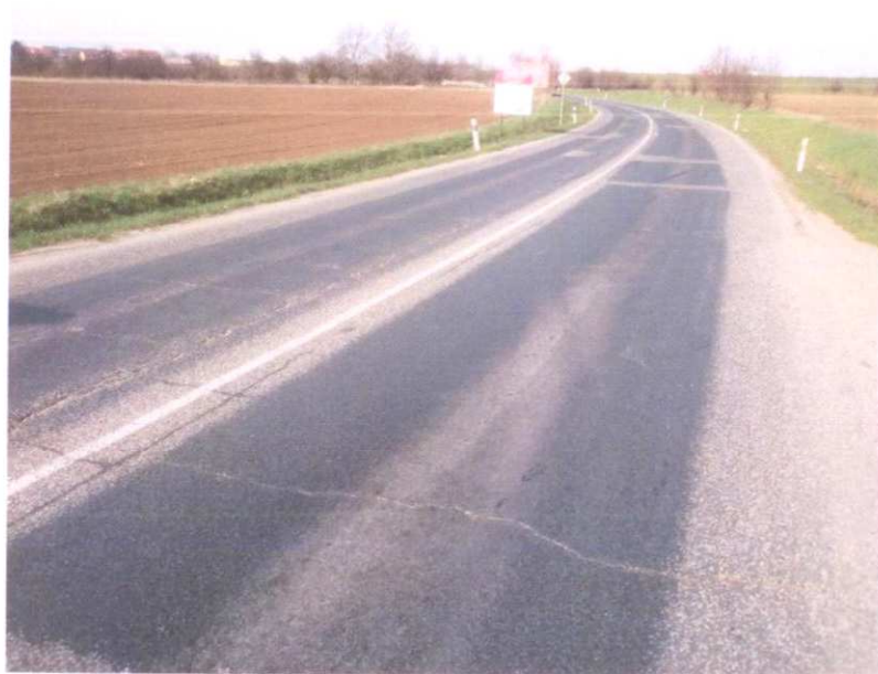
Začátek úseku - ztráta makrotextury, trhliny
