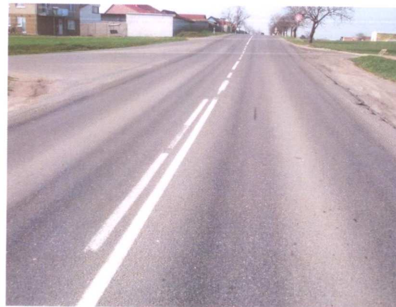
Pohled na úsek - ztráta makrotextury, vyjeté koleje
