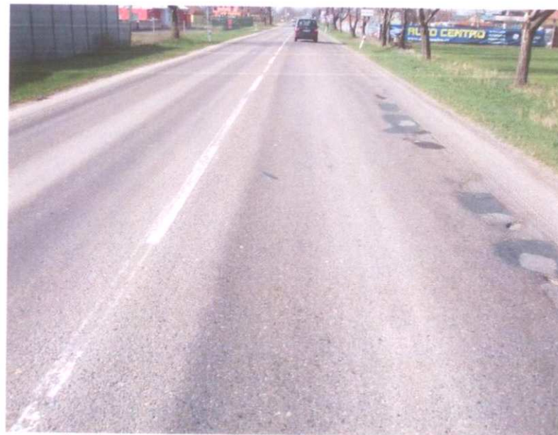
Pohled na úsek - poruchy na okraji vozovky
