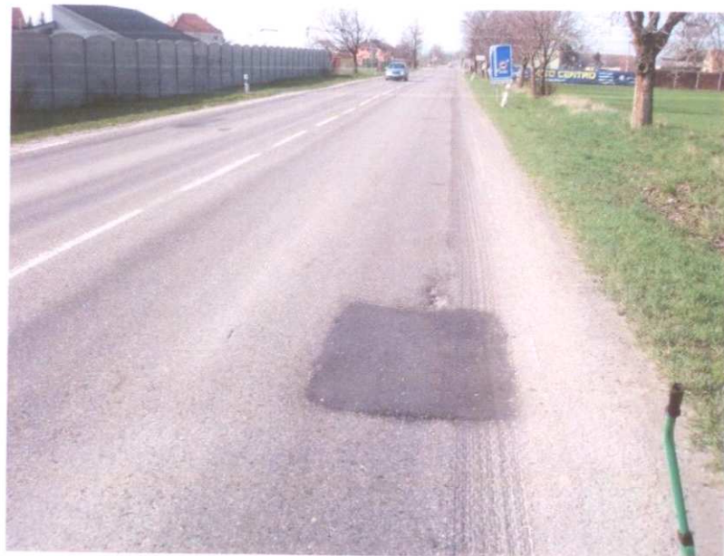
Pohled na úsek - vyjeté koleje, vysprávka, výtluk
