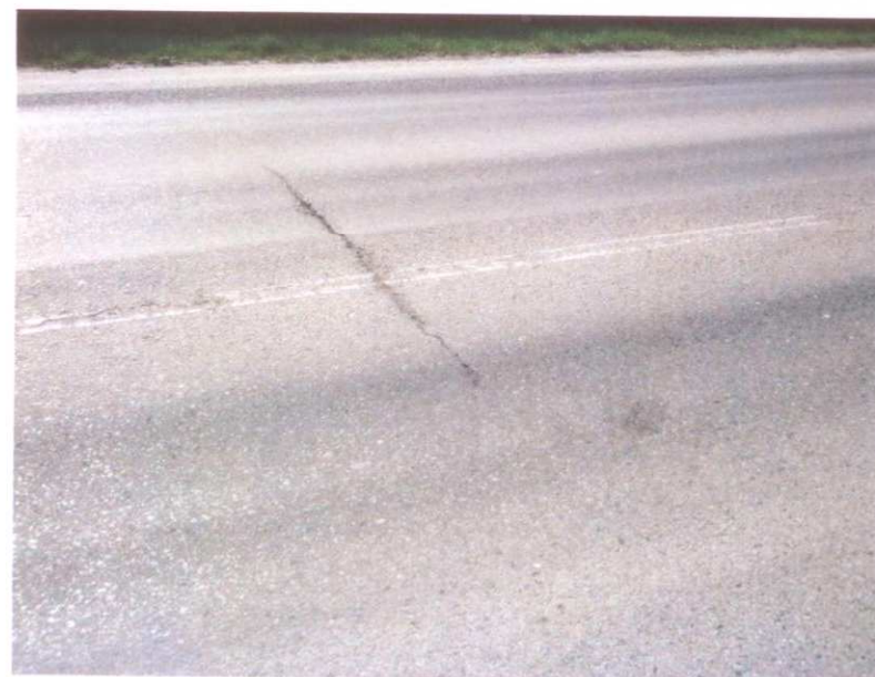
Ztráta makrotextury, příčná trhлина
