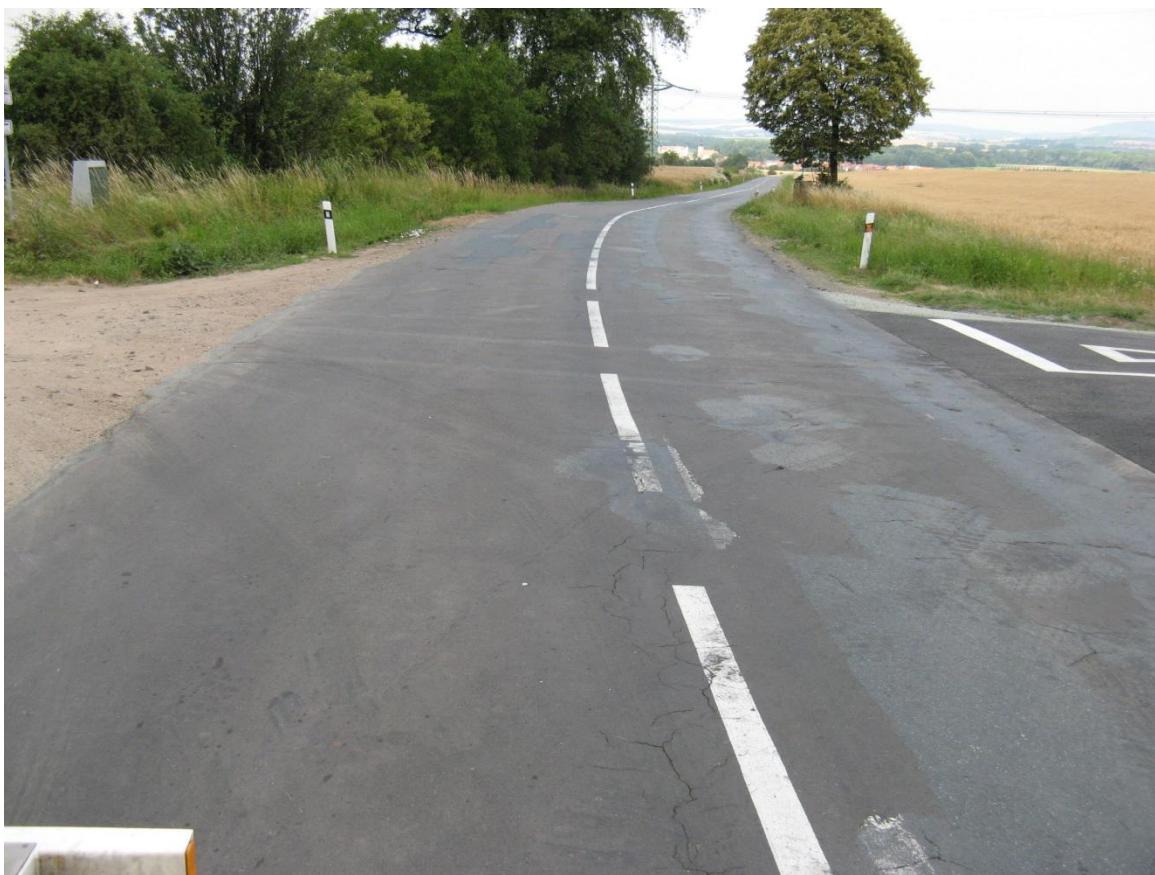
F14, km 59,410+ Drobné trhlinky - mozaikové.
