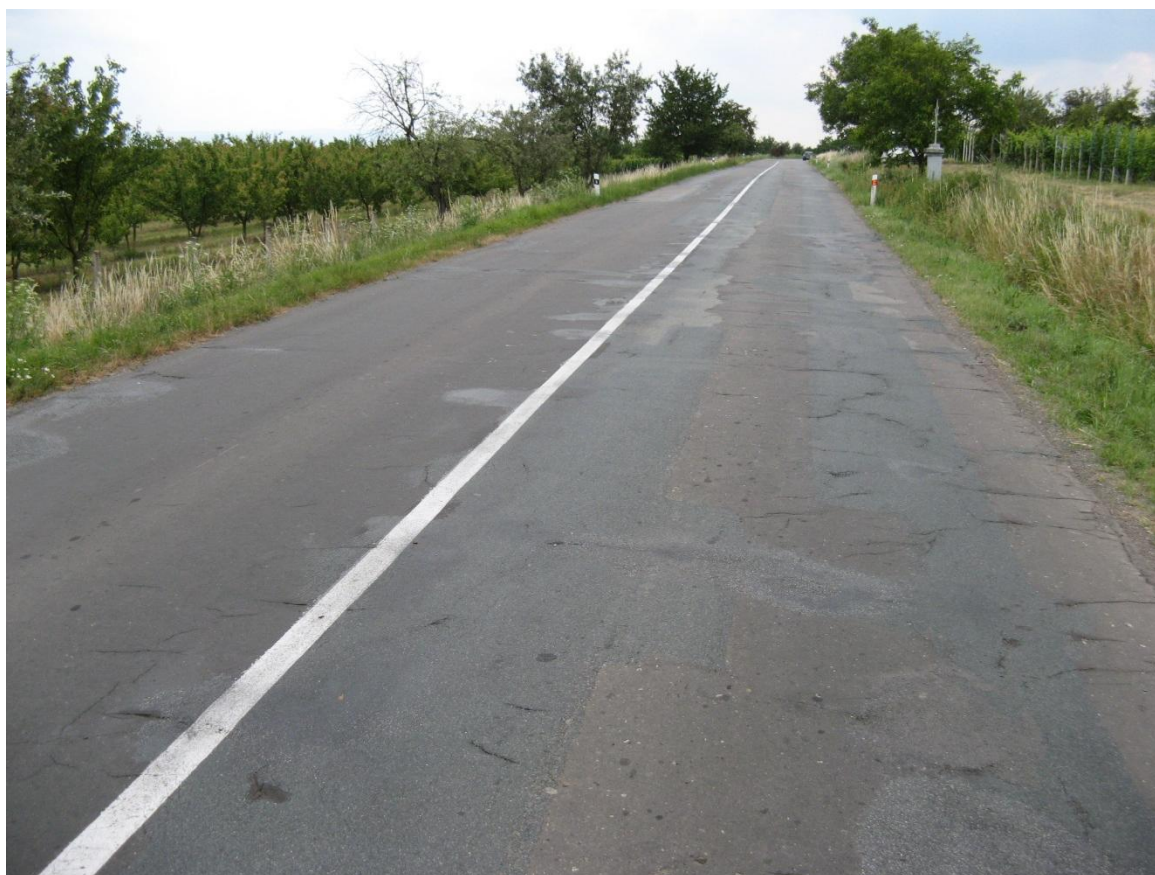
F14, km 59,410+ Celoplošně mozaikové trhliny.
