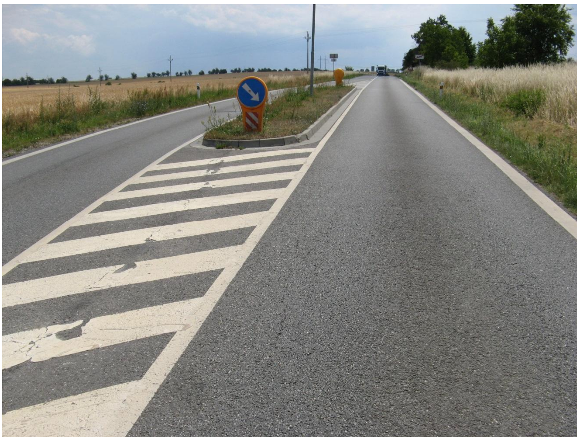
F02, km 58,215+ Ztráta asfaltového tmelu, podélné rozvětvené trhliny.
