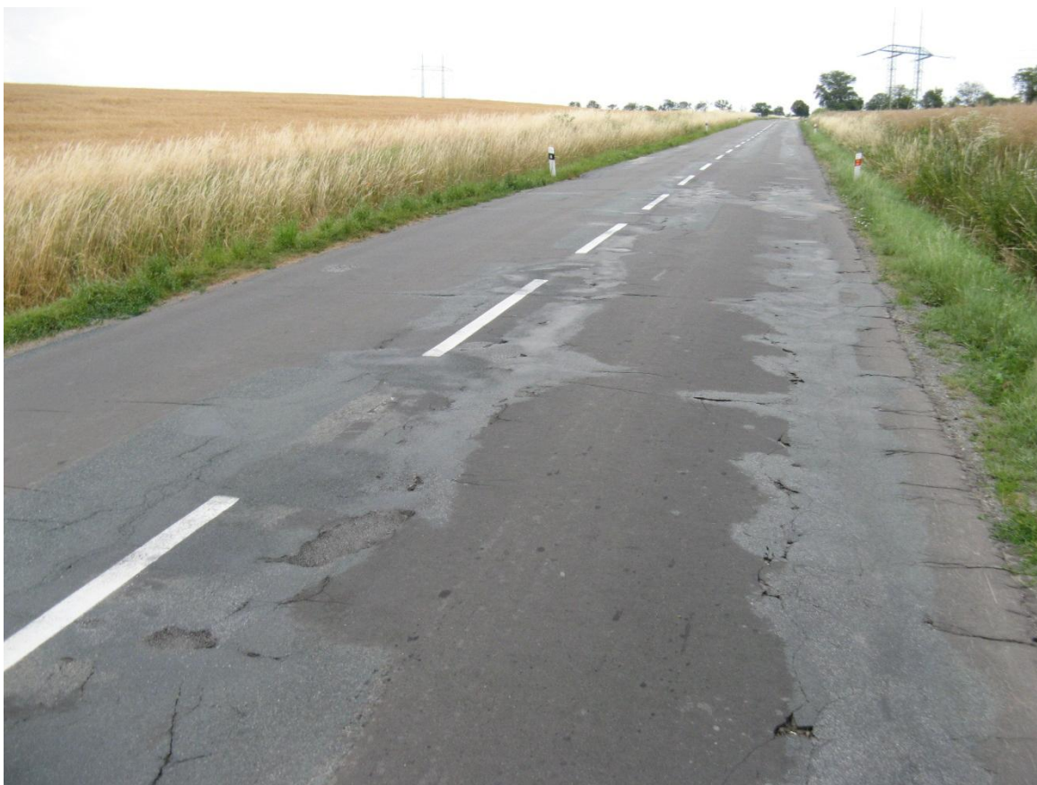
F10, km 59,010+ Mozaikové trhliny, síťové trhliny podél okraje vozovky.
