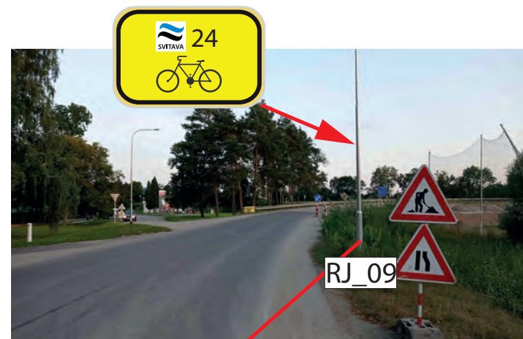
INSTALOVAT IS 21a (24+SVITAVA) NA SLOUP OSVĚTLENÍ
