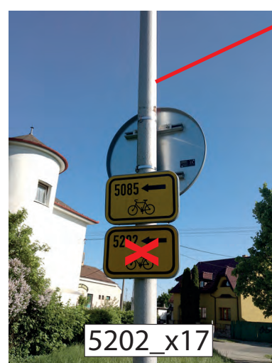
DEMONTOVAT STÁVAJÍCÍ IS 21b (5202) RUŠENÉ TRASY ZE SLOUPU VEŘEJNÉHO OSVĚTLENÍ
