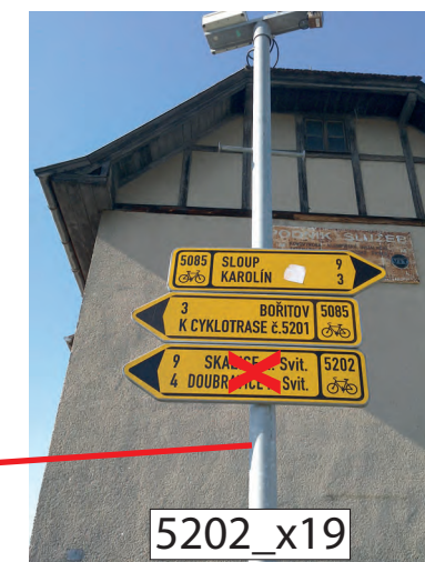
DEMONTOVAT STÁVAJÍCÍ IS 19b (5202) RUŠENÉ TRASY ZE SLOUPU VEŘEJNÉHO OSVĚTLENÍ
