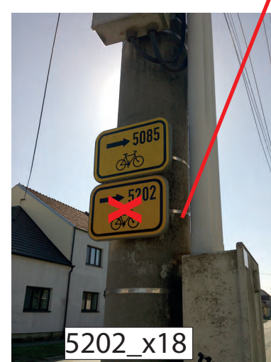
DEMONTOVAT STÁVAJÍCÍ IS 21c (5202) RUŠENÉ TRASY Z BETONOVÉHO SLOUPU
