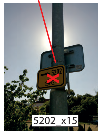
DEMONTOVAT STÁVAJÍCÍ IS 21b (5202) A IS 21c (5202) RUŠENÉ TRASY Z BETONOVÉHO SLOUPU
