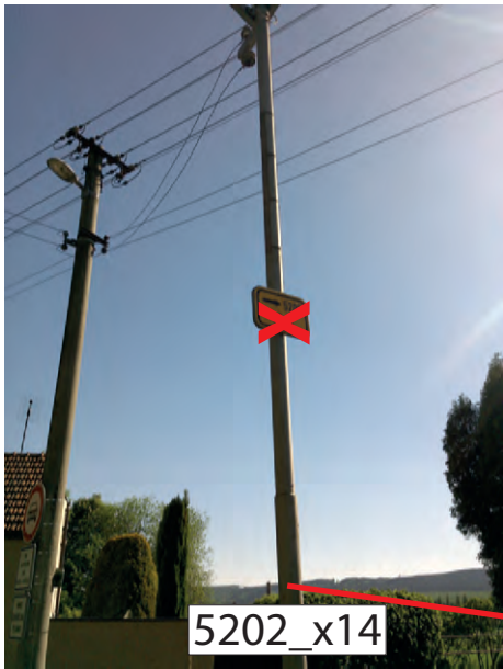
DEMONTOVAT Z VEŘEJNÉHO OSVĚTLENÍ STÁVAJÍCÍ IS 21c (5202) RUŠENÉ TRASY
