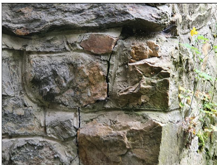
Trhlina v nároží
