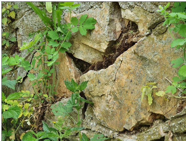
Porušené spárování na křídle
