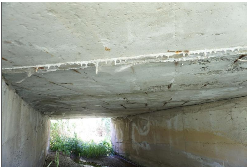
Detail pohledu nosné konstrukce, malá krycí vrstva betonu, koroze výztuže.
