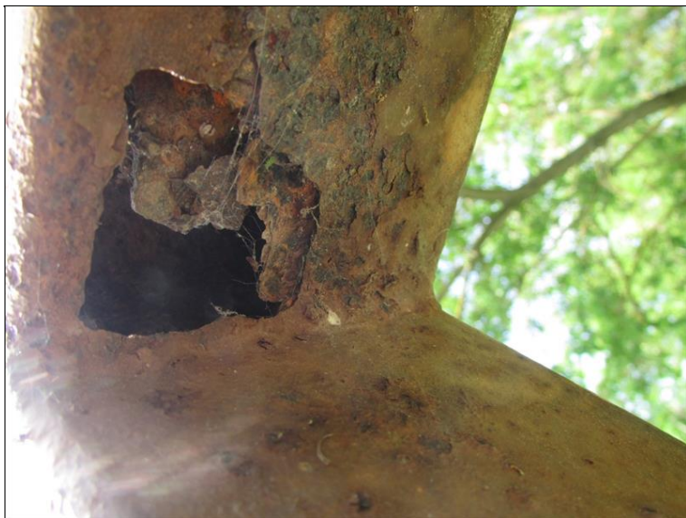
Silná koroze zábradlí
