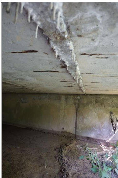
Detail spáry u krajního pravého nosníku - zřetelné prosakování vlhkosti, výluhy, tvorba inkrustů.
