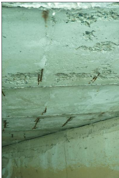
Detail pohledu nosné konstrukce, malá krycí vrstva betonu, koroze výztuže.
