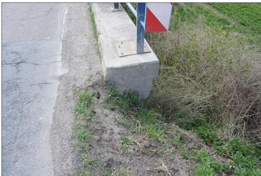
Detail nenávaznosti říms na okolní terén - opěra OP1 vpravo.
