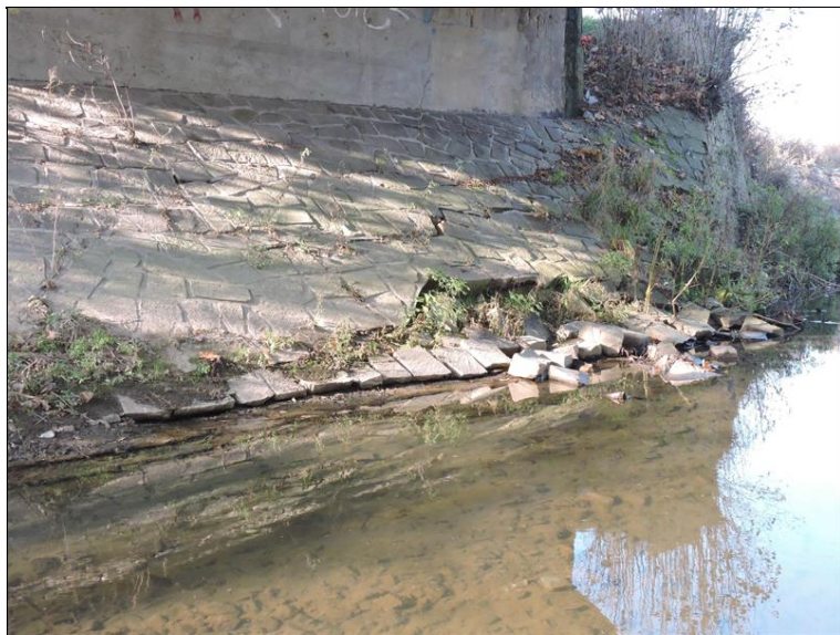
OP1 - pata OP - rozpad zádlažby
