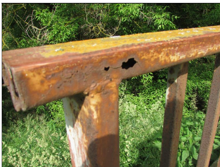
Silná koroze zábradlí
