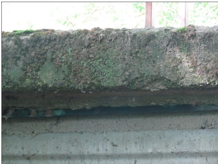
Degradace římsy
