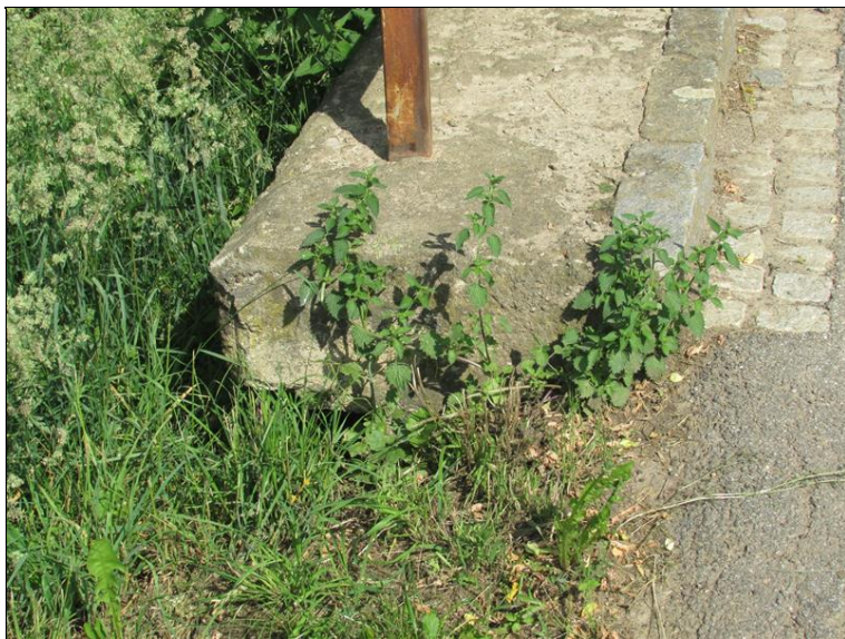
Chybějící napojení obruby na krajnici
