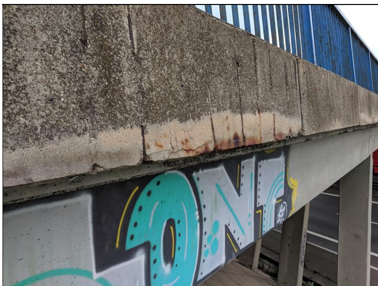
Degradace líců říms, obnažená výztuž
