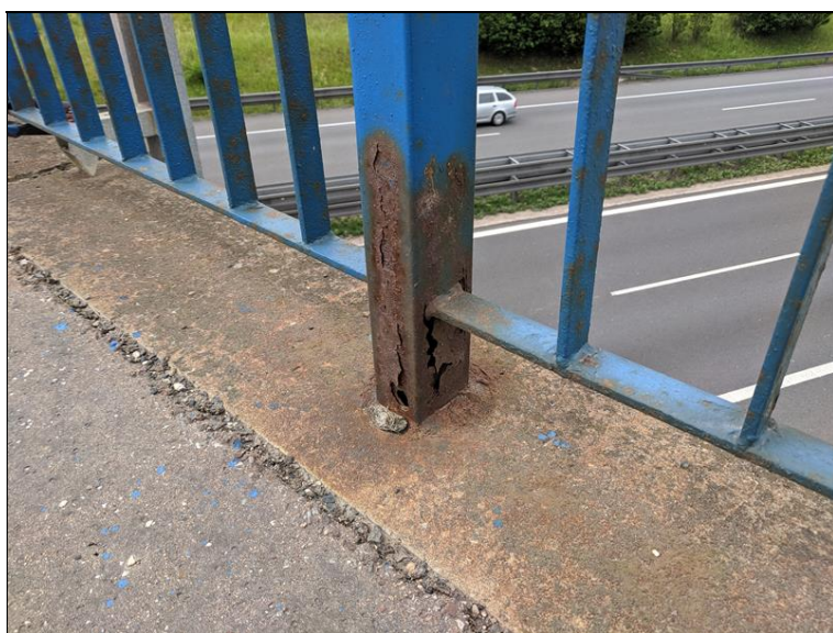
Zkorodovaný sloupek zábradlí
