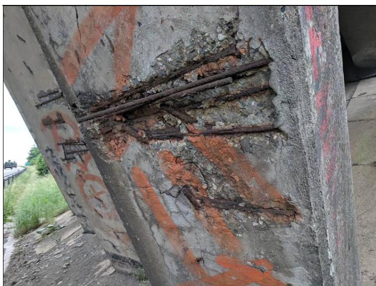
Odpadaná krycí vrstva betonu na vzpěrách, koroze výztuže (vzpěra ve 3. poli vpravo)
