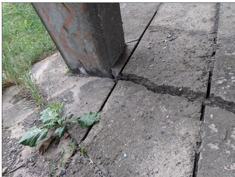
Prasklina v desce ve svahu, vegetace ve spárách desky.
