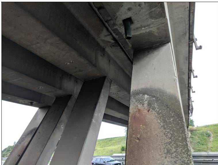
Nevhodné vyústění odvodňovače na povrch vzpěry
