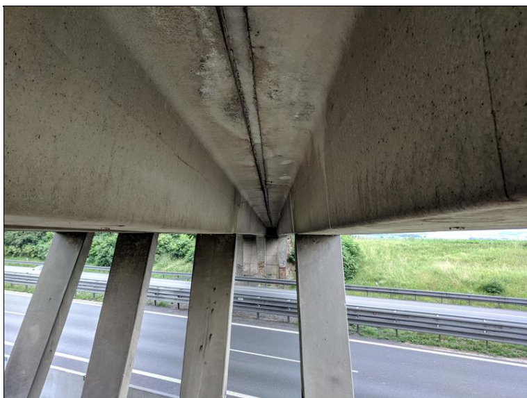
Stopy zatékání spárami mezi nosníky
