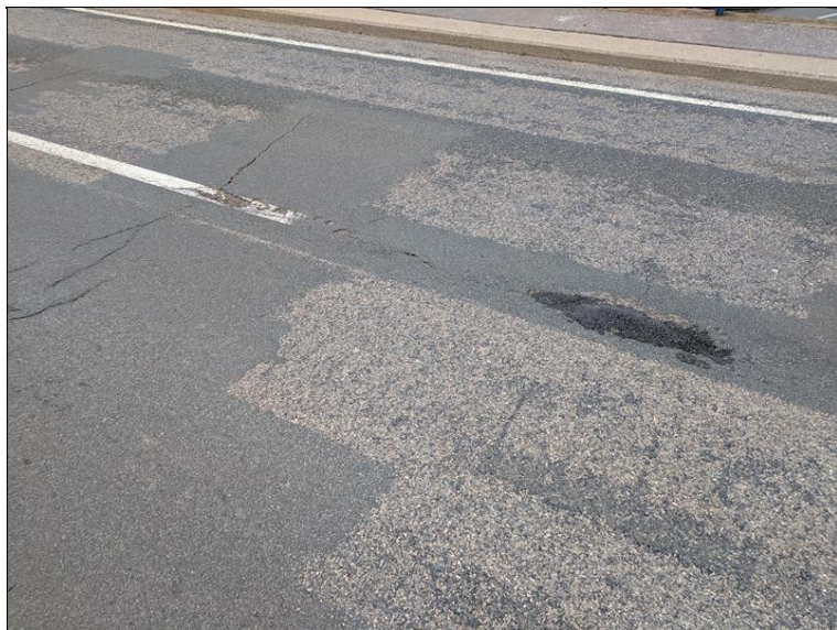
Trhliny v krytu vozovky, vysprávkvy
