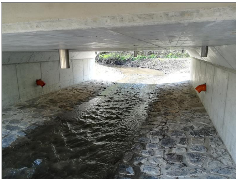
Detail - pohled na základnu dna, odvodnění zpoza rubu opěr
