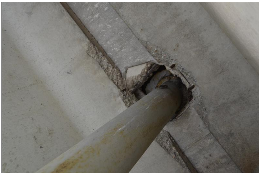
Detail prostupu odvodnění skrz nosnou konstrukci
