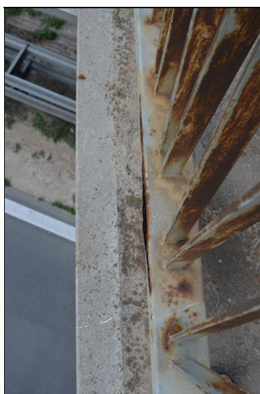
Koroze zábradlí
