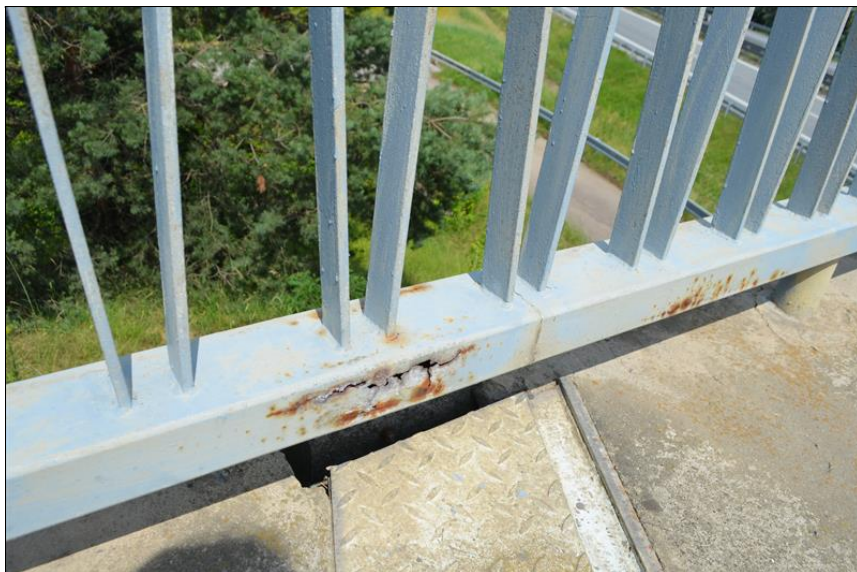
Koroze zábradlí
