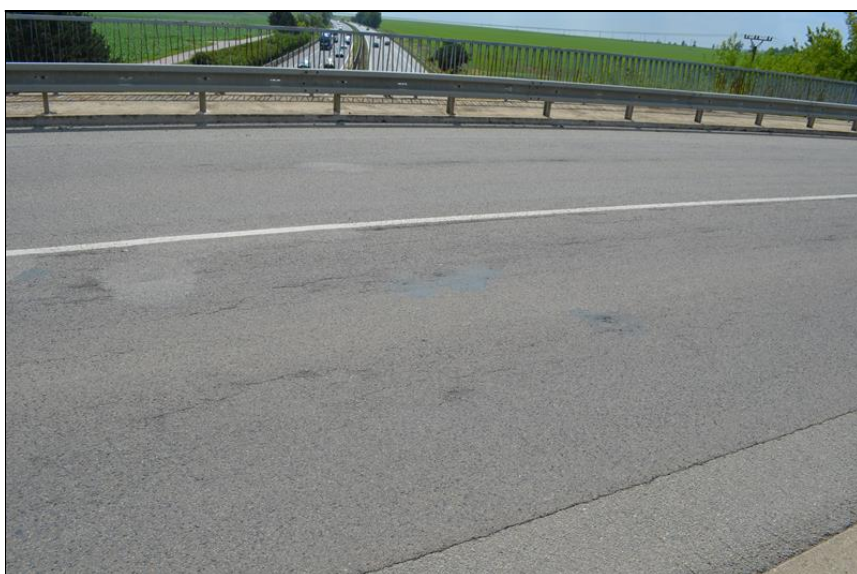
Podélné trhliny ve vozovce
