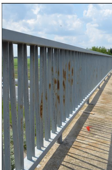
Koroze zábradlí
