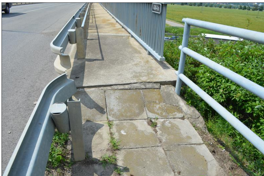
Napojení svodidel a chodníku
