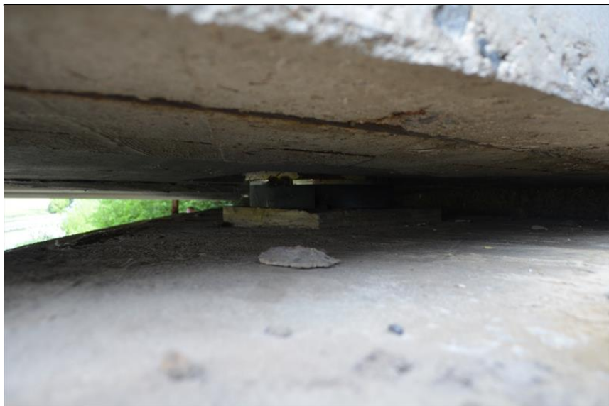
Koroze ložisek
