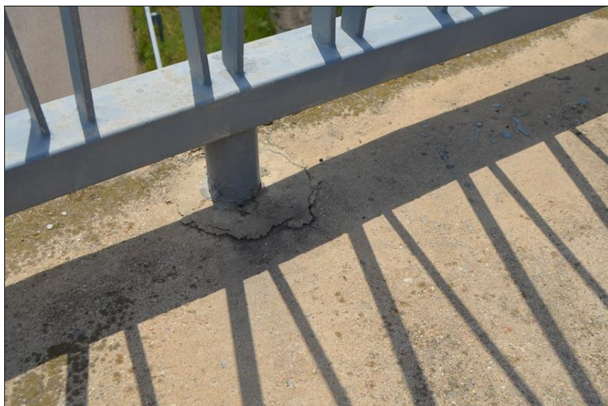
Koroze zábradlí
