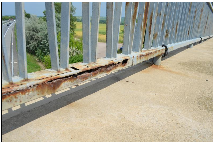
Detail korodujícího zábradlí
