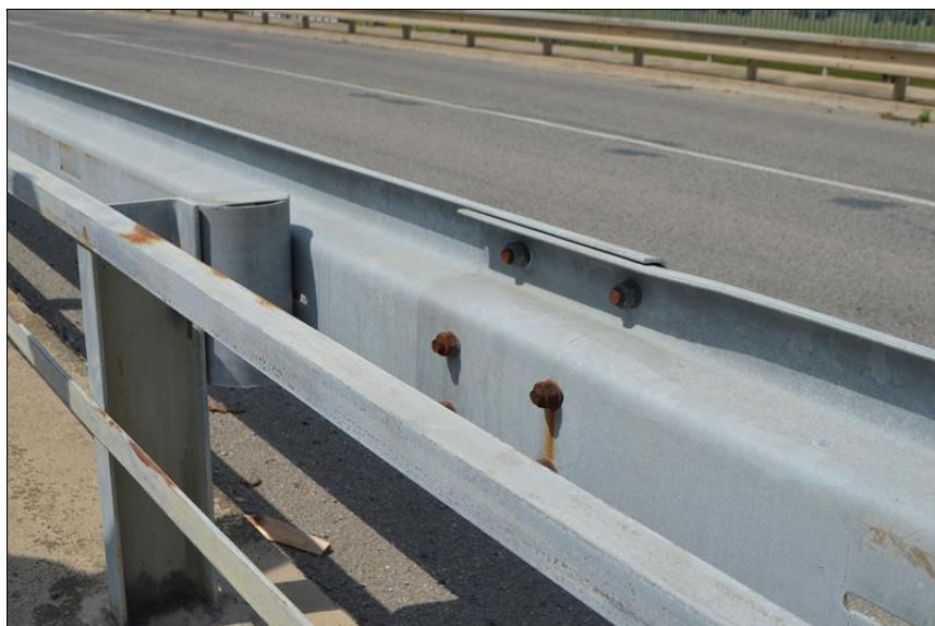
Koroze spojovacího materiálu svodidel
