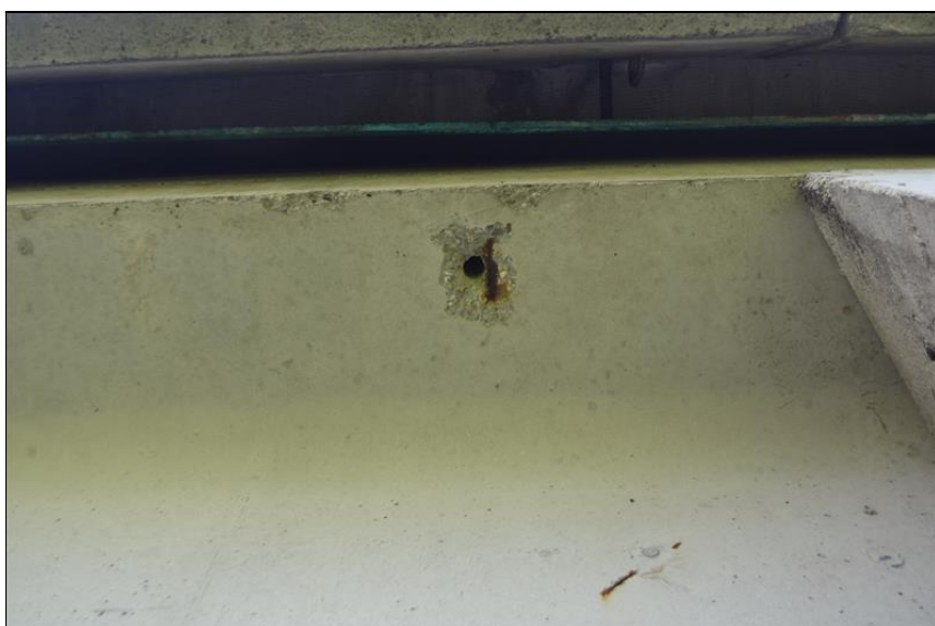
Obnažená výztuž u odvodňovače
