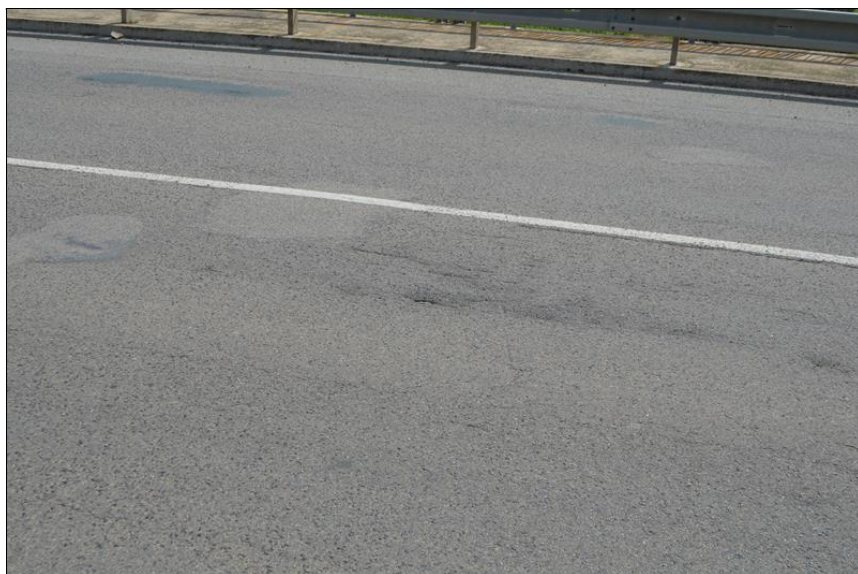
Podélné trhliny ve vozovce
