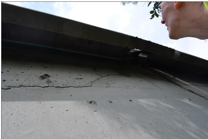
Svislá trhlina na OP2
