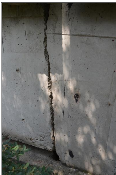
Svislá trhlina na OP2
