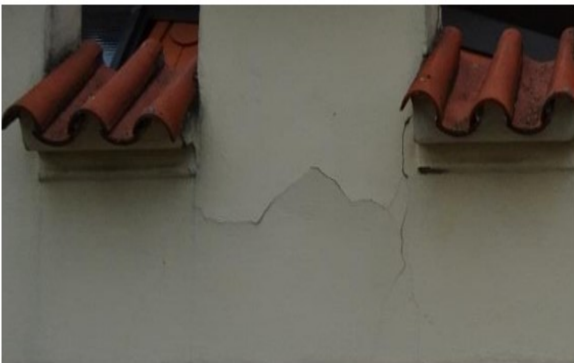
Obr. 6 – prasklina na fasádě u cimbuří
