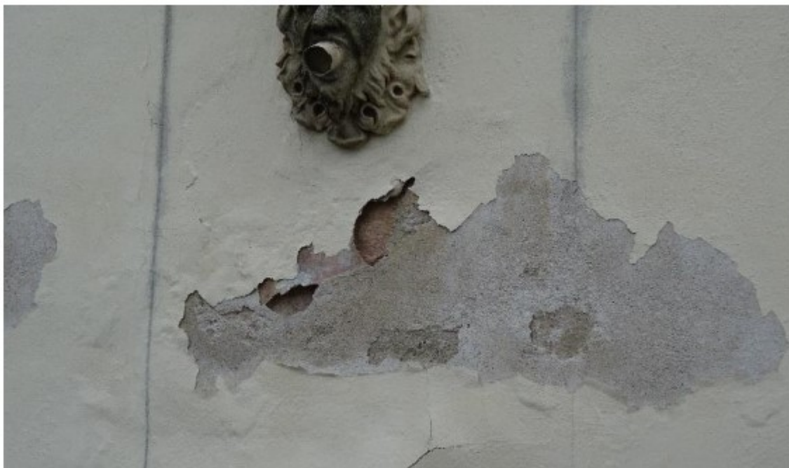
Obr. 4 – zvětralá a odpadající omítka na fasádě
