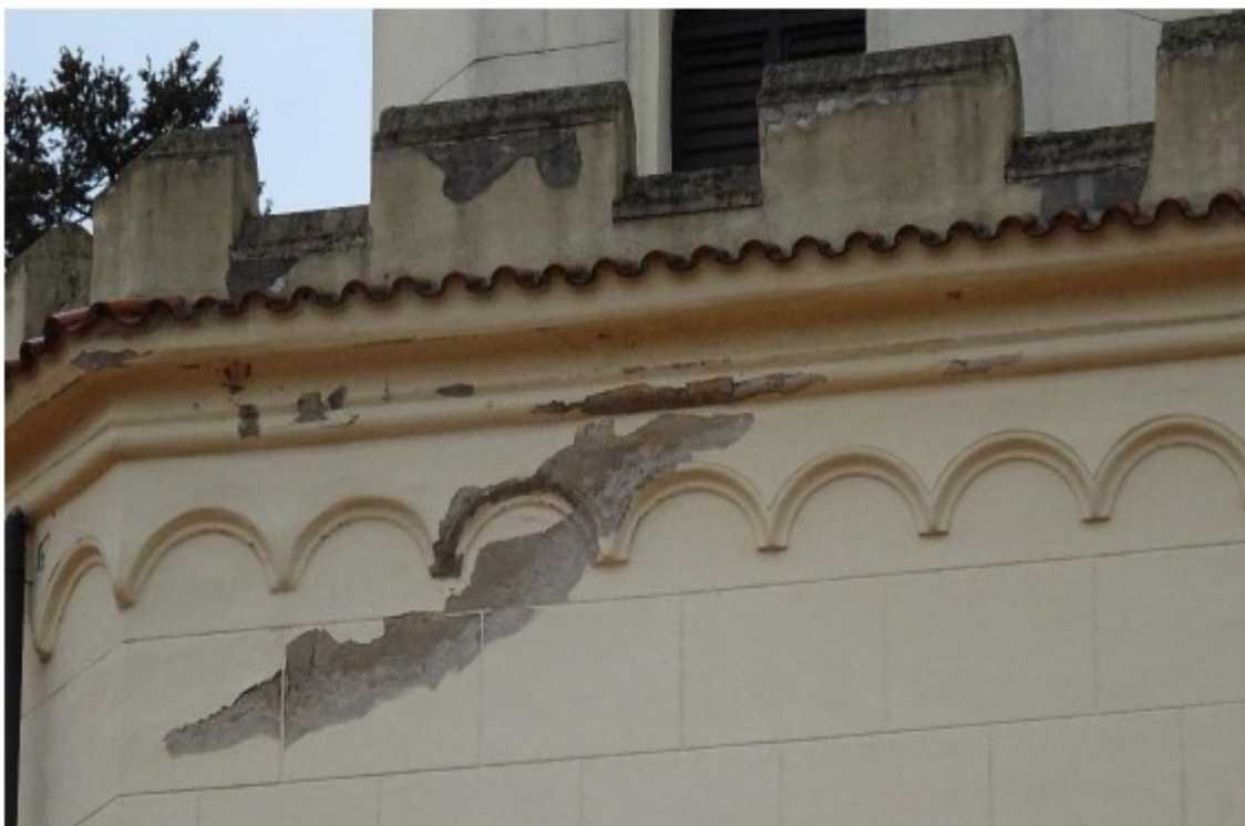
Obr. 5 – zvětralá fasáda na ozdobné římse
