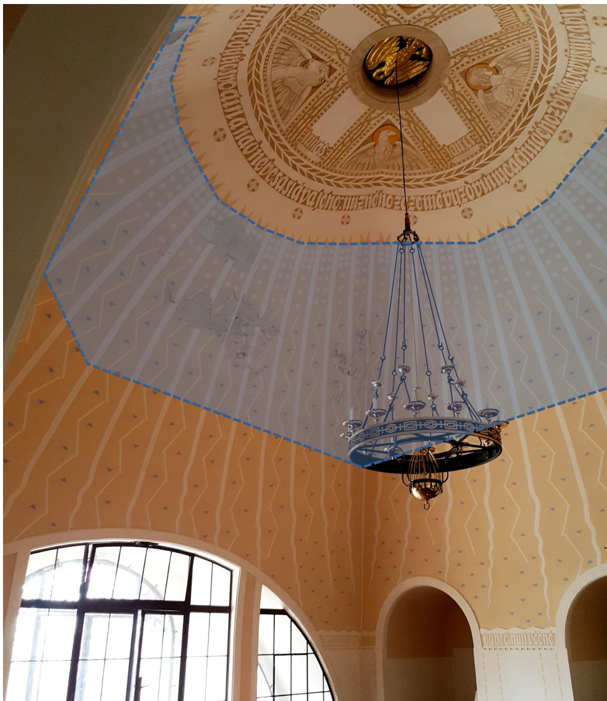
Příloha 1: vymezení kulové úseče klenby, na které se vymění omítkové souvrství (orientační zákres do foto)
