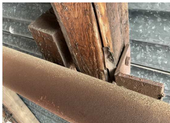
uložení krokví na vazník, detail kotvení
