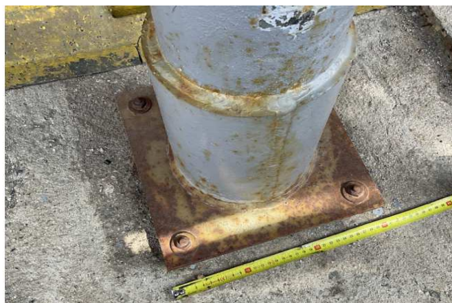
styčník sloup - vazník; patka sloupu
