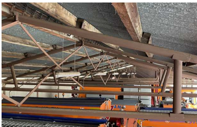
uložení krokví na vazník, detail kotvení
