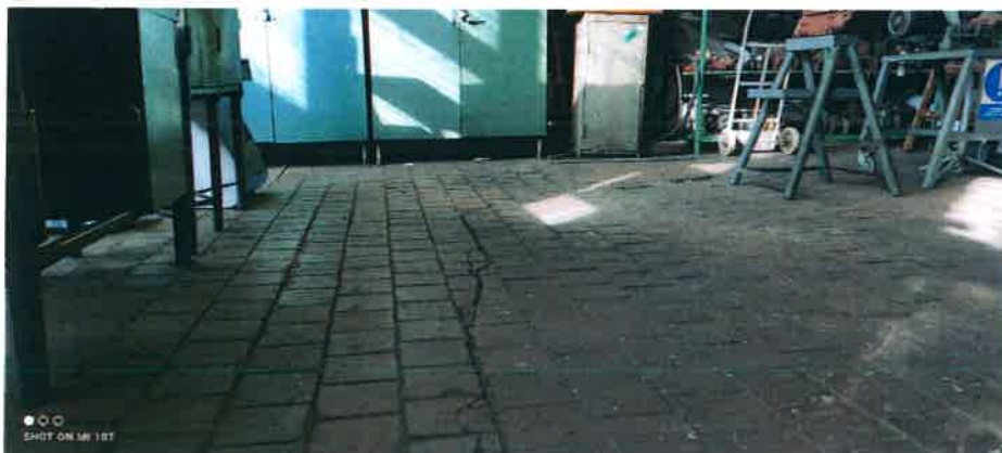
Obr. 16 – poklesy podlah v dílně v přízemí
