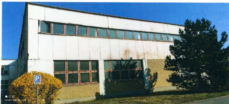
Obr. 1 – pohled na jižní fasádu kotelny
