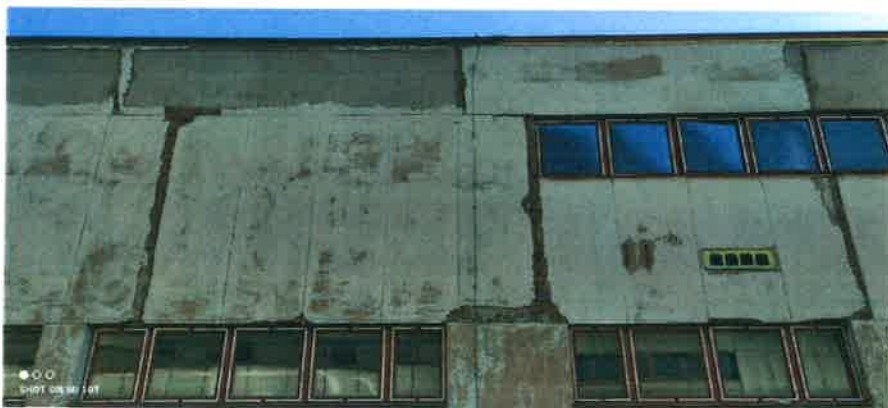
Obr. 4 – pohled na západní fasádu kotelny
