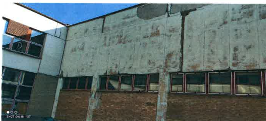
Obr. 3 – pohled na západní fasádu kotelny
