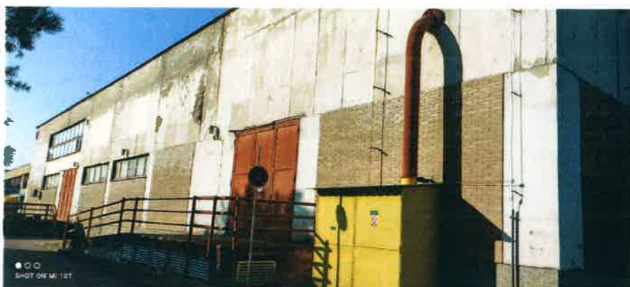
Obr. 2 – pohled na východní fasádu kotelny
