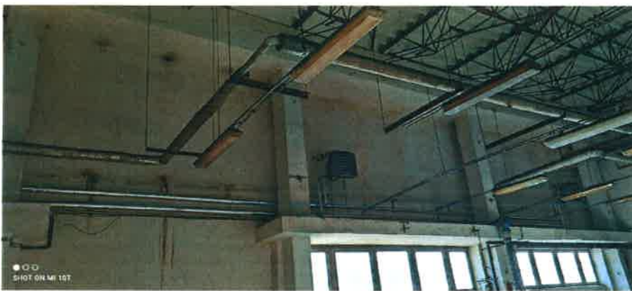
Obr. 9 – pohled na vnitřní konstrukci s ocelovou konstrukcí zastřešení
