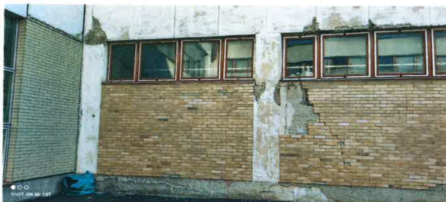
Obr. 5 – pohled na západní fasádu kotelny
