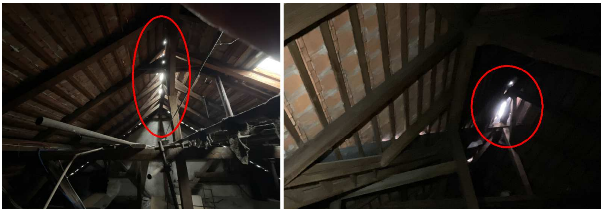
chybějící hřebenače v objektu A
