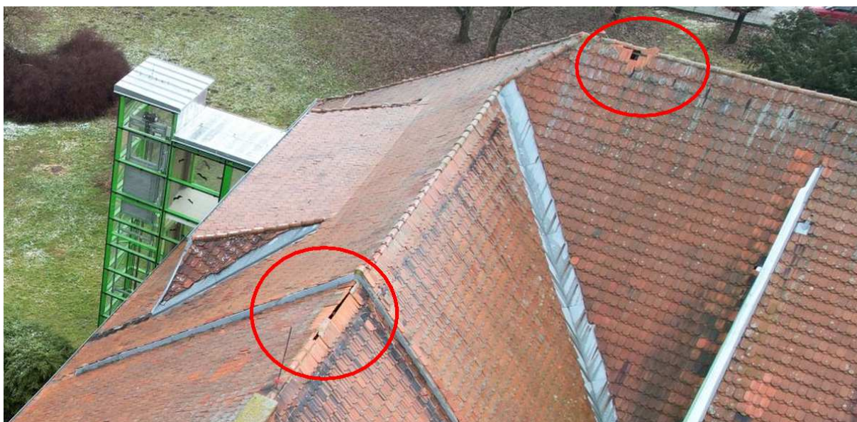
lokální poruchy objekt D, A
