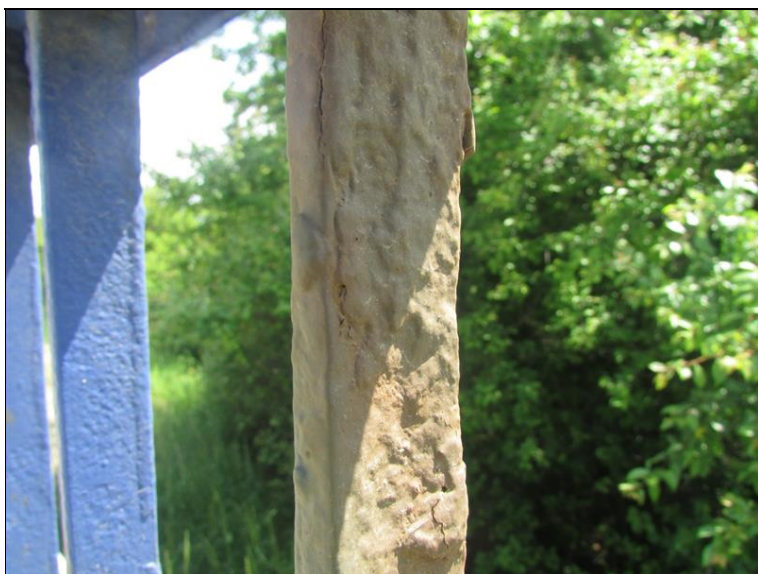
Koroze výplně zábradlí
