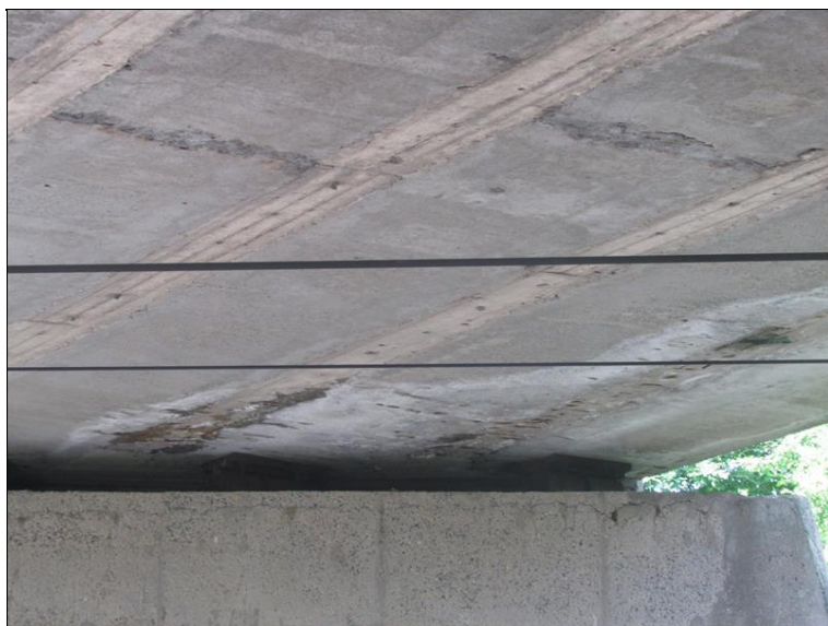
Mapy a stopy po zatékání na podhledu NK u OP1
