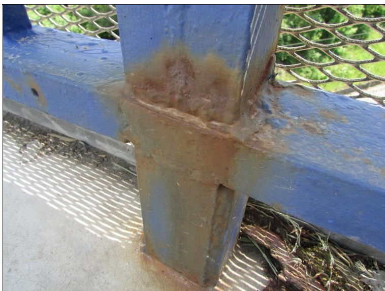
Koroze zábradlí
