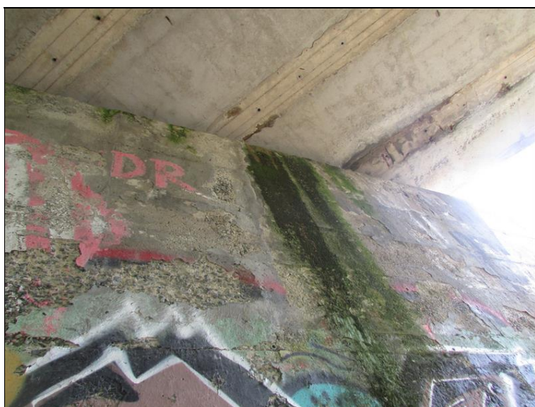
Zatékání přes úložný práh OP2
