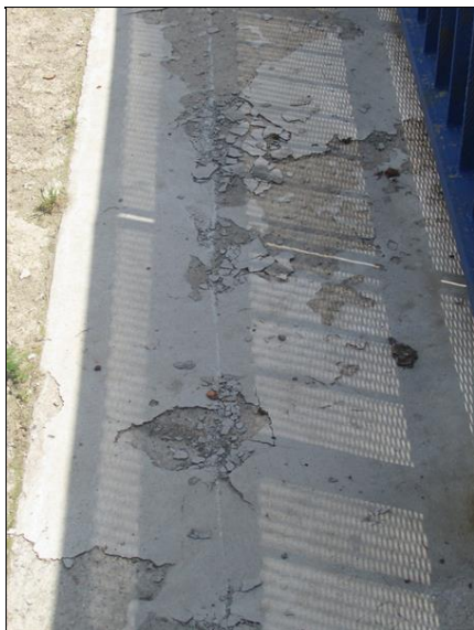
Degradace povrchu římsy
