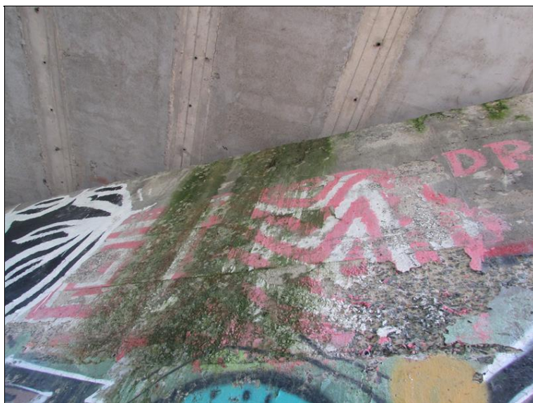
Zatékání přes úložný práh OP2
