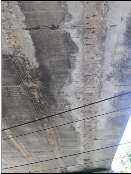
Podhled NK s mapami po zatékání do spáry mezi nosníky
