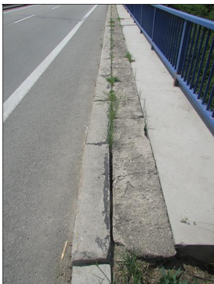
Uvolněné obrubníky s uchycenou vegetací
