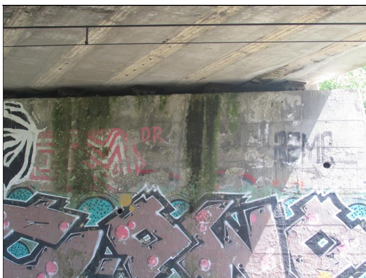
zatékání přes úložný práh na OP2
