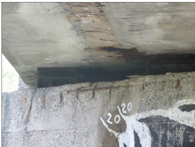
Degradace úložného prahu OP1 vlivem zatékající vody
