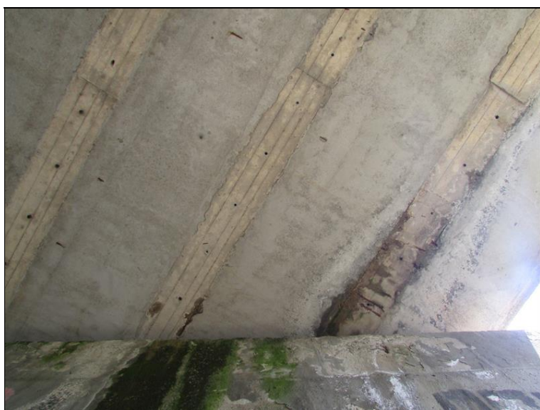
Zatékání na OP2
