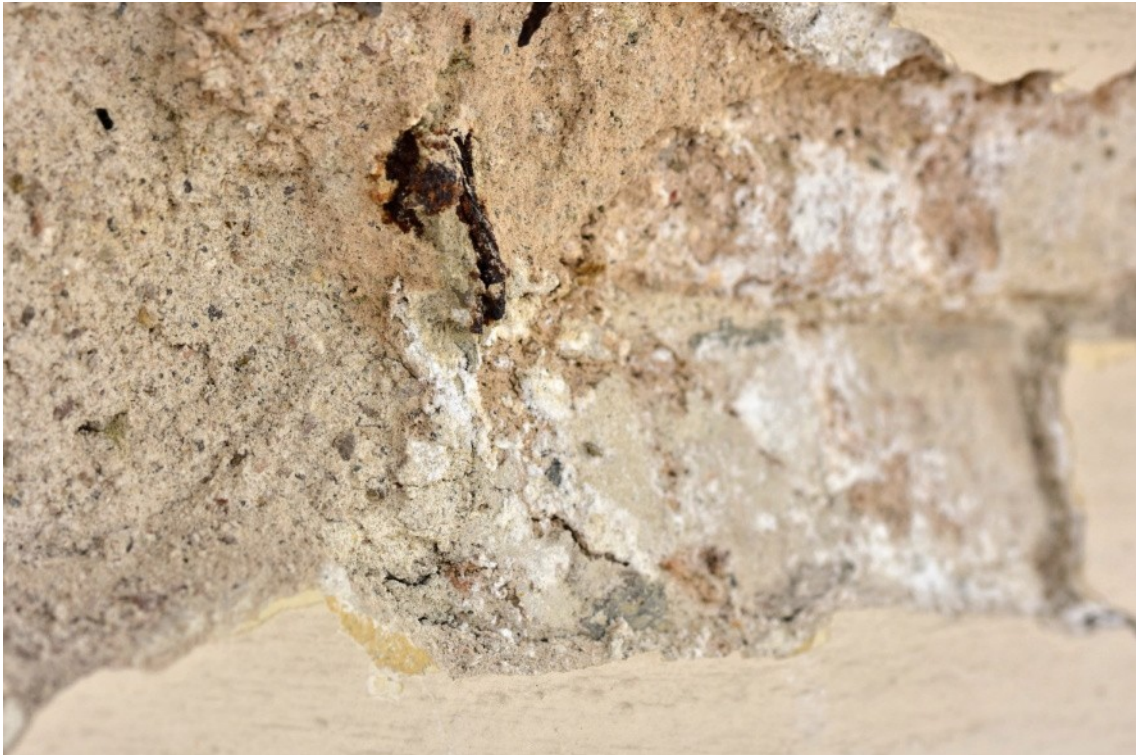
detaily poškození profilované římsy se zbytky kotvení oplechování
