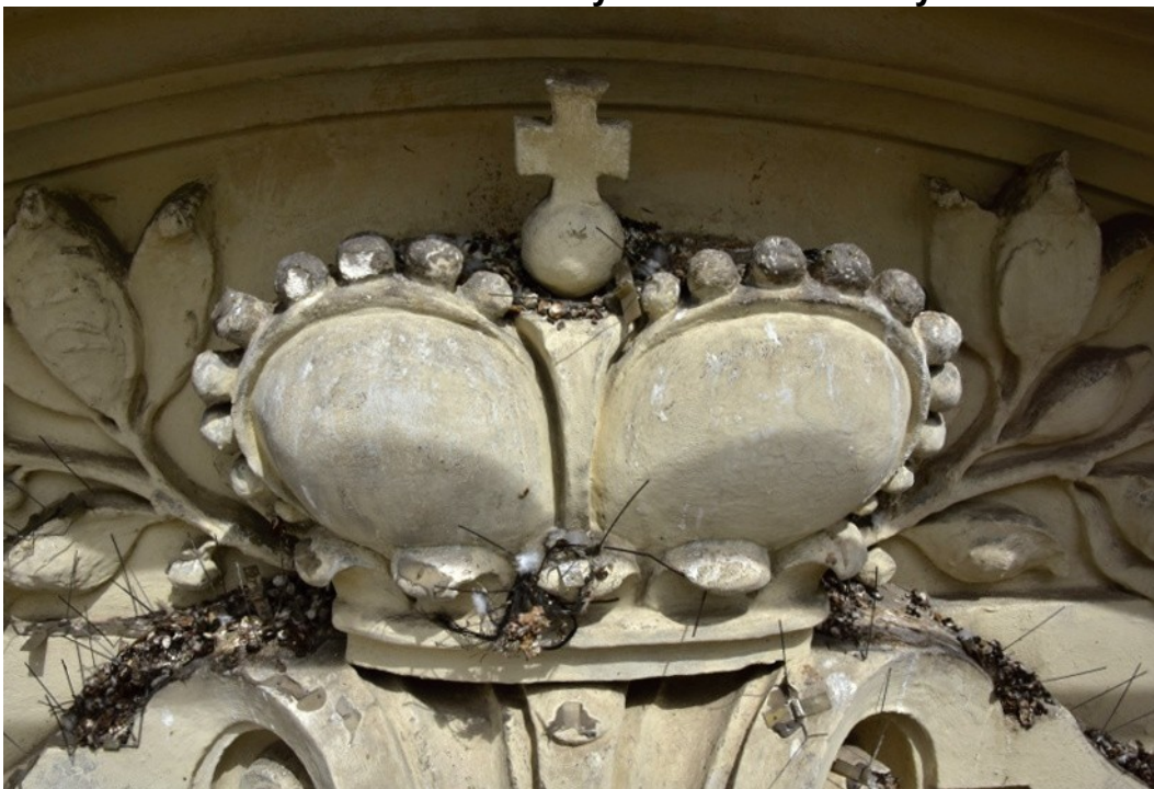
čelní pohled detail klenotu – koruny / znečištění holuby
