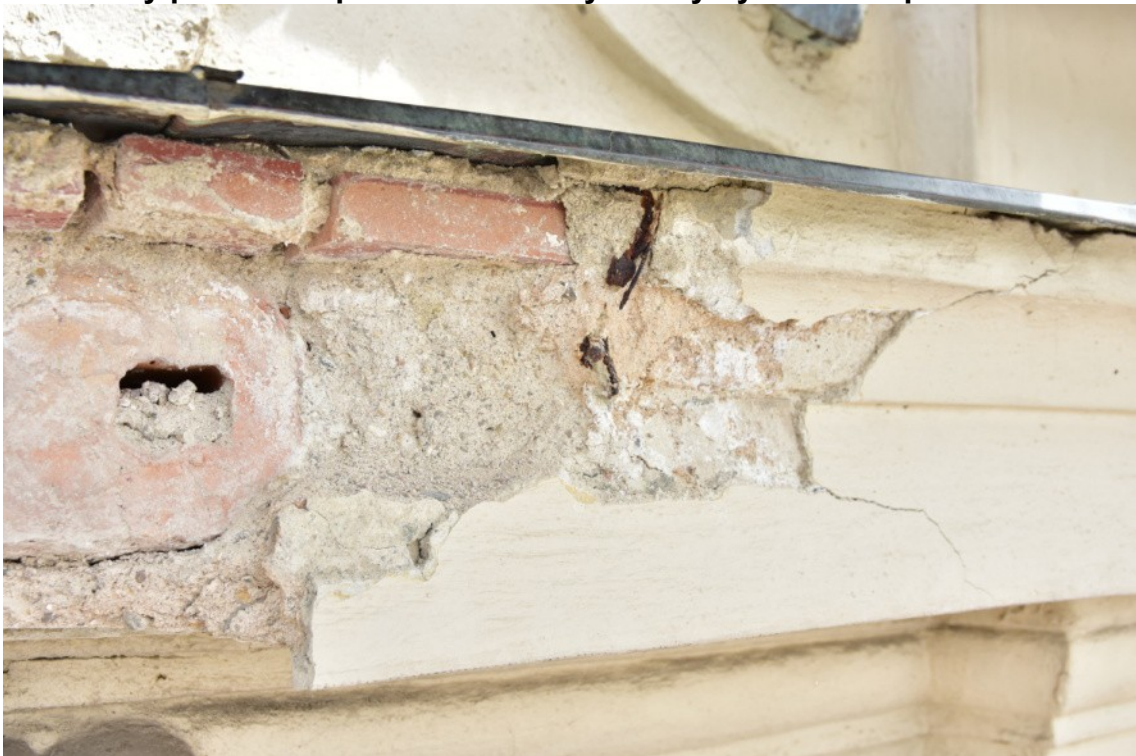
detaily poškození profilované římsy se zbytky kotvení oplechování
