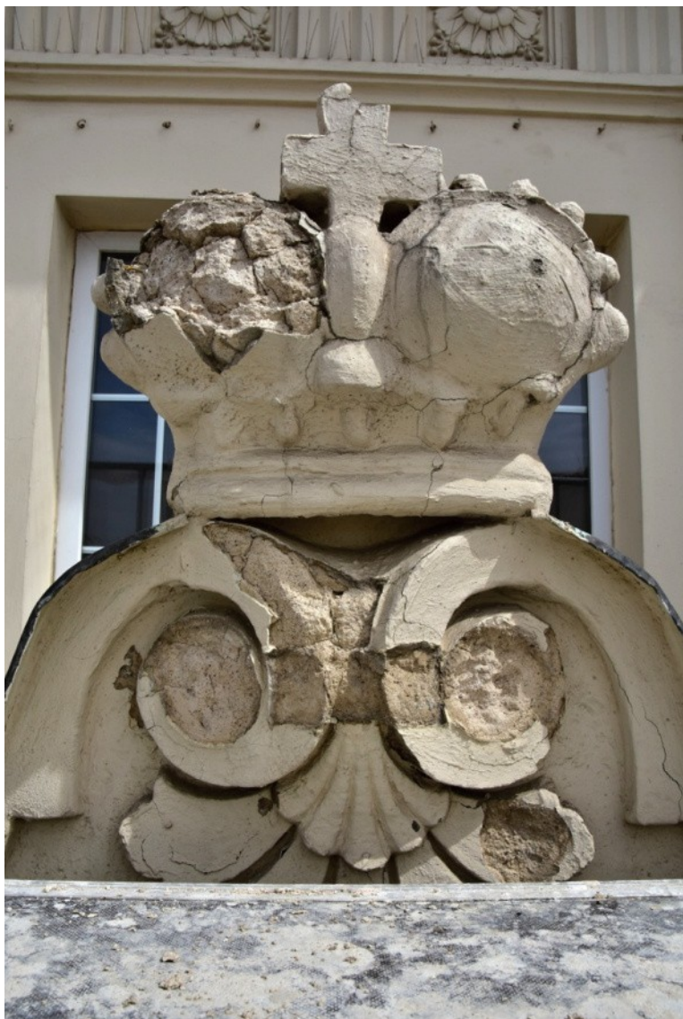
detail klenotu – koruny / silná degradace materiálu za hranicí životnosti
