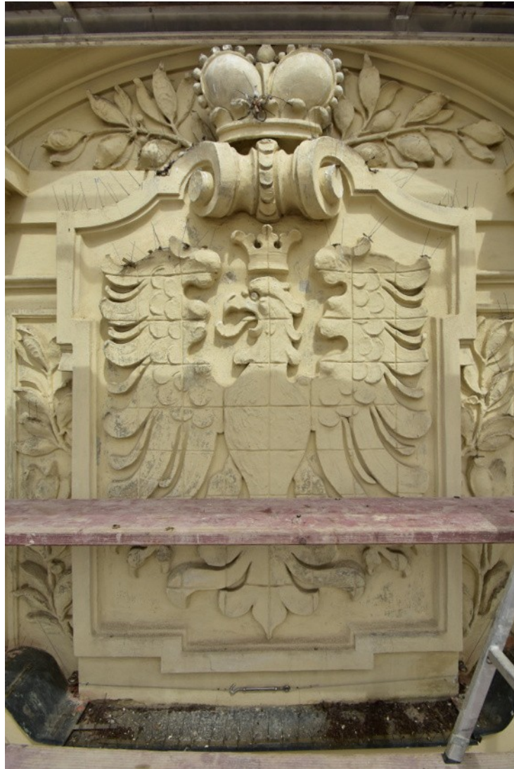
čelní pohled detail klenotu – koruny / znečištění holuby
