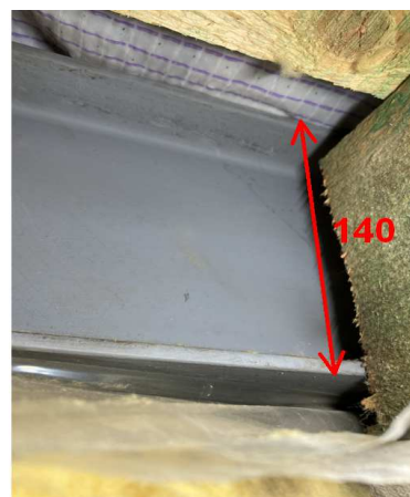
konec ocelové krokve v podstřešním prostoru ; krokve v realizované sondě
