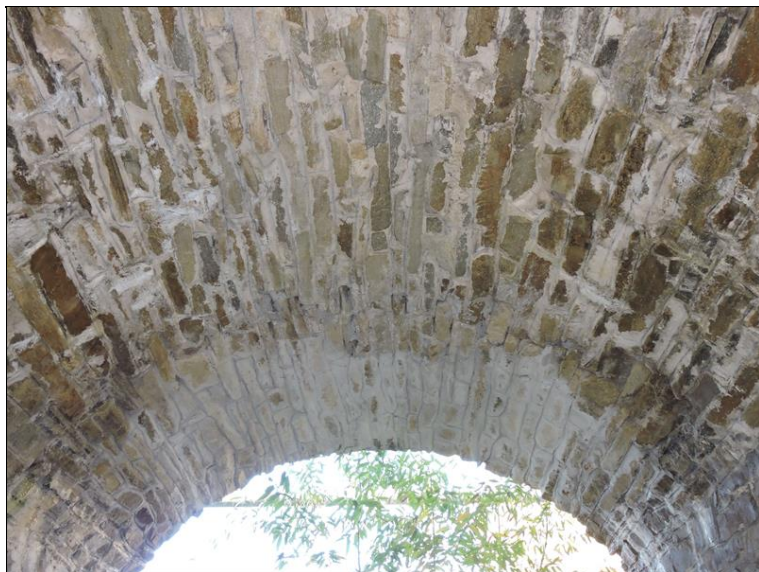
NK - podélná trhlina portálem
