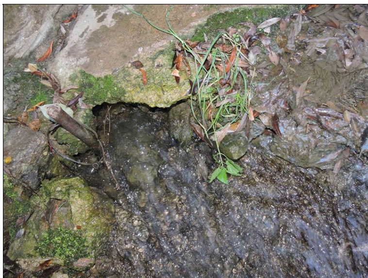
Voda protéká pod dobetonávkou.
