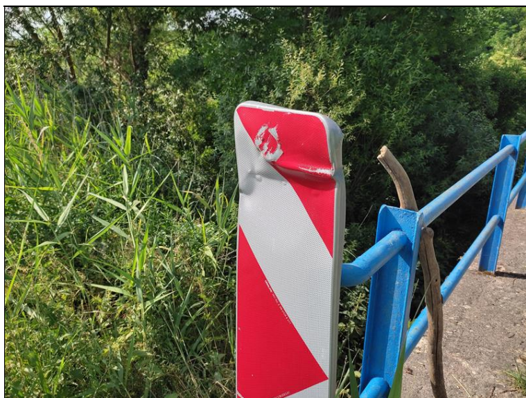
Deformace směrové desky na pravé straně OP2
