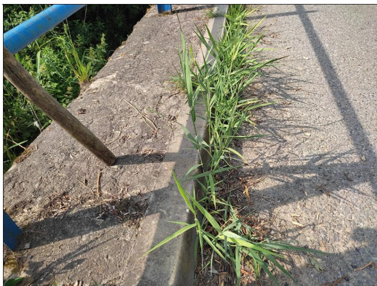
Uchycená vegetace ve spáře mezi obrubou a vozovkou
