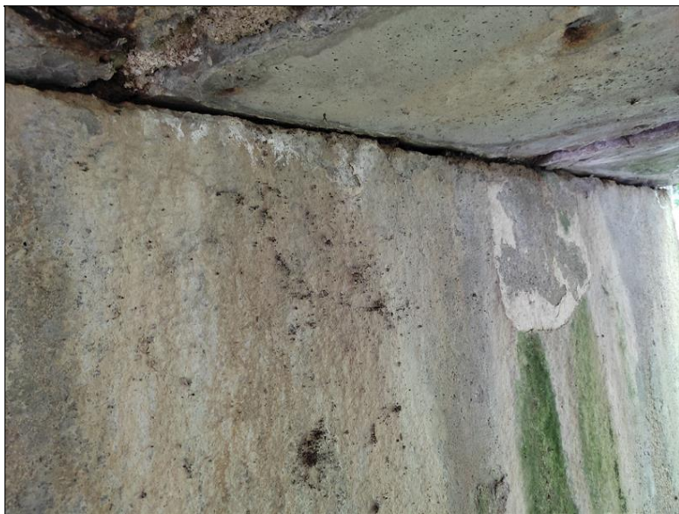
Stopy po zatékání z úložného prahu na levé straně OP1
