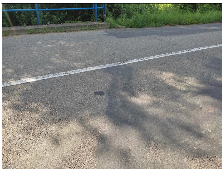
Příčná trhlinka na vozovce nad OP2
