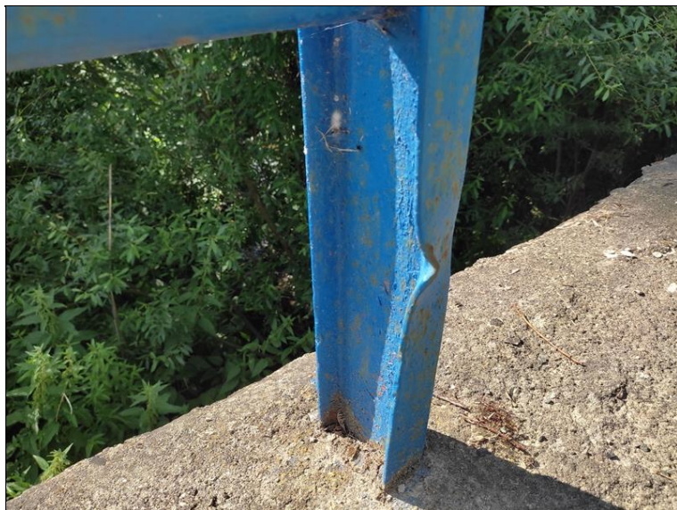
Deformace sloupku zábradlí
