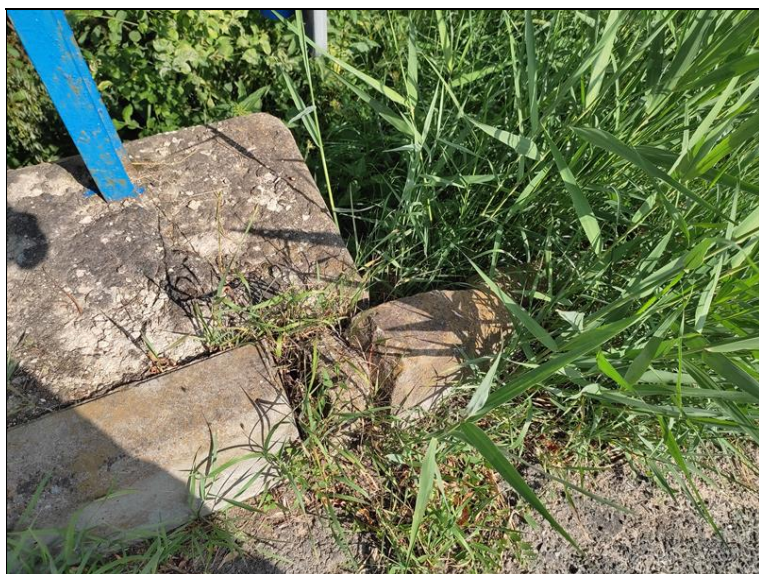
Rozvolněné obruby v předpolí OP2 vlevo
