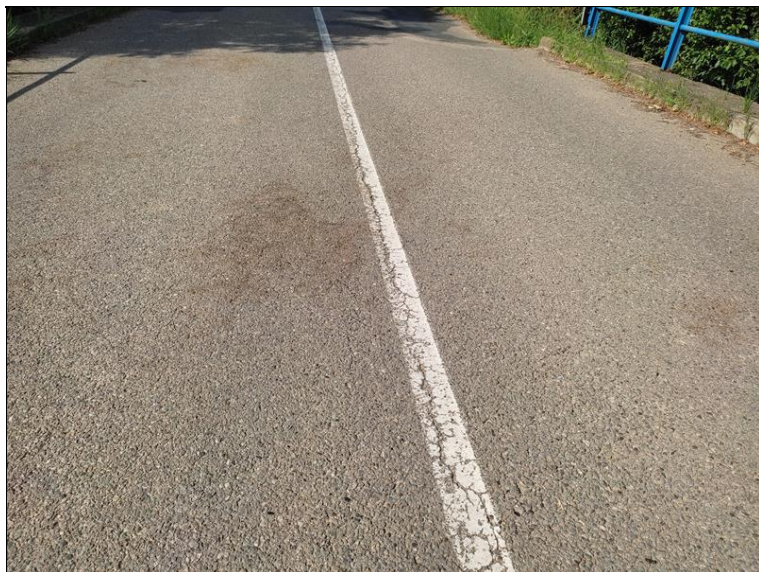
Podélná trhlinka v vozovce uprostřed šířky mostu
