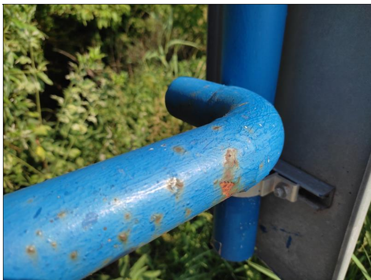
Koroze zábradlí
