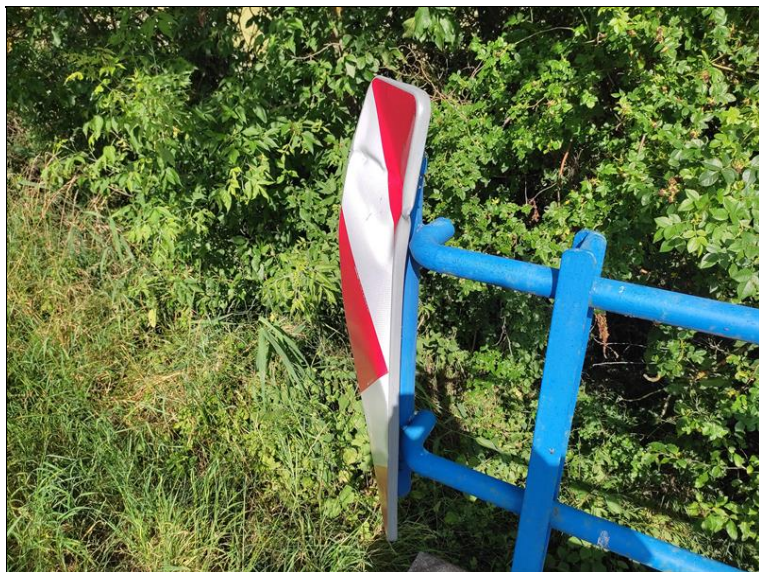
Deformace směrové desky OP1 vlevo
