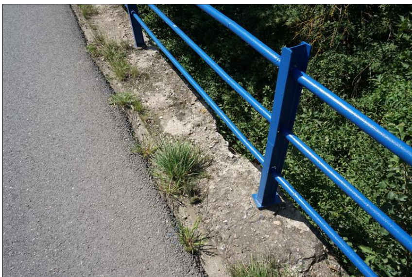
Detail římsy na levé straně - vyrůstající vegetace, převrstvená vozovka, rozpadlý povrch římsy
