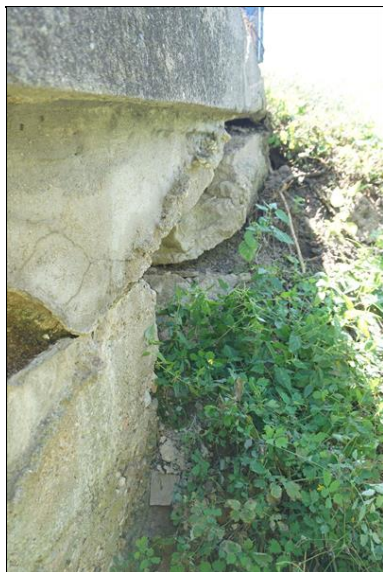
Rozpad levého křídla u opěry OP1
