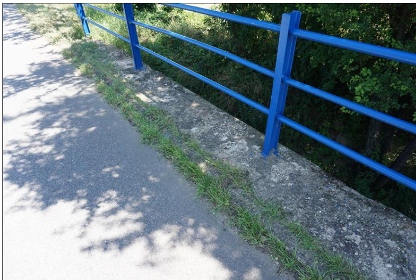
Detail římsy na pravé straně - vyrůstající vegetace, převrstvená vozovka.
