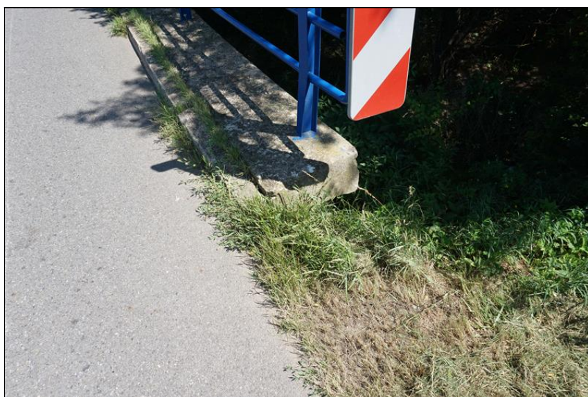
Konec pravé římsy u opěry OP1, nenávaznost římsy na terén za mostem
