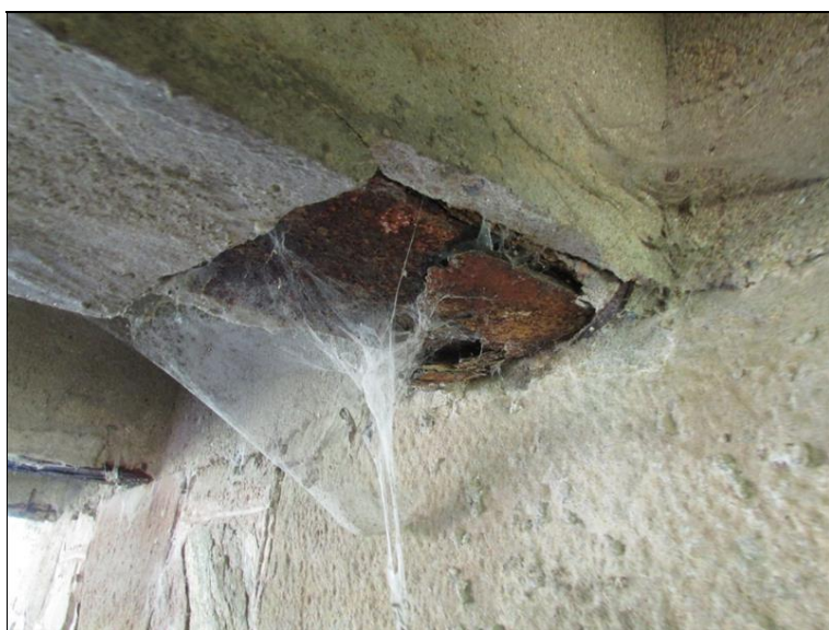
Podhled NK - trémová konstrukce - odpadlý beton, koroze ocelového profilu
