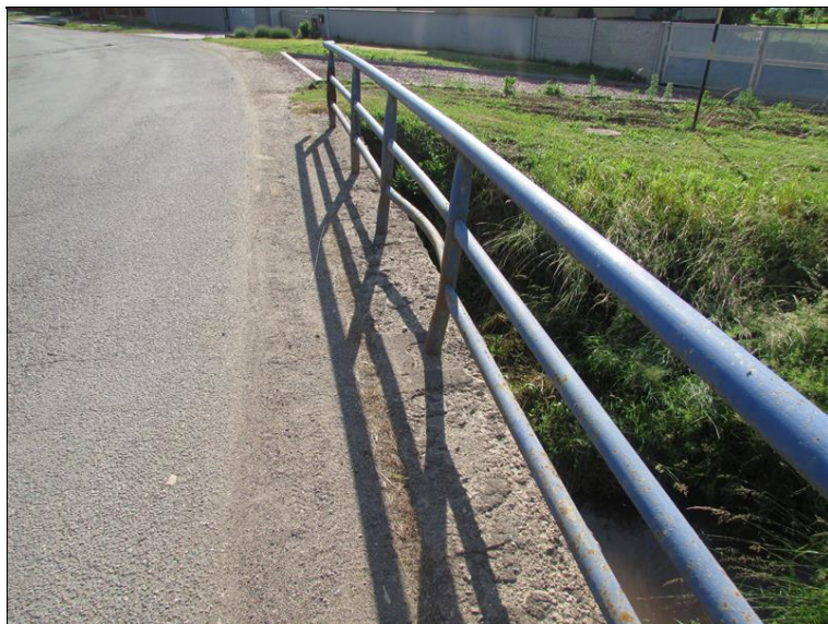
Deformace zábradlí na levé straně mostu
