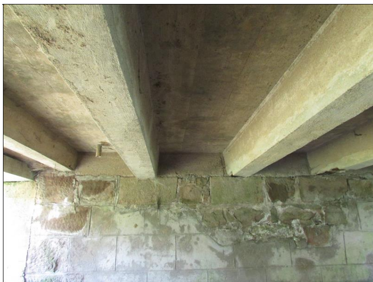
Podhled NK - trémová konstrukce
