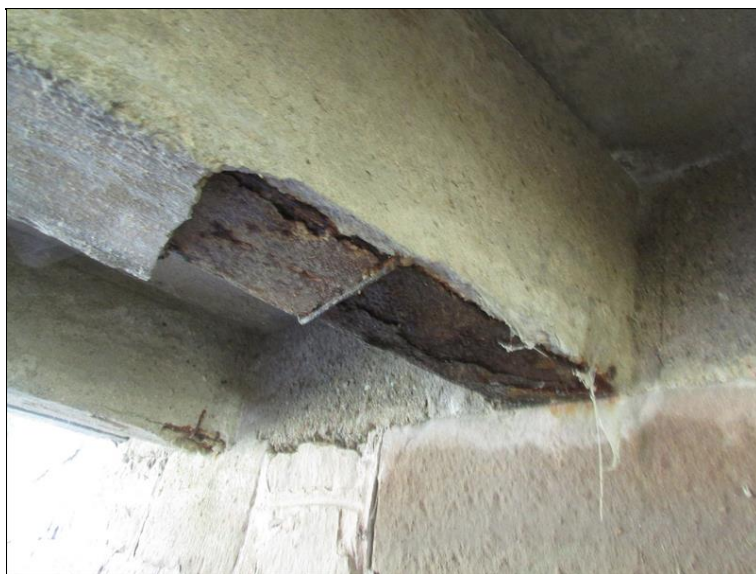
Podhled NK - trémová konstrukce - odpadlý beton, koroze ocelového profilu
