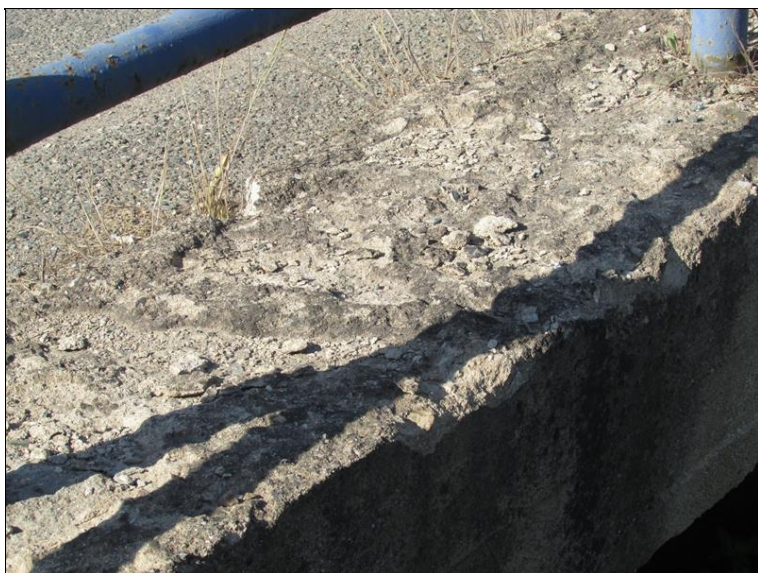
Degradace povrchu říms
