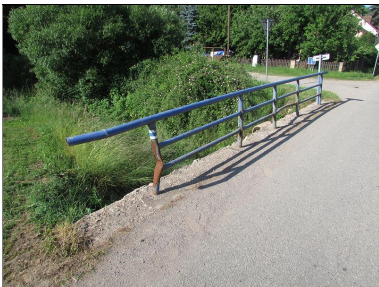
Deformace zábradlí na levé straně
