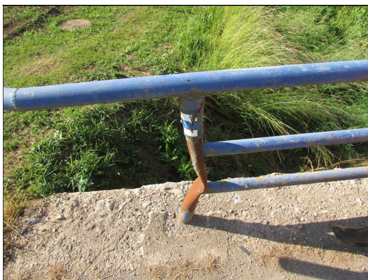
Deformace zábradlí na levé straně mostu
