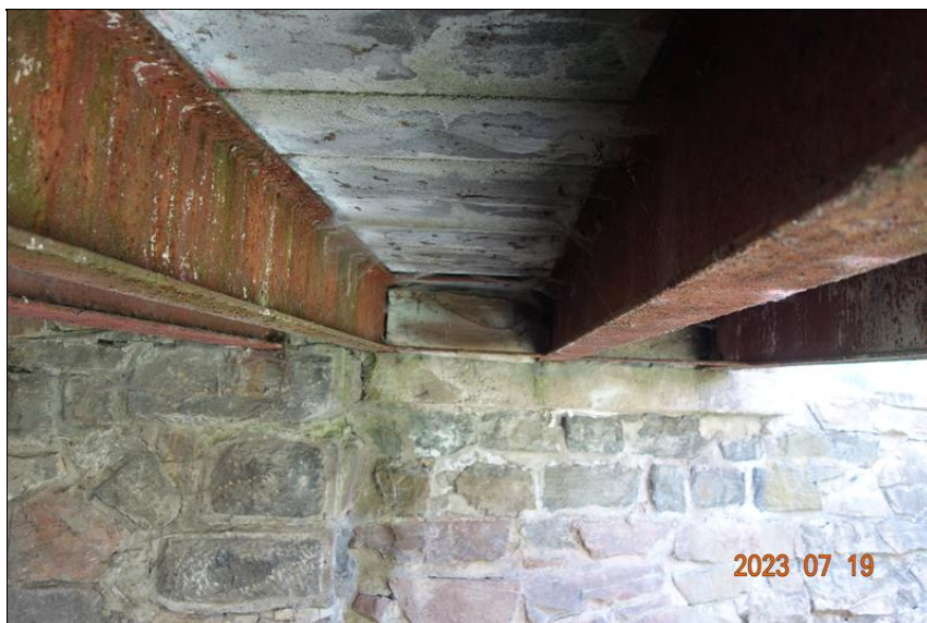
Koroze ocelových nosníků NK
