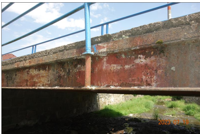
Koroze ocelových nosníků NK
