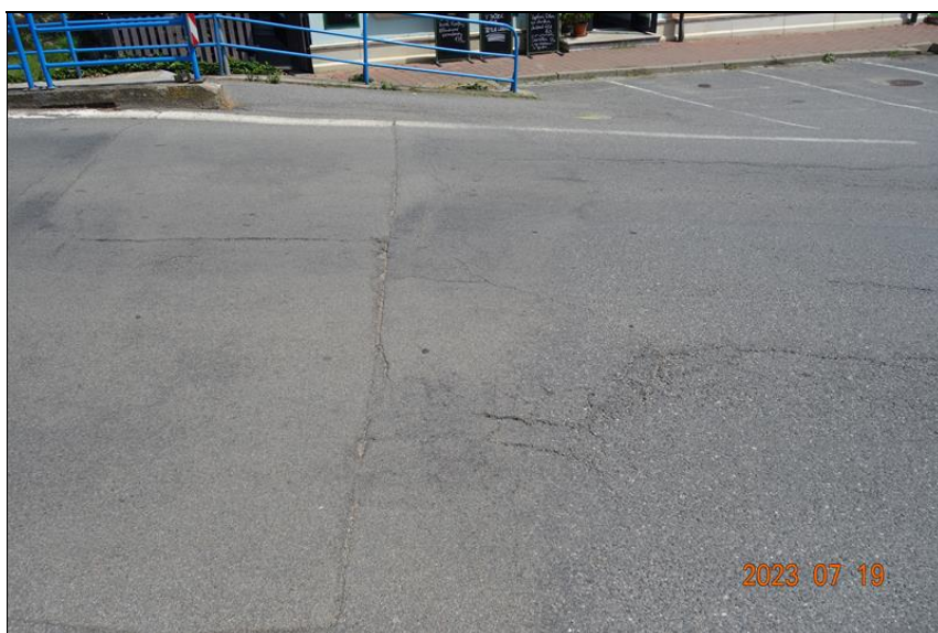
Trhliny a spáry ve vozovce nad opěrou 2
