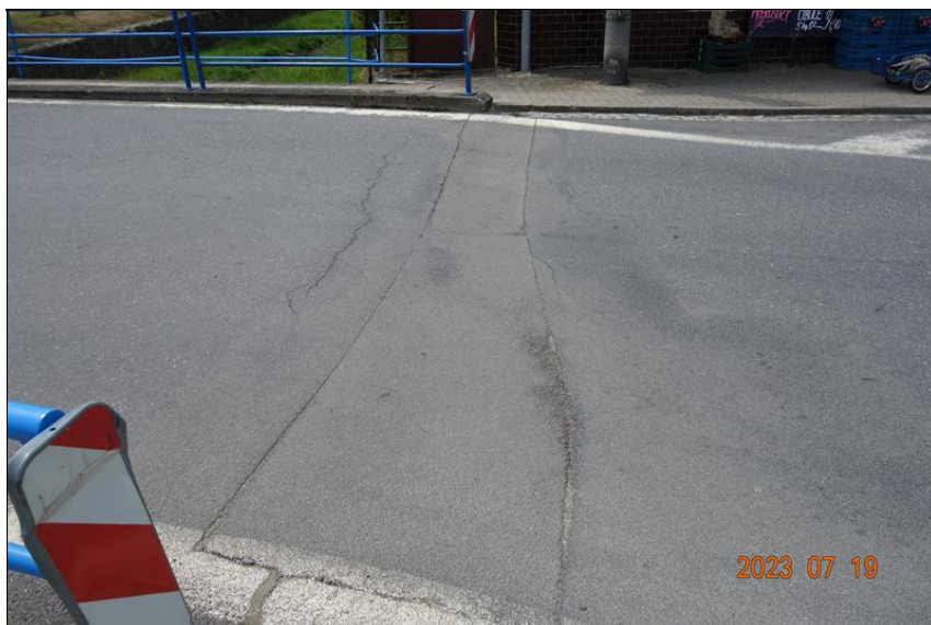
Trhliny a spáry ve vozovce nad opěrou 1
