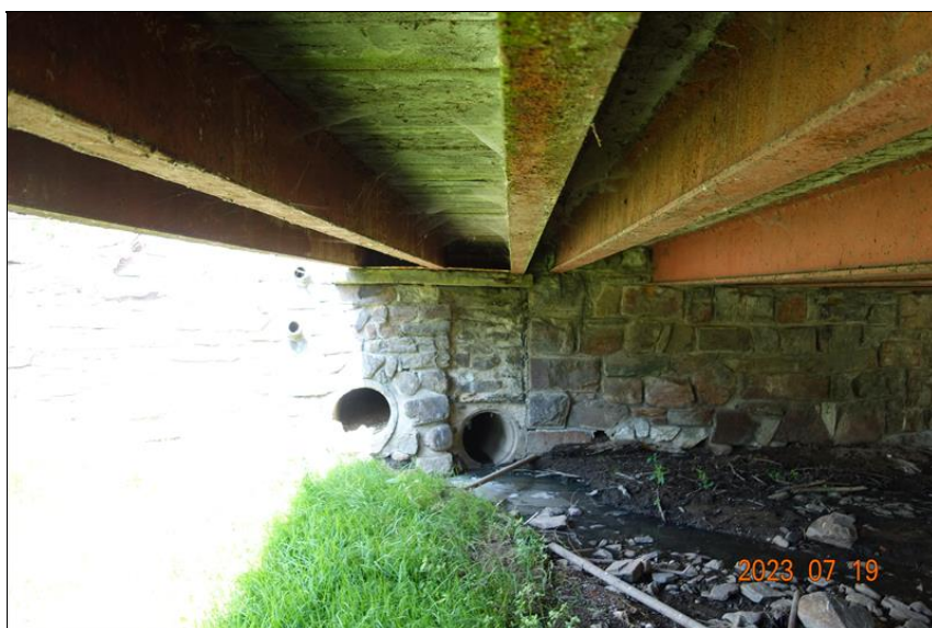
Opěra 1 - vpravo pod chodníkovou částí s vyústěním kanalizace
