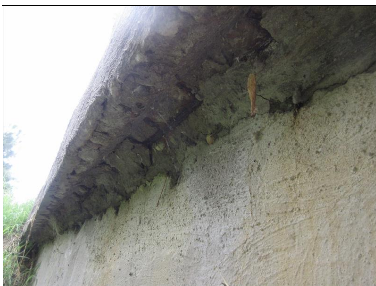
Na podhledu nosu římsy je zřetelné špatné probetonování římsy s odhalenou korodující výztuží
