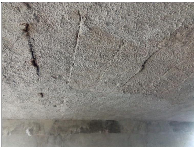
Podhled NK - geometrické nepřesnosti, ve spáře patrný průsak
