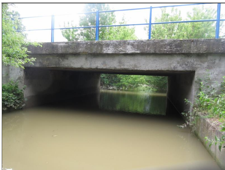
Návodní strana mostu - na mostní opěry navazují zídky k blízkému zařízení na regulaci toku
