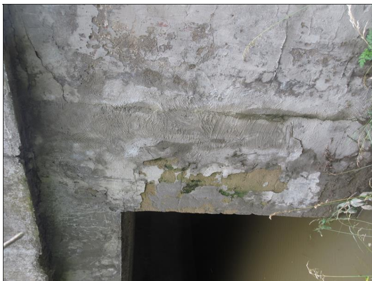
Uhersko-Ostrožská opěra na povodní straně - stopy po průsacích a stékání vody včetně uchycených mečů
