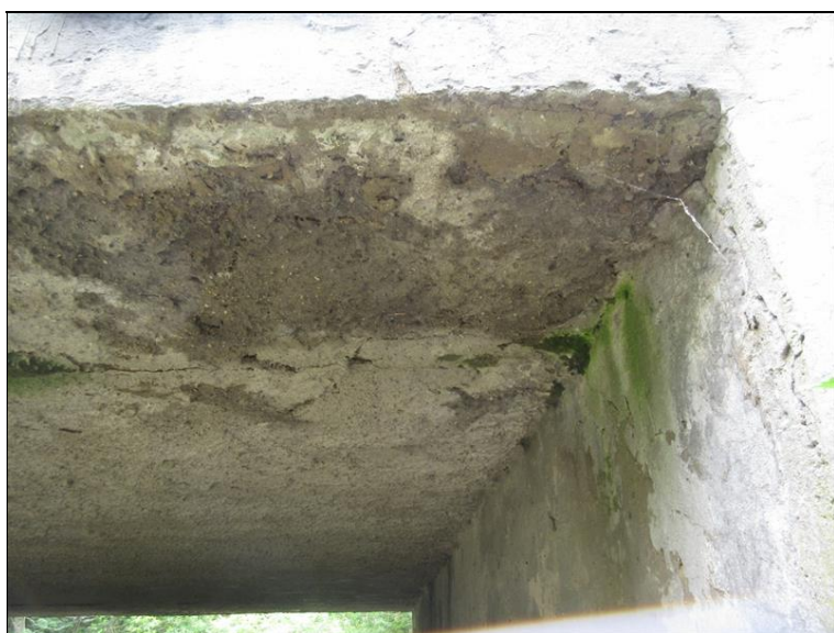
Trhlina je na nároží na návodní straně Písecké opěry pod uložením krajního nosníku
