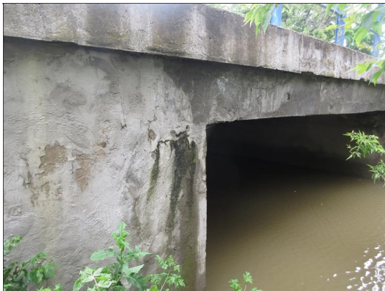
Uhersko-Ostrožská opěra na návodní straně - stopy po průsacích a stékání vody včetně uchycených mečů
