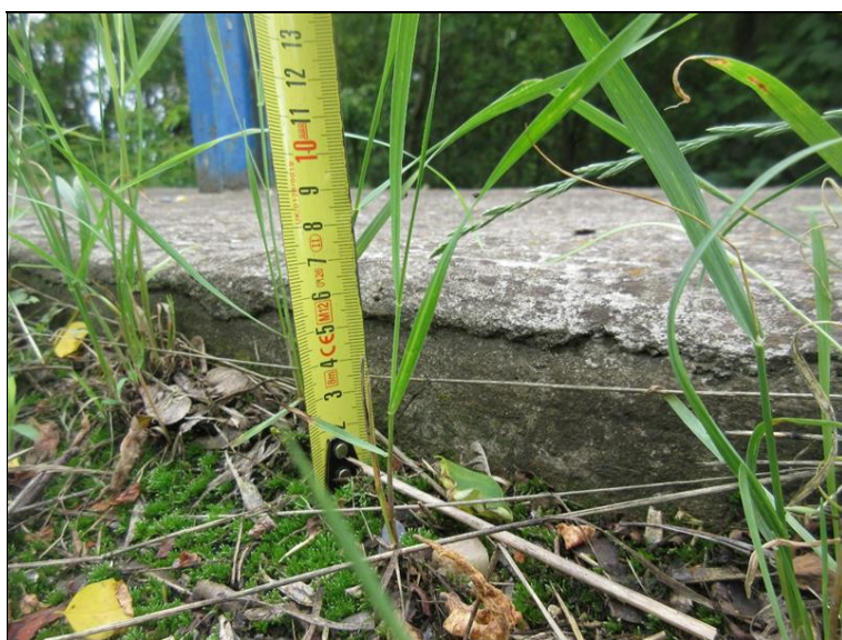
Podél římsy jsou nánosy usazenin s vegetací, výška římsy činí nedostačujících 6cm
