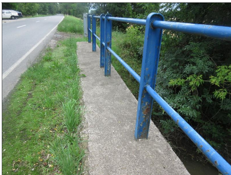
Podél římsy jsou nánosy usazenin s vegetací, sanace odmrzá a rozpadá se. Most by měl být opatřen zábradelním svodidlem.
