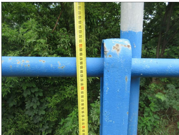
Zábradlí dosahuje lokálně výšky pouze 107cm
