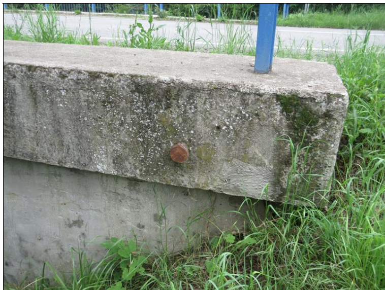
Na povodní straně mostu Ostrožského křídla je na římse osazena nivelační značka
