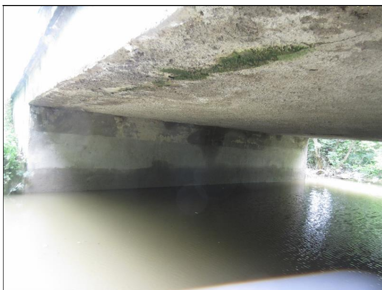
Krajní nosník na návodní straně - stopy po zatékání, na hraně výluhy a inkrustace od stékající vody
