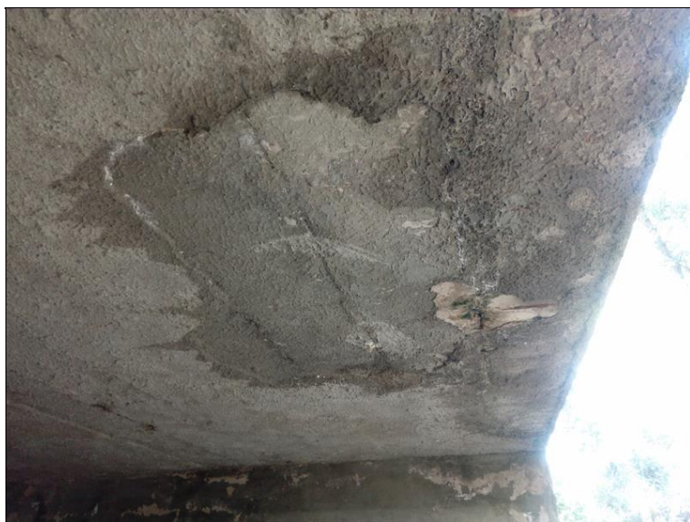
Krajní nosník na povodní straně - stopy po zatékání, odpadlá sanační omítka a jsou odhaleny dva kusy betonářské výztuže s produkty koróze
